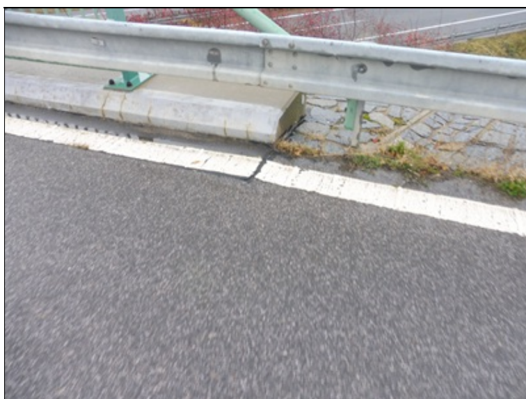
Poklesnutí vozovky u OP1 vpravo.
