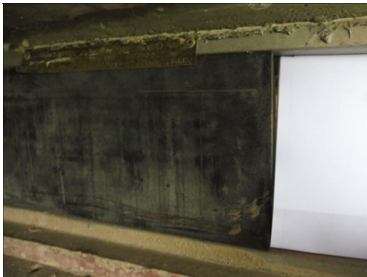
Ložisko OP4 L, podélné zkosení.
