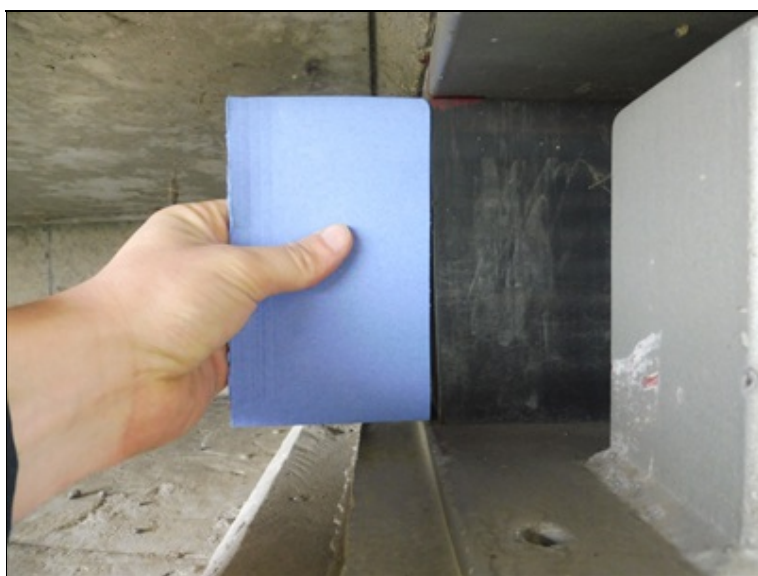
Ložisko OP1 P, příčné zkosení.
