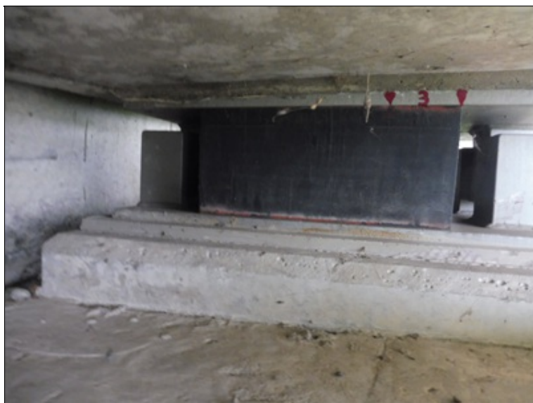
Ložisko OP1 P, podélné zkosení.
