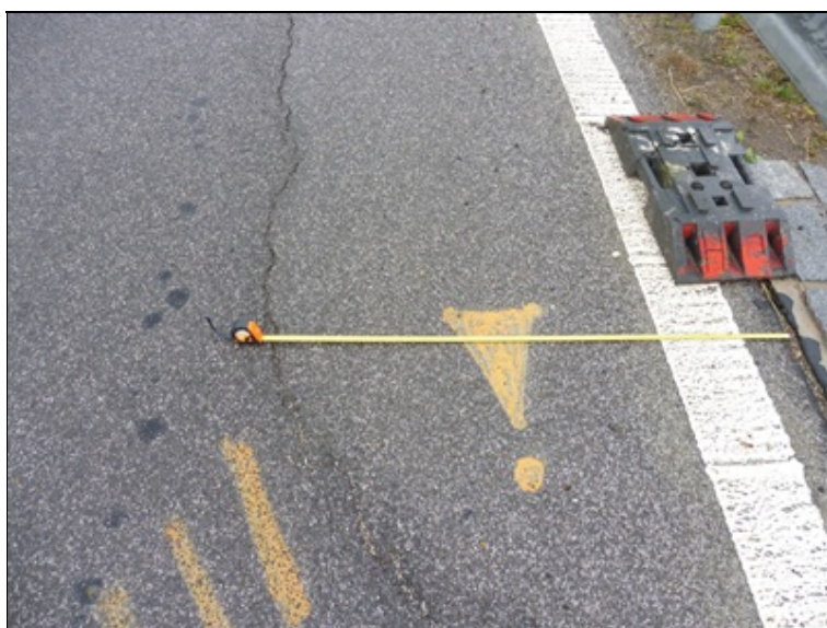
Prosednutí vozovky u OP1 vlevo.
