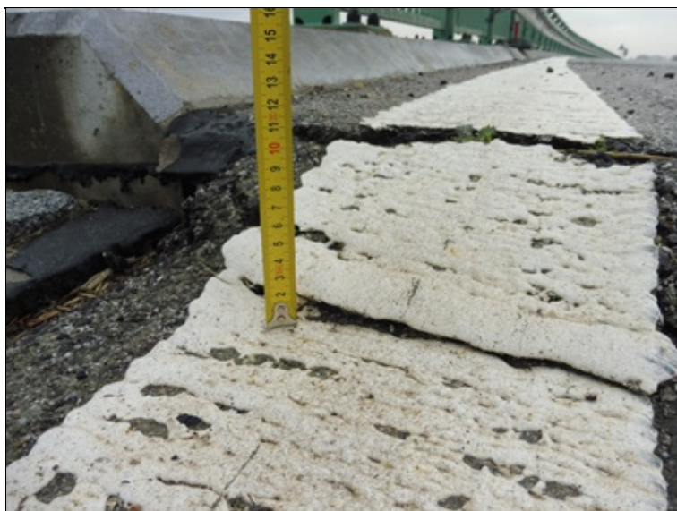
Prosednutí vozovky u OP1 vlevo.
