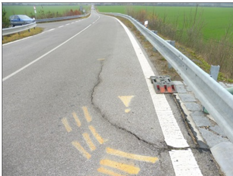
Prosednutí vozovky u OP1 vlevo.
