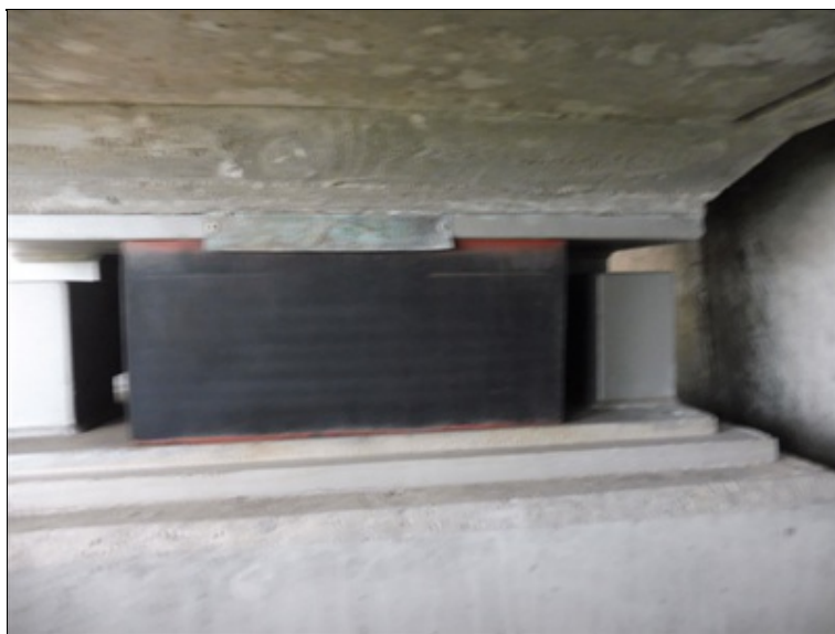
Ložisko OP1 L, podélné zkosení.
