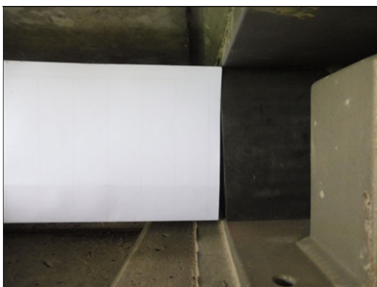
Ložisko OP4 L, příčné zkosení.
