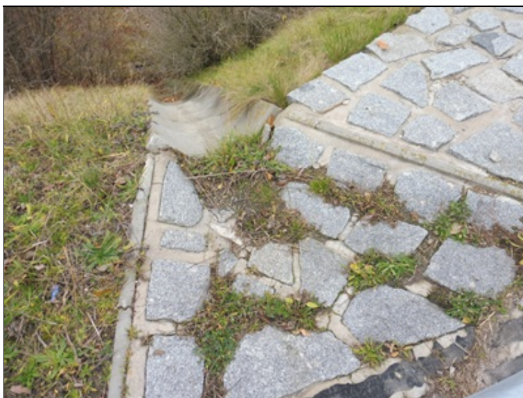
Skluz odvodnění u OP4 P.
