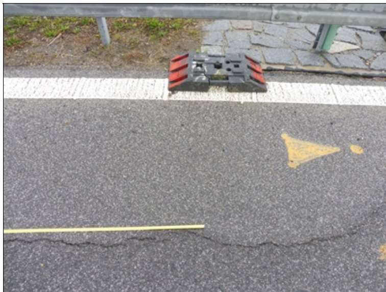
Prosednutí vozovky u OP1 vlevo.
