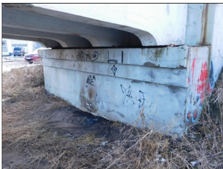
Pohled na opěru 1.
