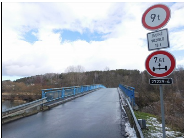
Pohled na most ve směru staničení.
