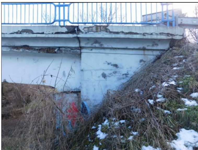
Pohled na levé křídlo opěry 1.
