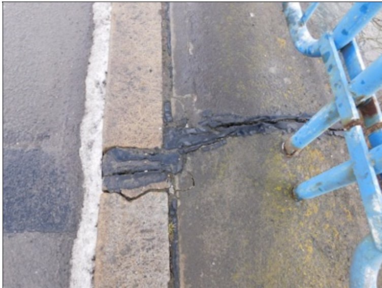
Otevřená spára v římsě - nefunkční zálivka.
