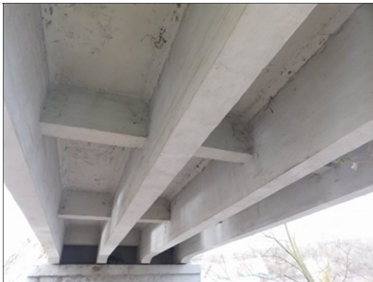
Podhled nosné konstrukce v poli 3.
