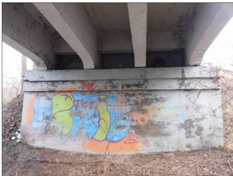
Pohled na opěru 4.
