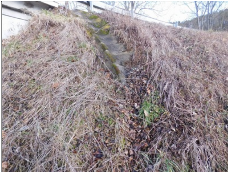
Zarostlý odvodňovací skluz.
