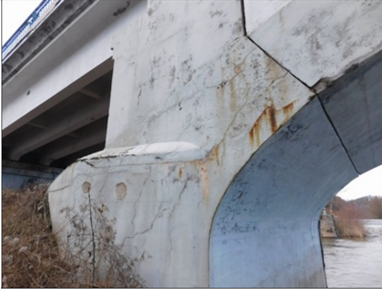
Pohled na pilíř 2 zprava.
