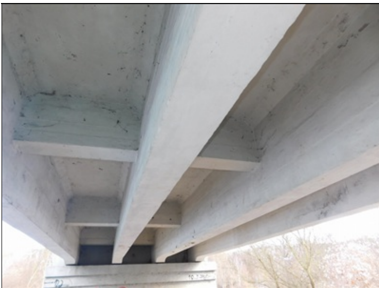
Podhled nosné konstrukce v poli 1.
