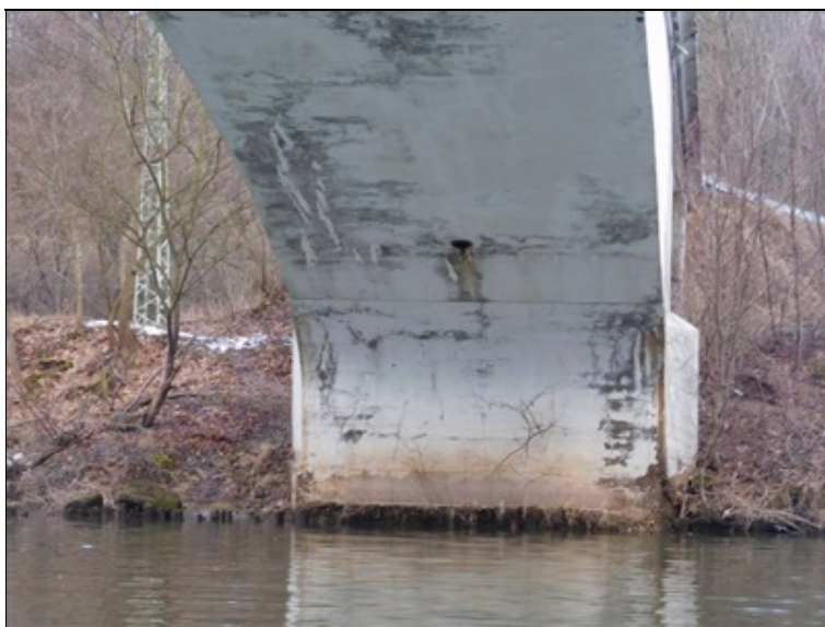
Pohled na pilíř 3.
