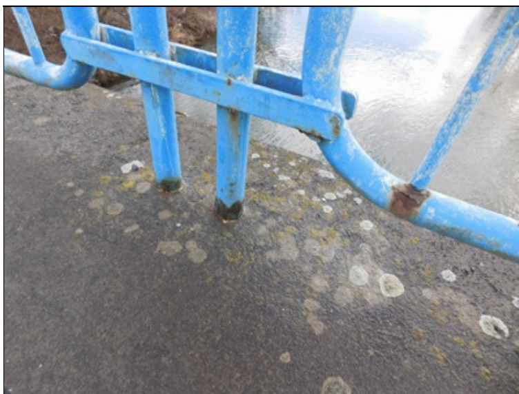
Koroze zábradlí.
