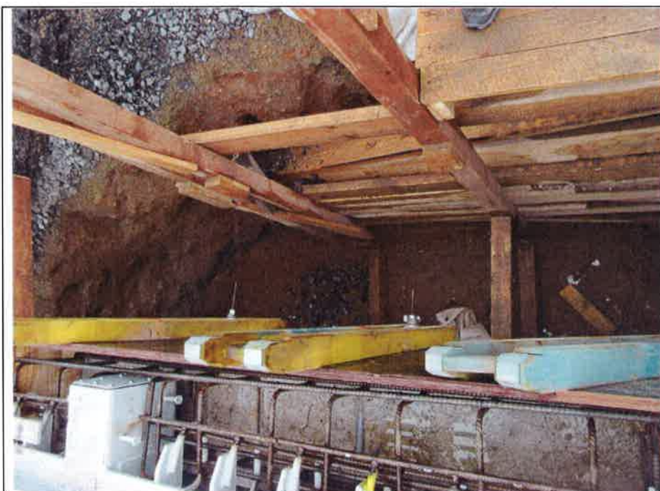
zajištění výkopu za opěrou 2
