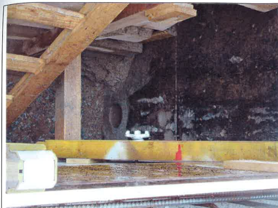
vývrt pro vyústění drenáže za opěrou
