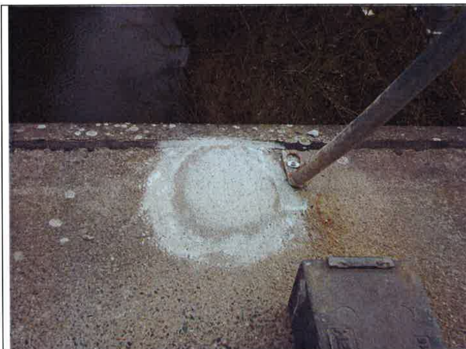
sanace otvoru po vybourání sloupku zábradlí
