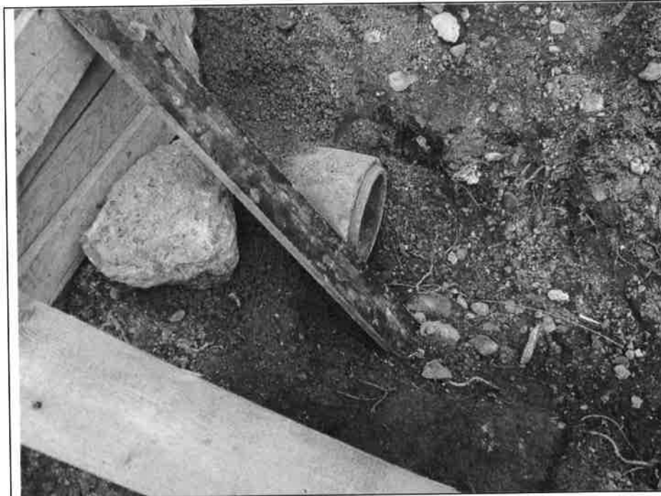
nové vyústění kanalizace
