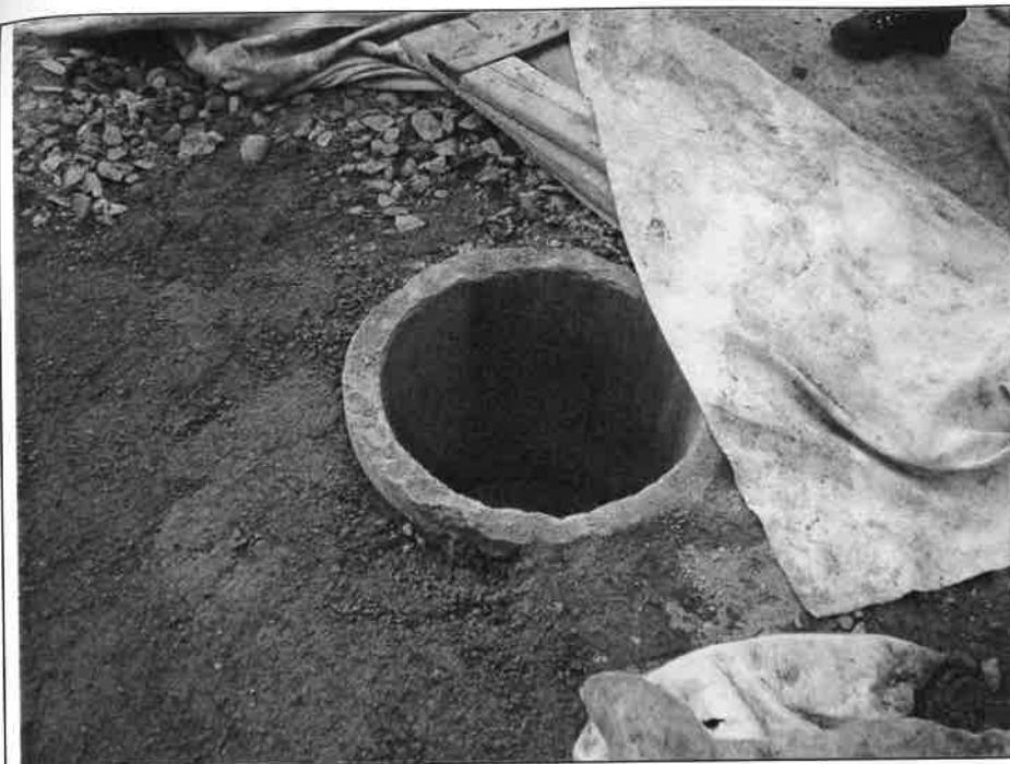
obnovená kanalizační vpust'
