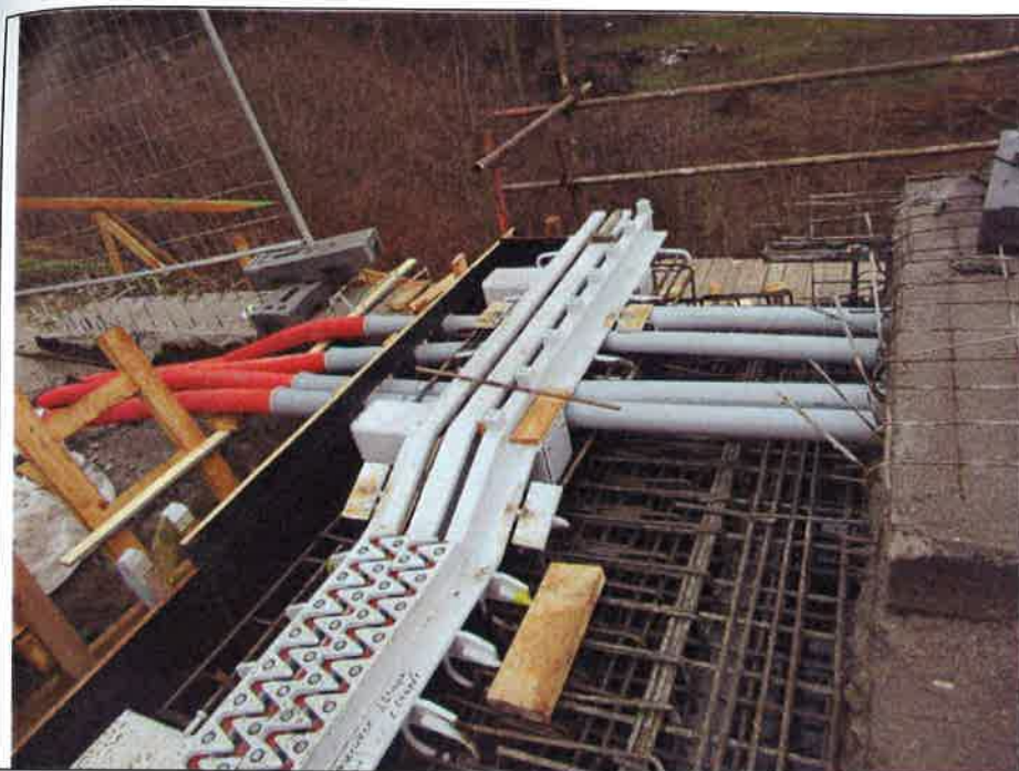
průchod chrániček mostním závěrem – opěra 2
