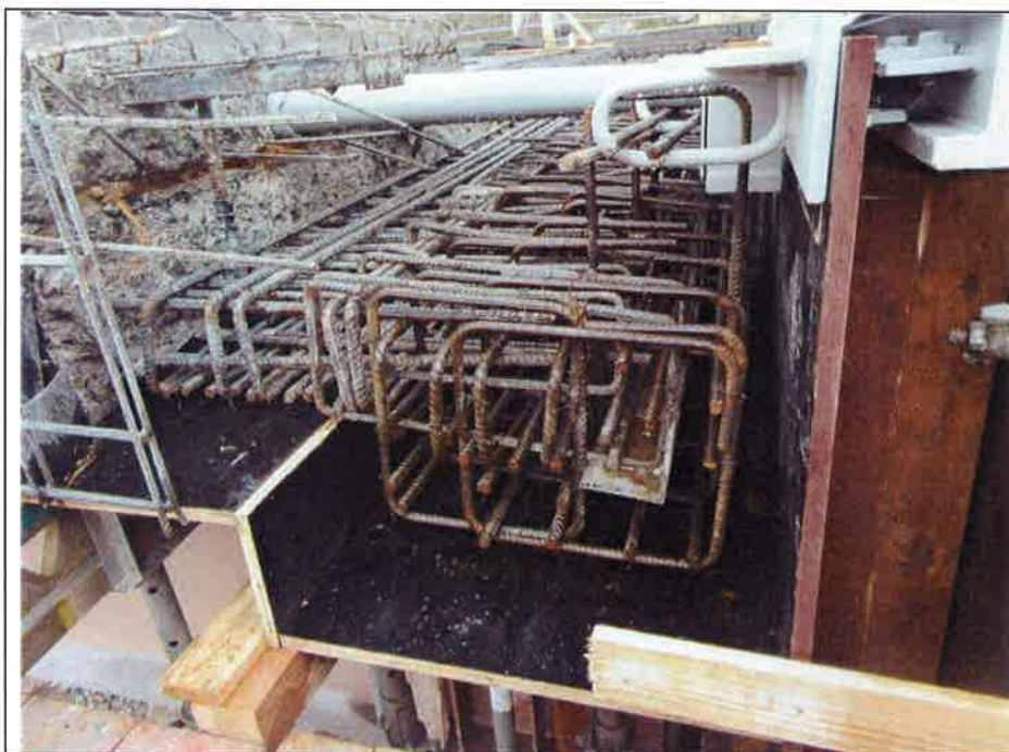
výztuž dobetonování desky NK
