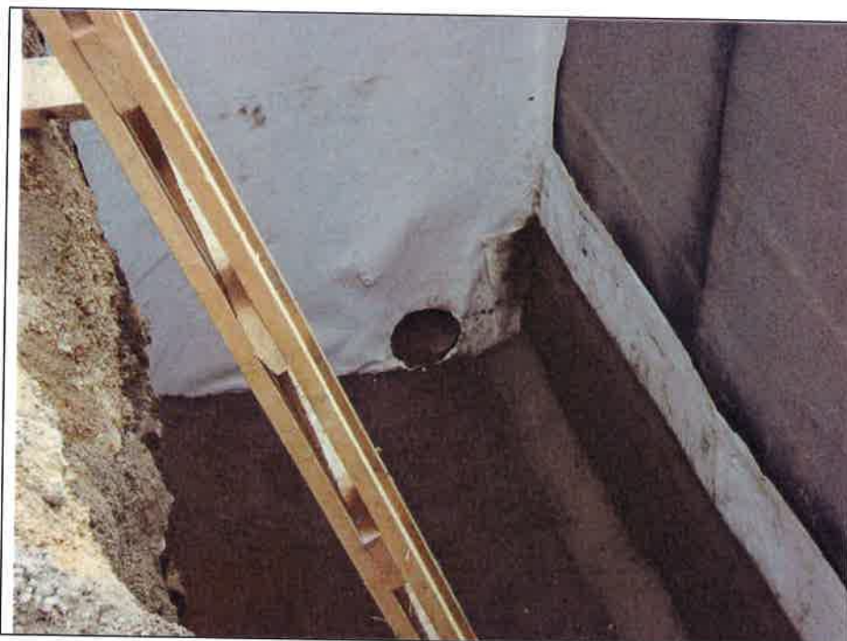
otvor v křídle pro vyústění drenáže za opěrou 2
