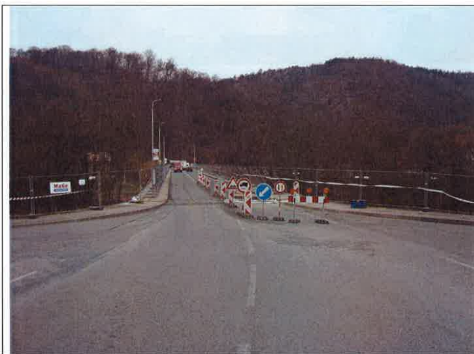
stav DIO opěra č. 1 – směr Roztoky
