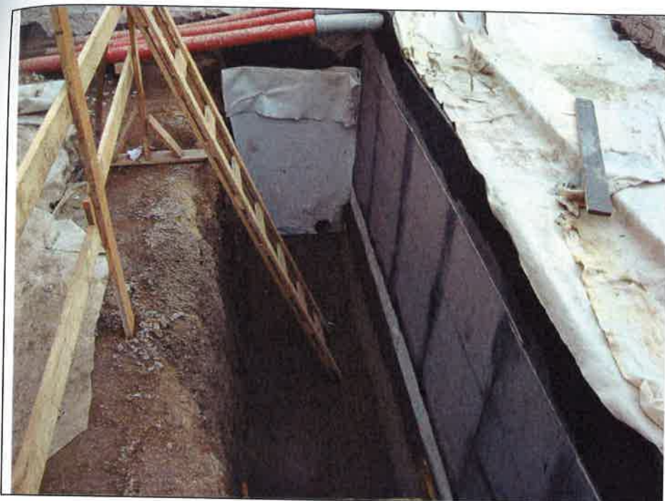
stav výkopu za opěrou 2
