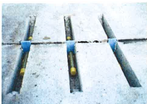
Instalace kluzných trnů před vyplněním zářezů, viditelné osazení pružných vložek
