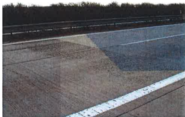
Odstranění schůdku na příčné spáře frézou
