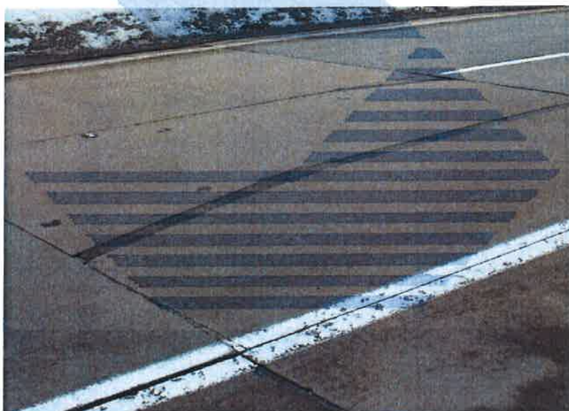
Úprava pasivní trhliny prořezáním a utěsněním zálivkovou hmotou
