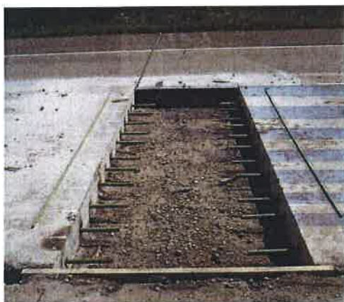
Průběh výměny části desky u příčné spáry (vlevo osazení kluznými trny, vpravo kotvami)
