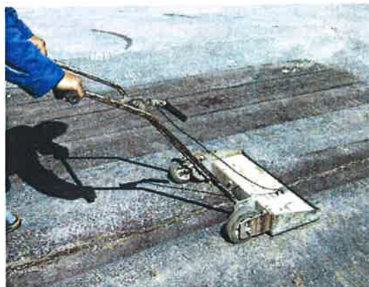
Sesbírání zbylých ocelových kuliček magnetickým sběračem
