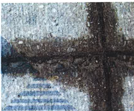
Porušení na příčné a podélné spáře způsobené frézou na šířku a hloubku 40 až 50 mm
