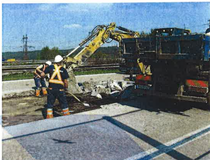
Vybourání starých betonových desek
