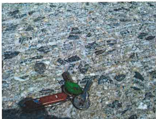
Stav povrchu po frézování
