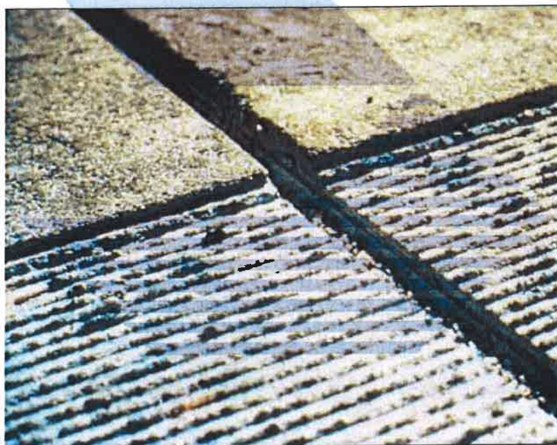
Příklad broušení jednoho jízdního pruhu
