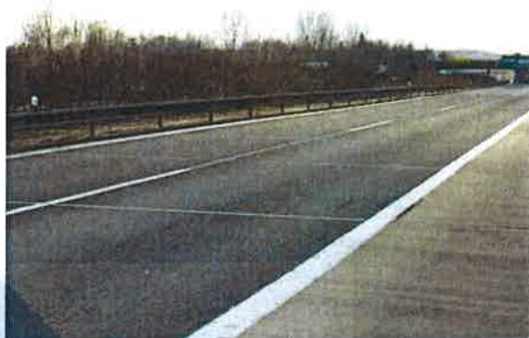
Přiznání spár na mikrokoberci - prořezané a utěsněné spáry
