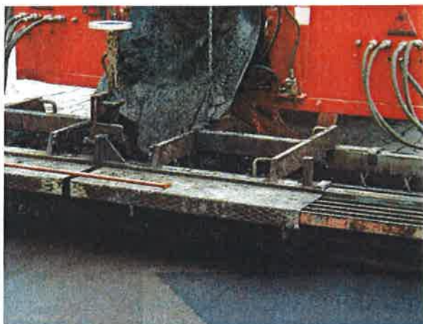
Pohled na úpravu po rozprostření mikrokoberce
