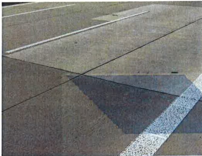
Plošná vysprávka do hloubky 50 mm na několika deskách, jejichž povrch byl narušen požárem
