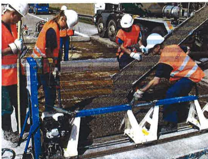
Betonáž jednotlivých nových desek
