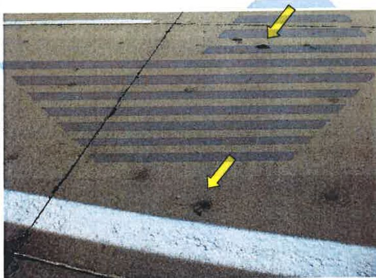
Viditelné otvory po kotvách zvedacího zařízení (šipky) a injektážních otvorech
