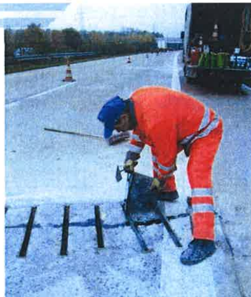
Průběh kotvení trhliny pomocí horizontálních kotev
