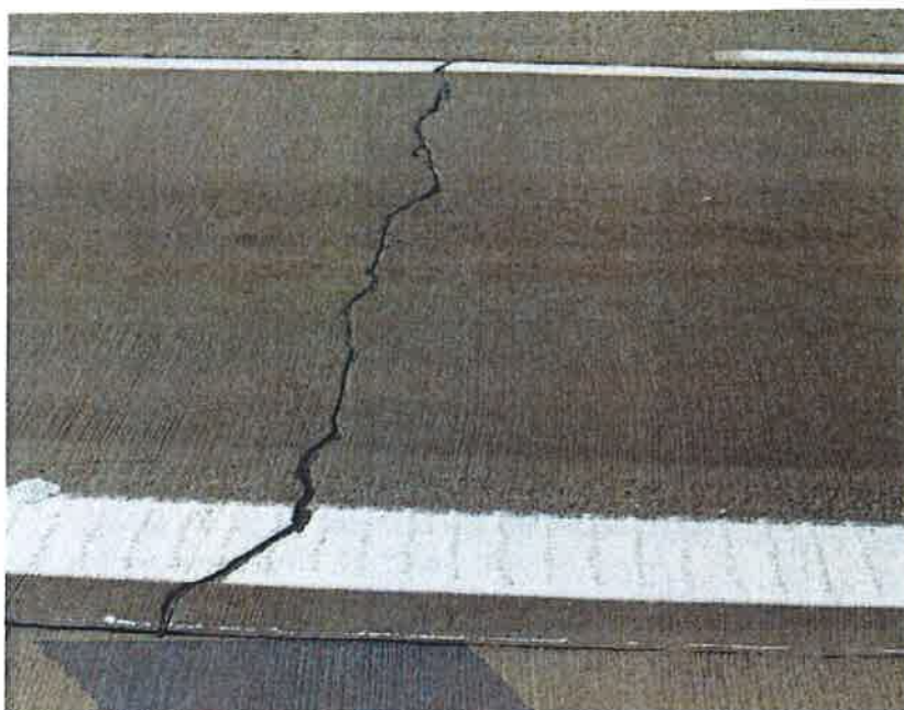
Utěsnění pasivní trhliny bez rozšíření
