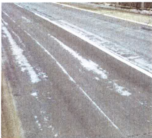
Opotřebení kalové vrstvy.
