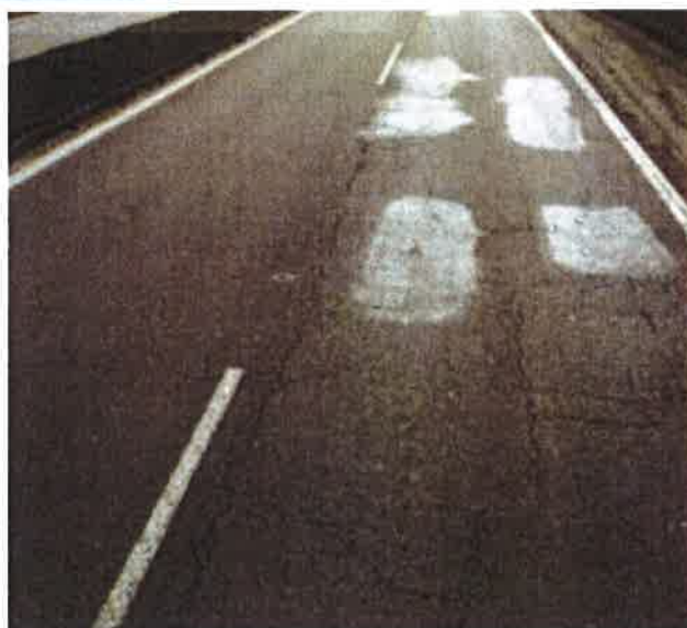
Prokopírování mozaikových trhlin přes nátěr.
