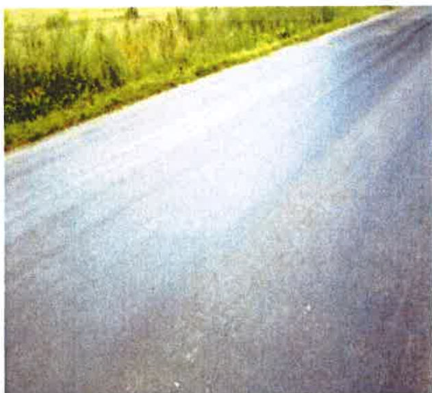
Ztráta makrotextury v celé šířce vozovky.
