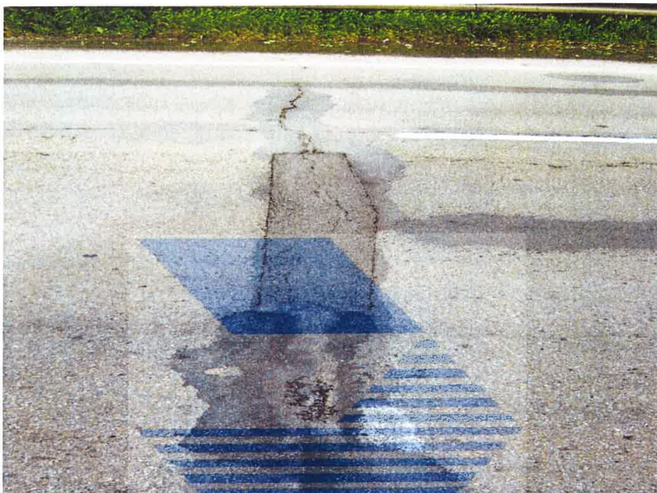
Prokopírování příčné trhliny s přidruženými trhlinami vysprávkou.
