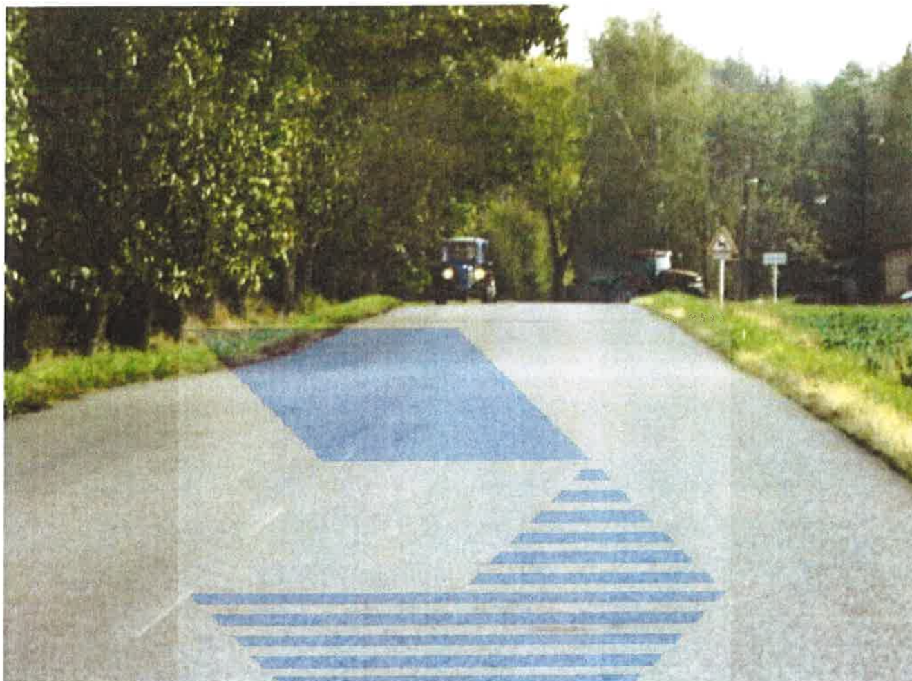
Pokles vzniklý poklesem zemního tělesa.
