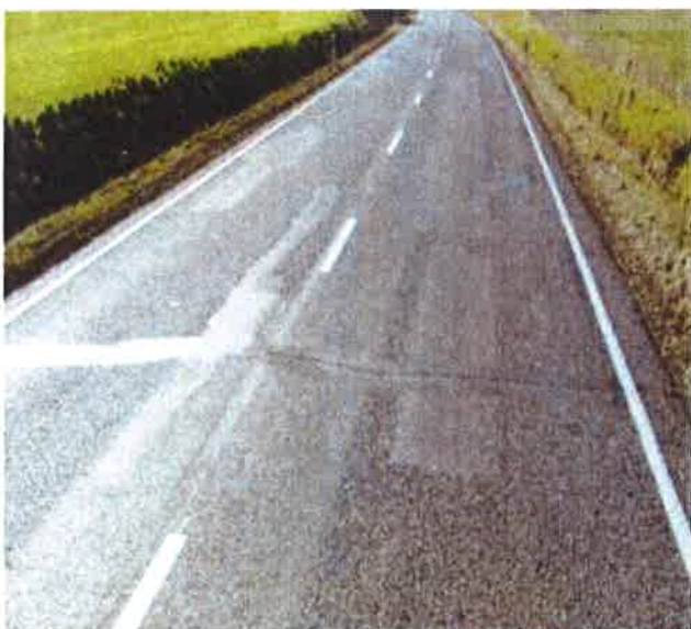
Příčná trhlina ošetřená nátěrem.
