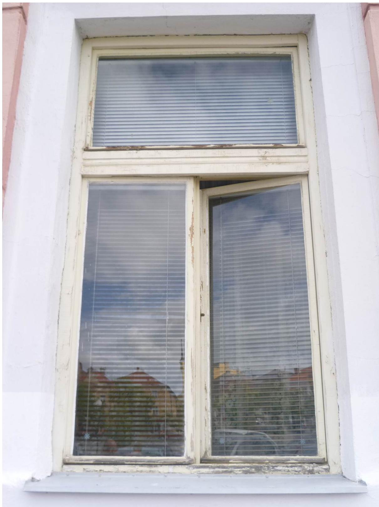
Obrázek 6 – současné špaletové okno - exteriér
