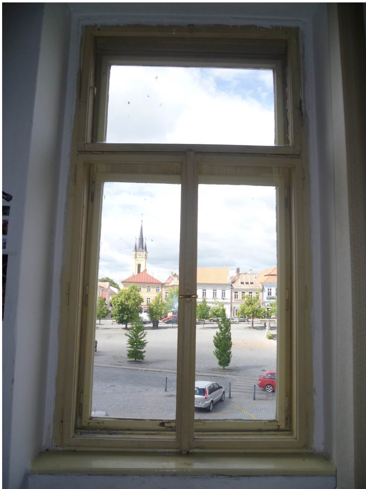
Obrázek 5 – současné špaletové okno - interiér
