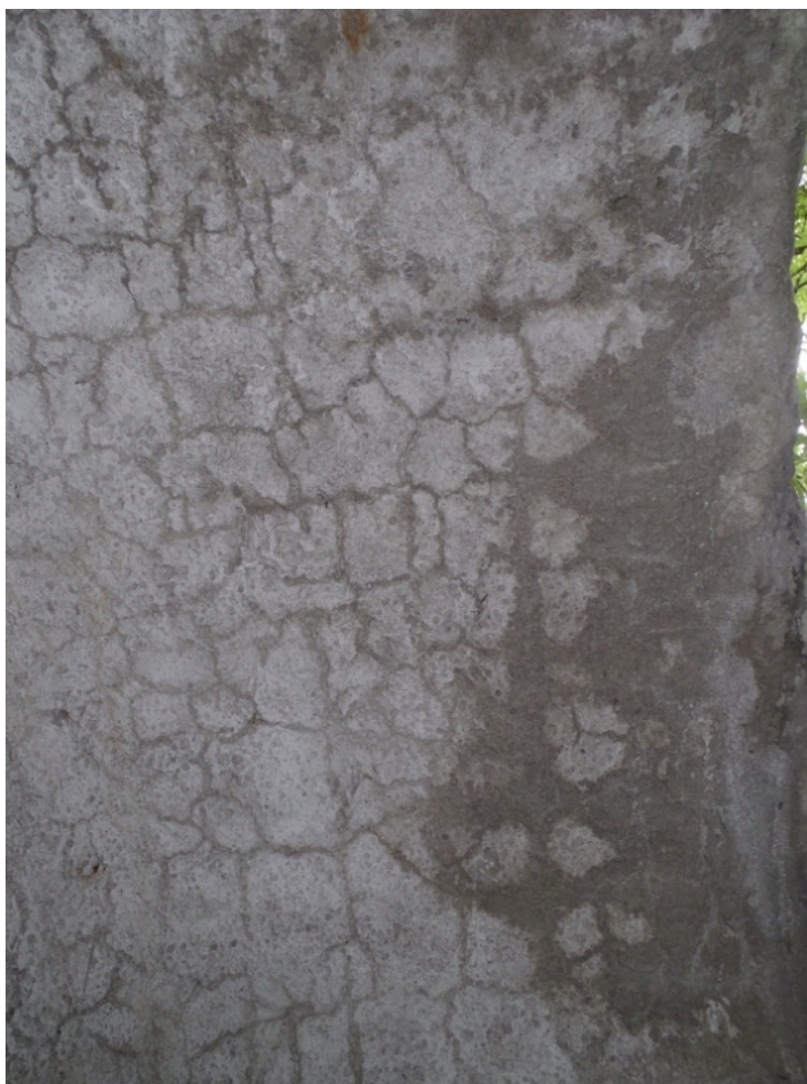
11 síť trhlin, poškození torkretu, výluhy na spodním líci konstrukce klenby směrem ze svahu
