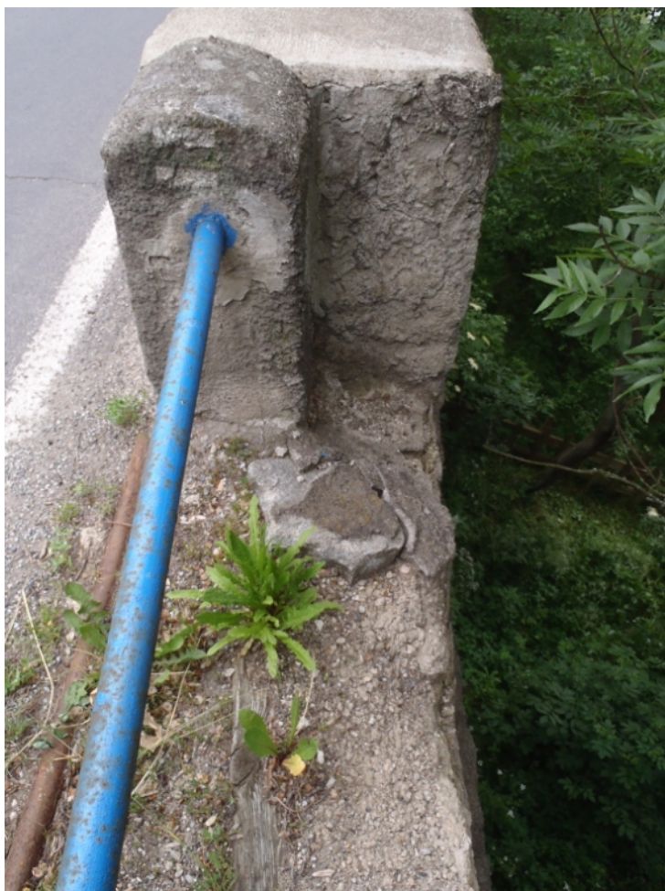
20 poruchy na horním líci římsy a parapetní zídky
