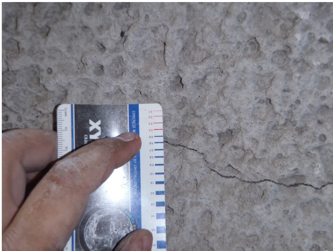
30 detail trhliny v torkretu - spodní líc klenby
