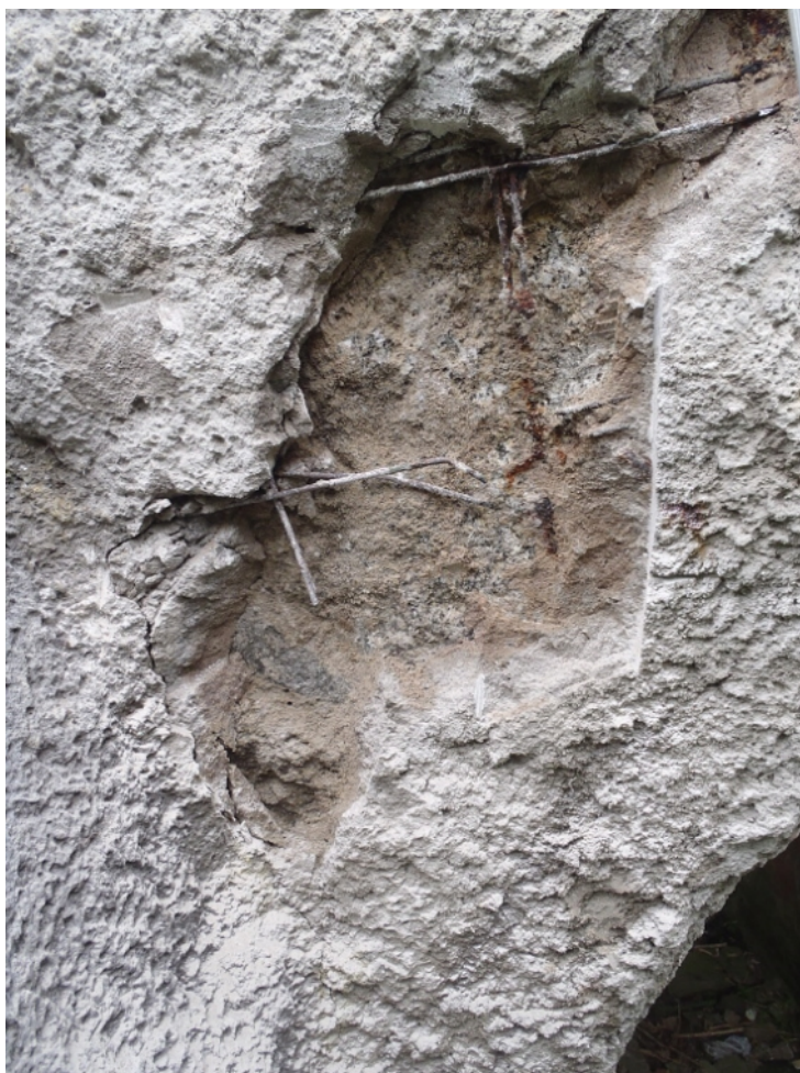
29 koroze výztuže ve vrstvě torkretu
