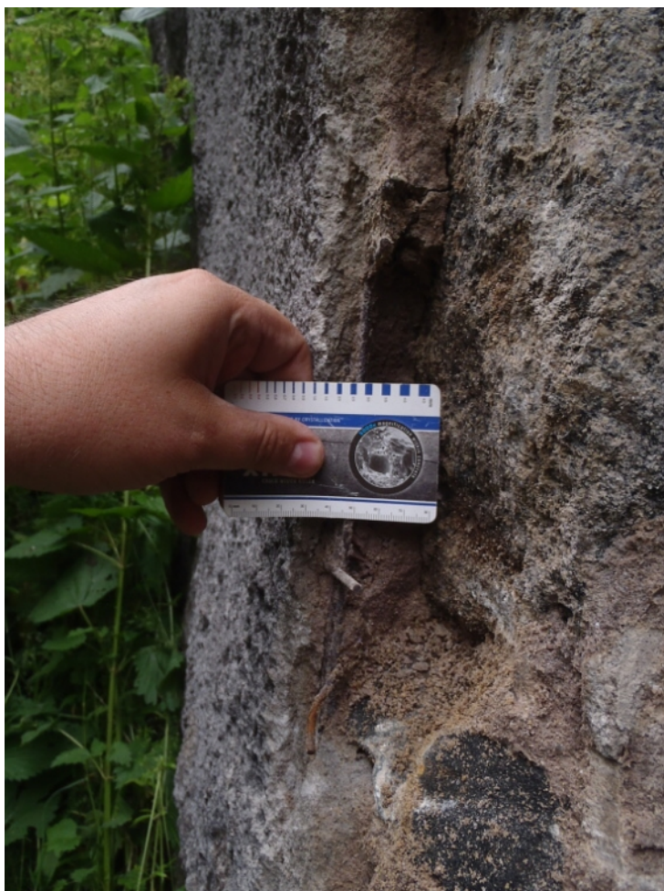
25 umístění sítě ve vrstvě torkretu
