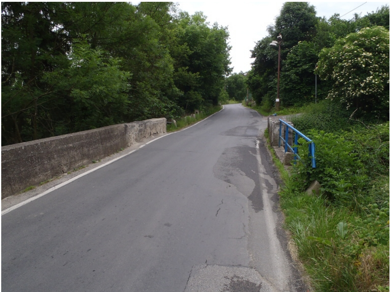
21 pohled na most proti směru staničení - poruchy vozovky
