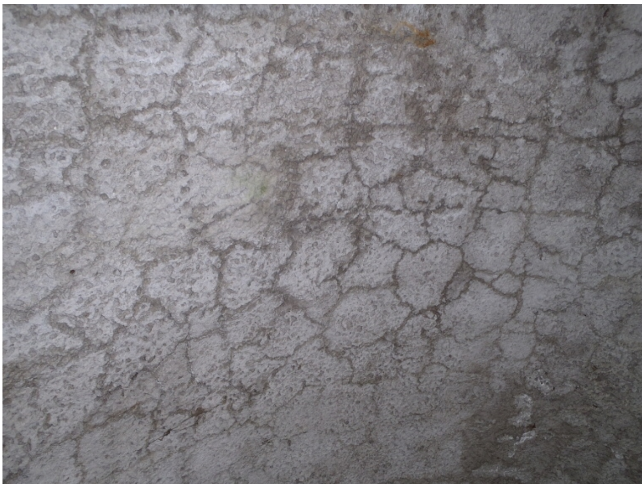
10 síť trhlin na spodním líci konstrukce klenby směrem ze svahu - detail
