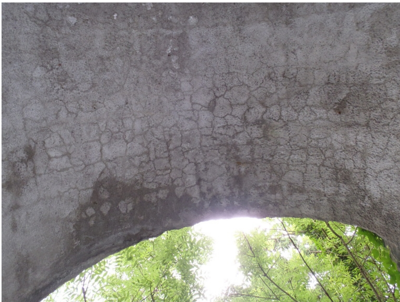
09 síť trhlin na spodním líci konstrukce klenby směrem ze svahu
