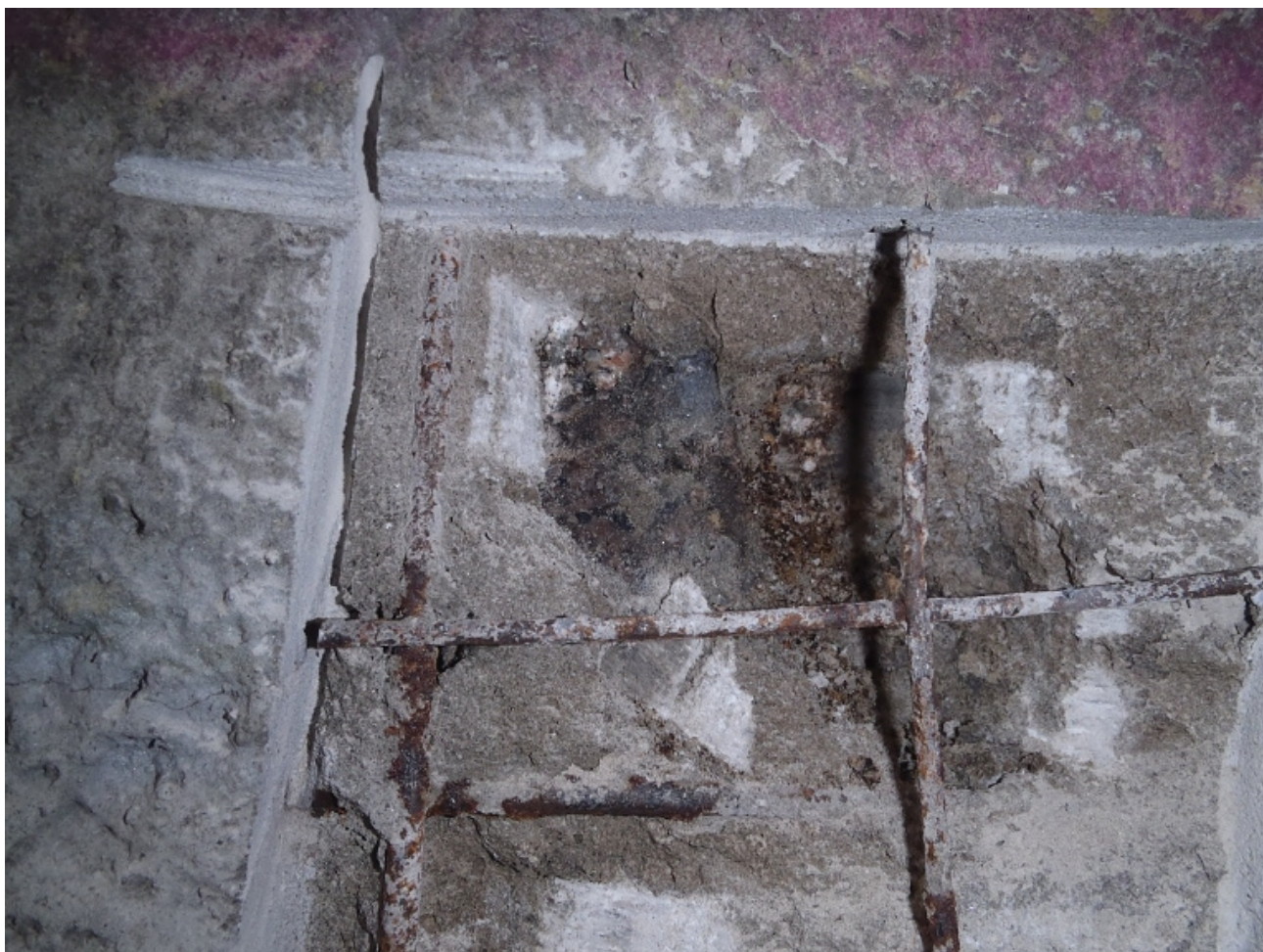
28 koroze výztuže ve vrstvě torkretu
