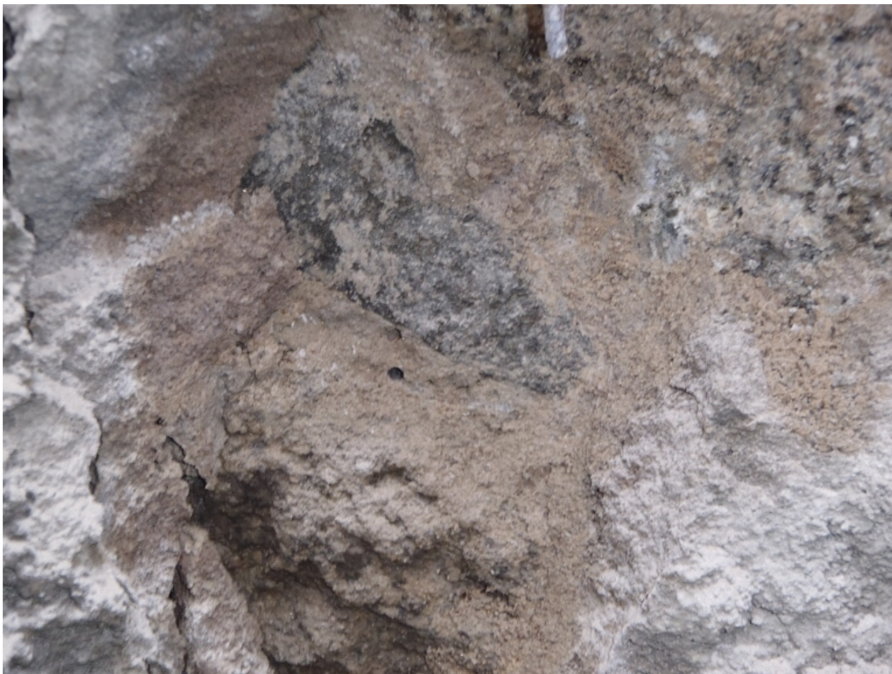
27 snížená kvalita vrstvy pod sítí a její plné nasycení vodou - detail
