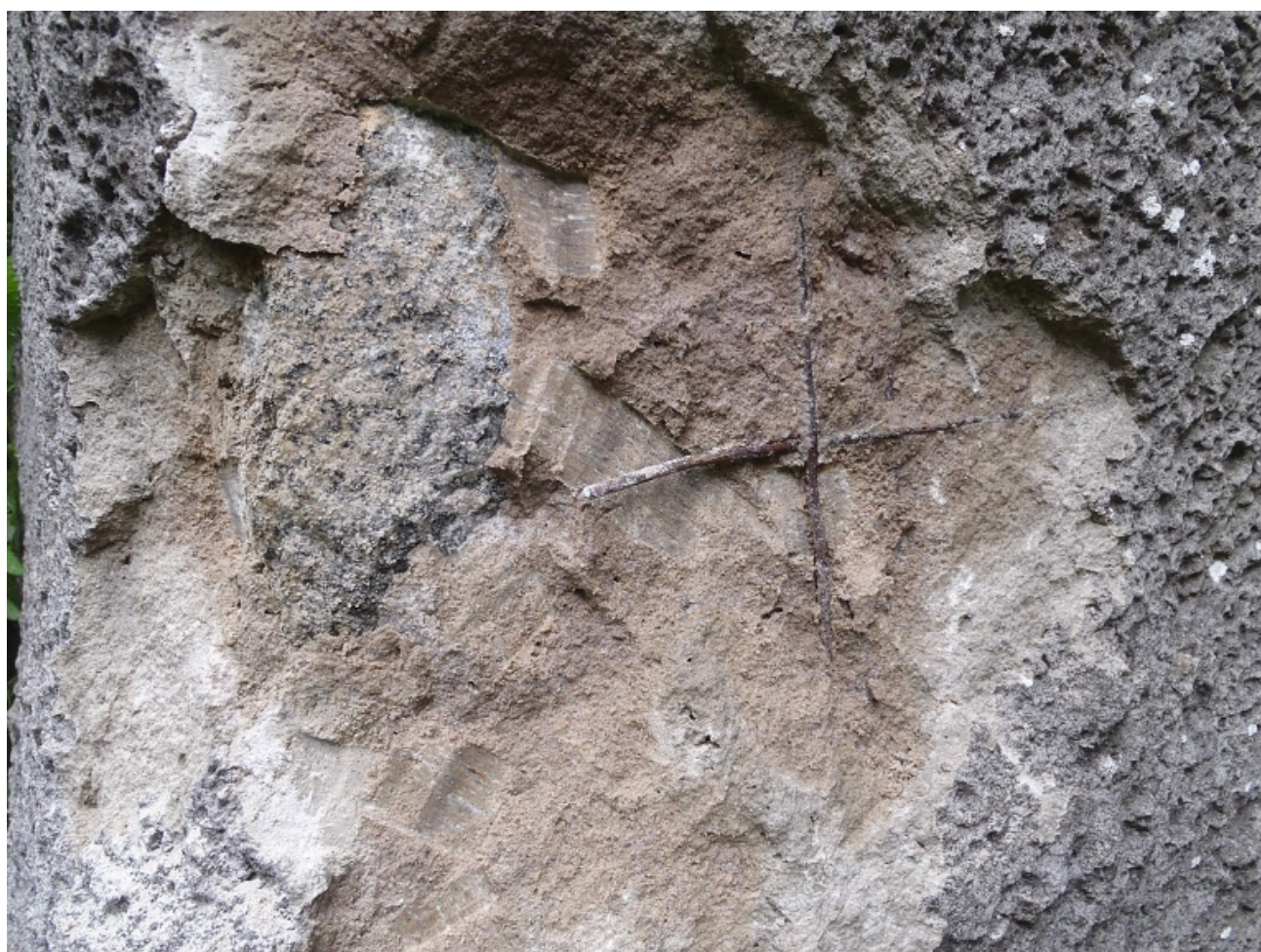
24 umístění sítě ve vrstvě torkretu
