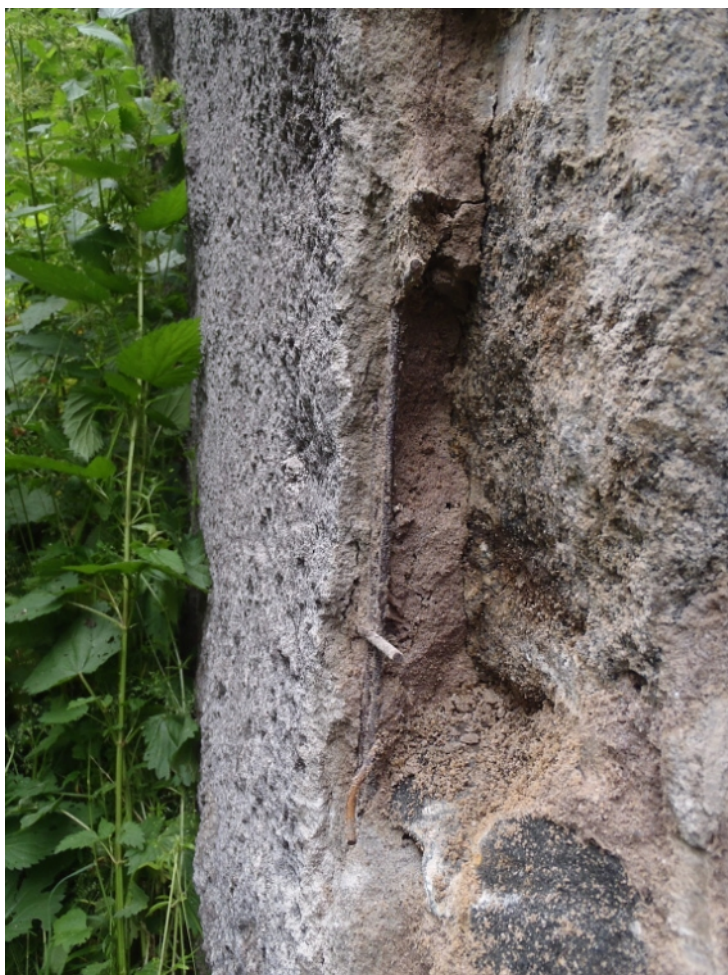
26 snížená kvalita vrstvy pod sítí a její plné nasycení vodou
