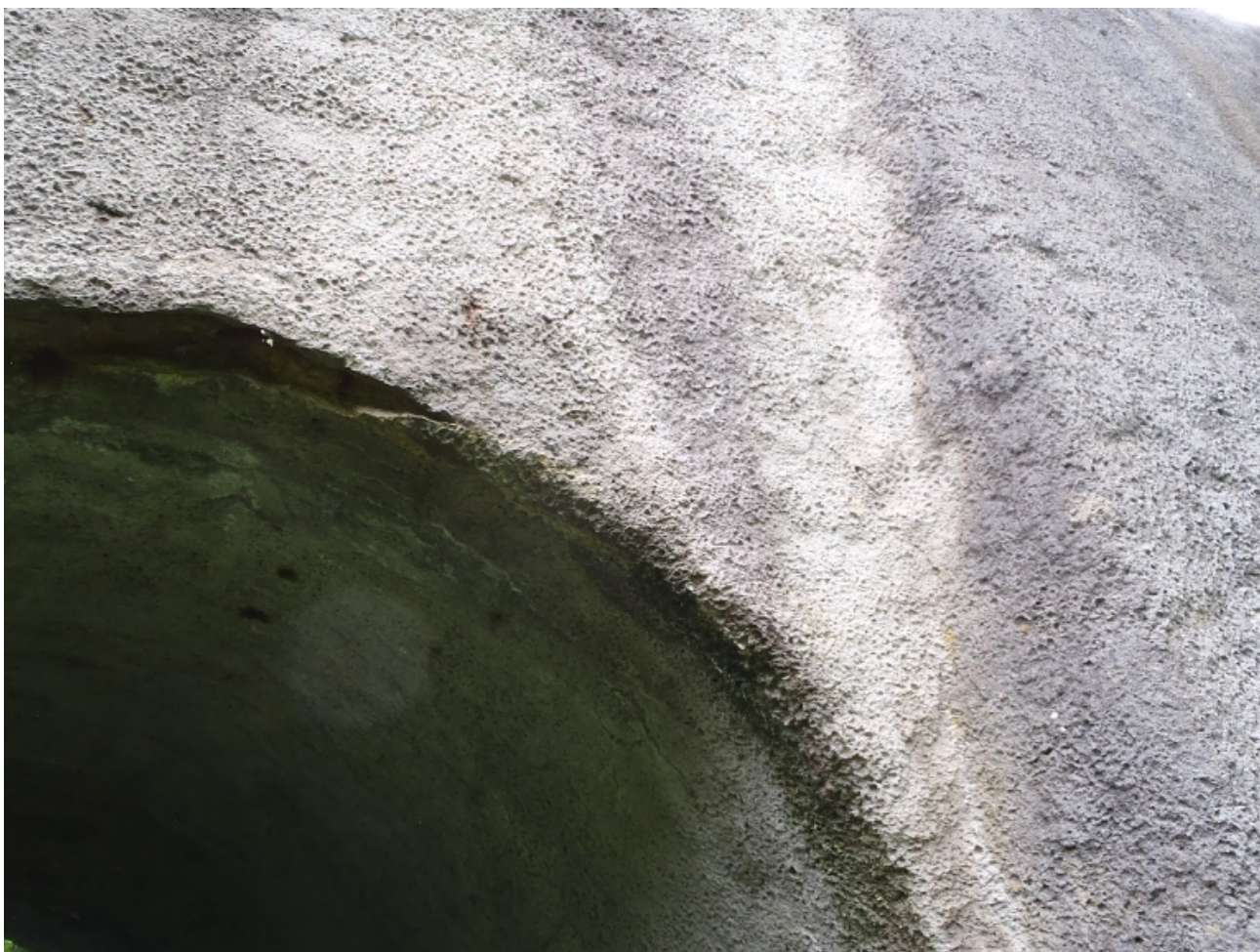
08 trhliny a výluhy na klenbě směrem do svahu
