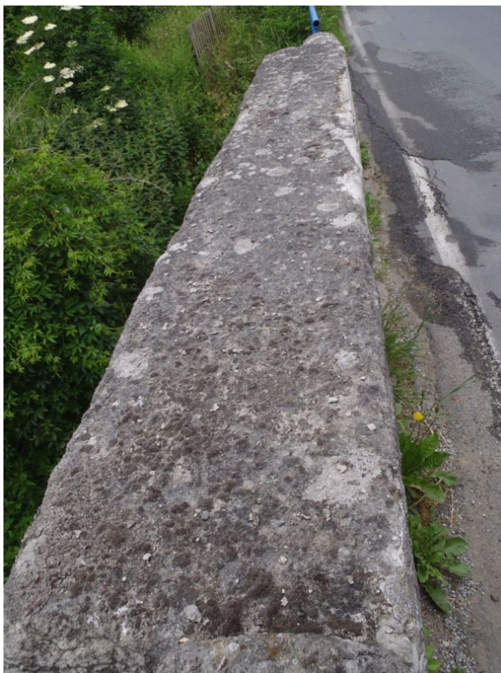
19 povrchová degradace na parapetní zídce
