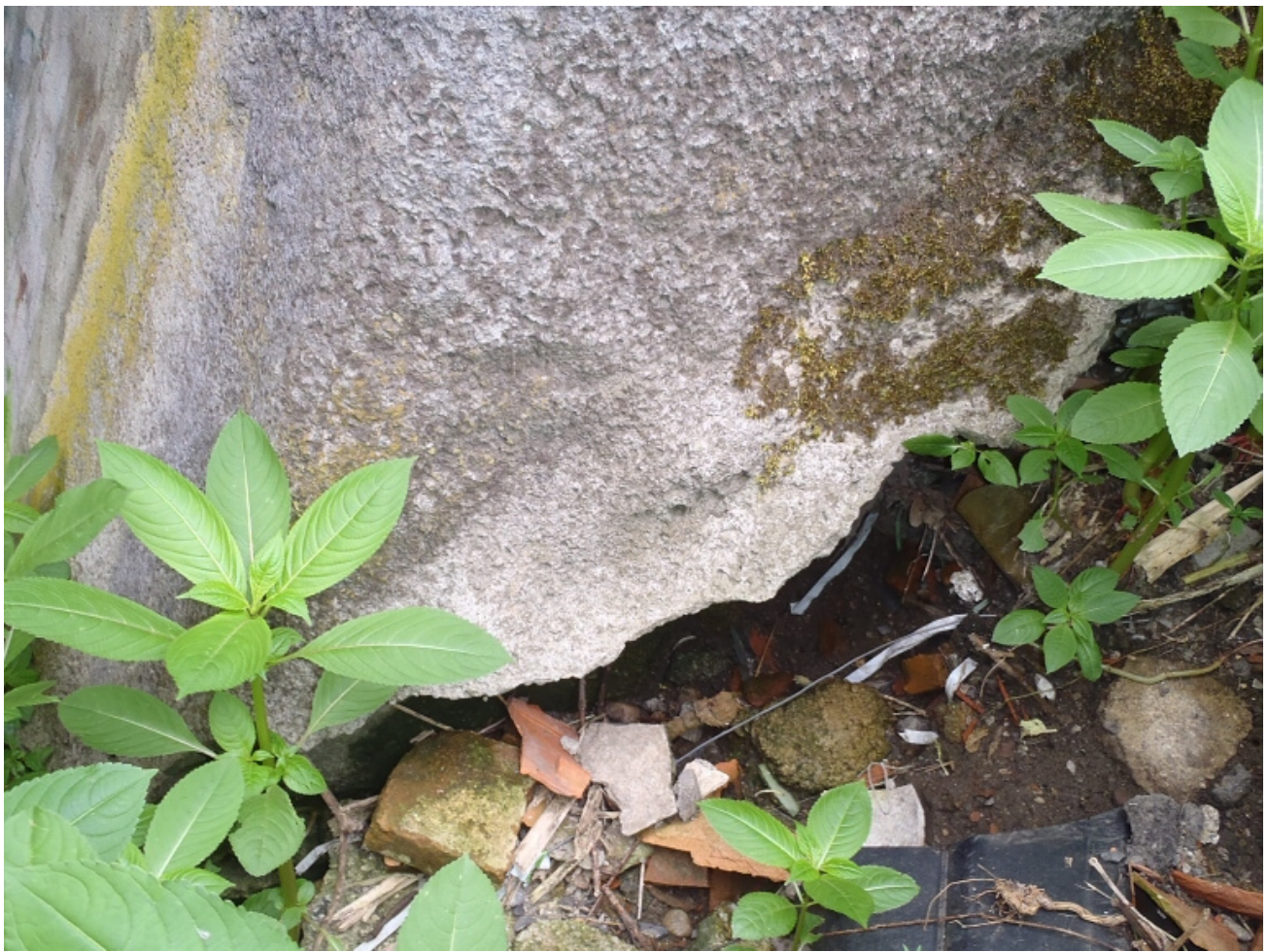
13 podemletí opěry na líci směrem do svahu
