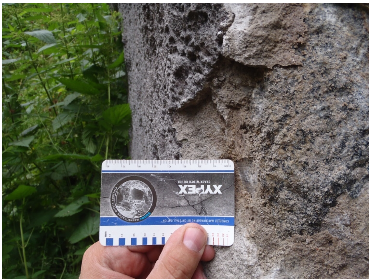
23 měření tloušťky torkretu
