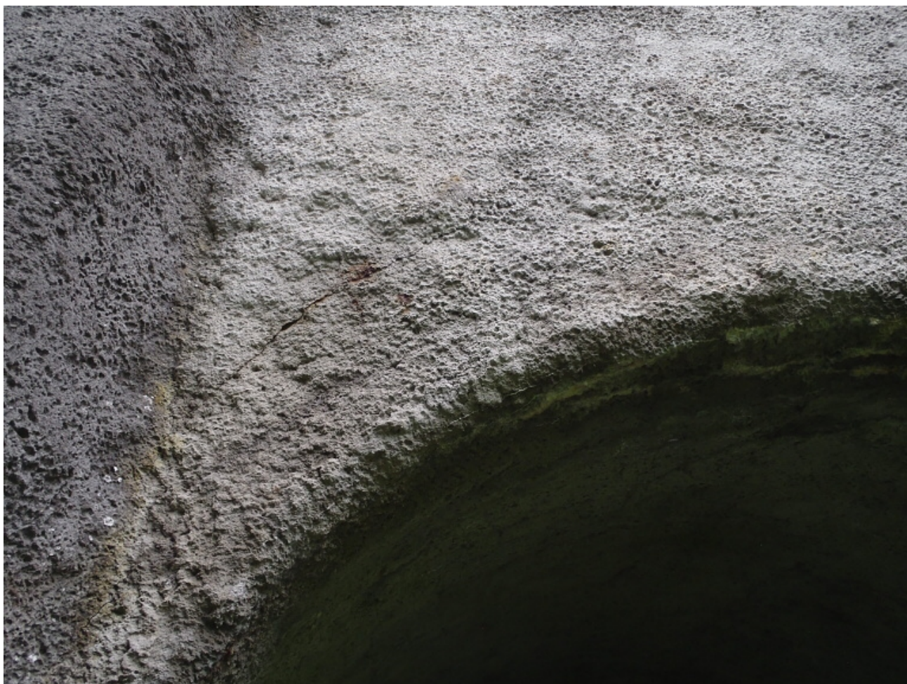
06 trhlina na klenbě směrem do svahu
