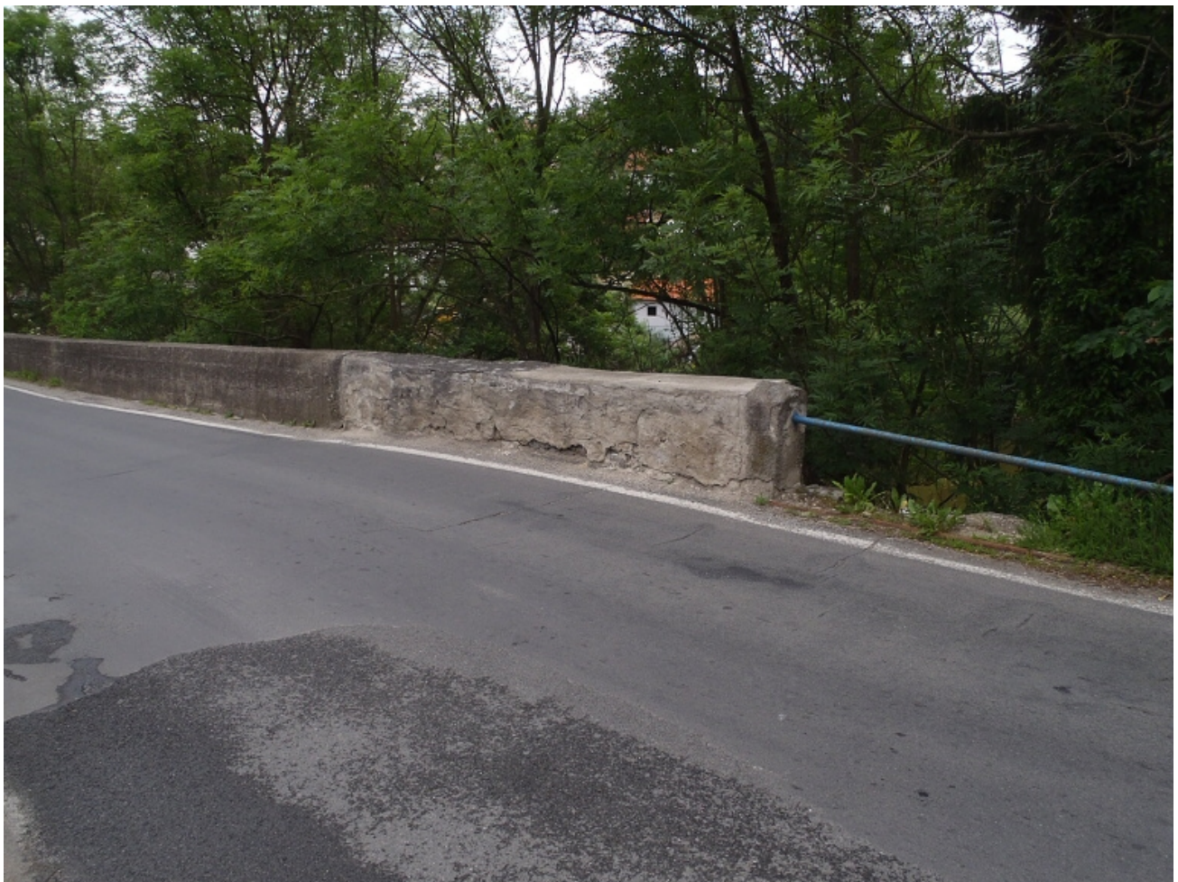
17 zábradlí a parapetní zídka vpravo ve směru staničení - poruchy u paty zídky nad vozovkou
