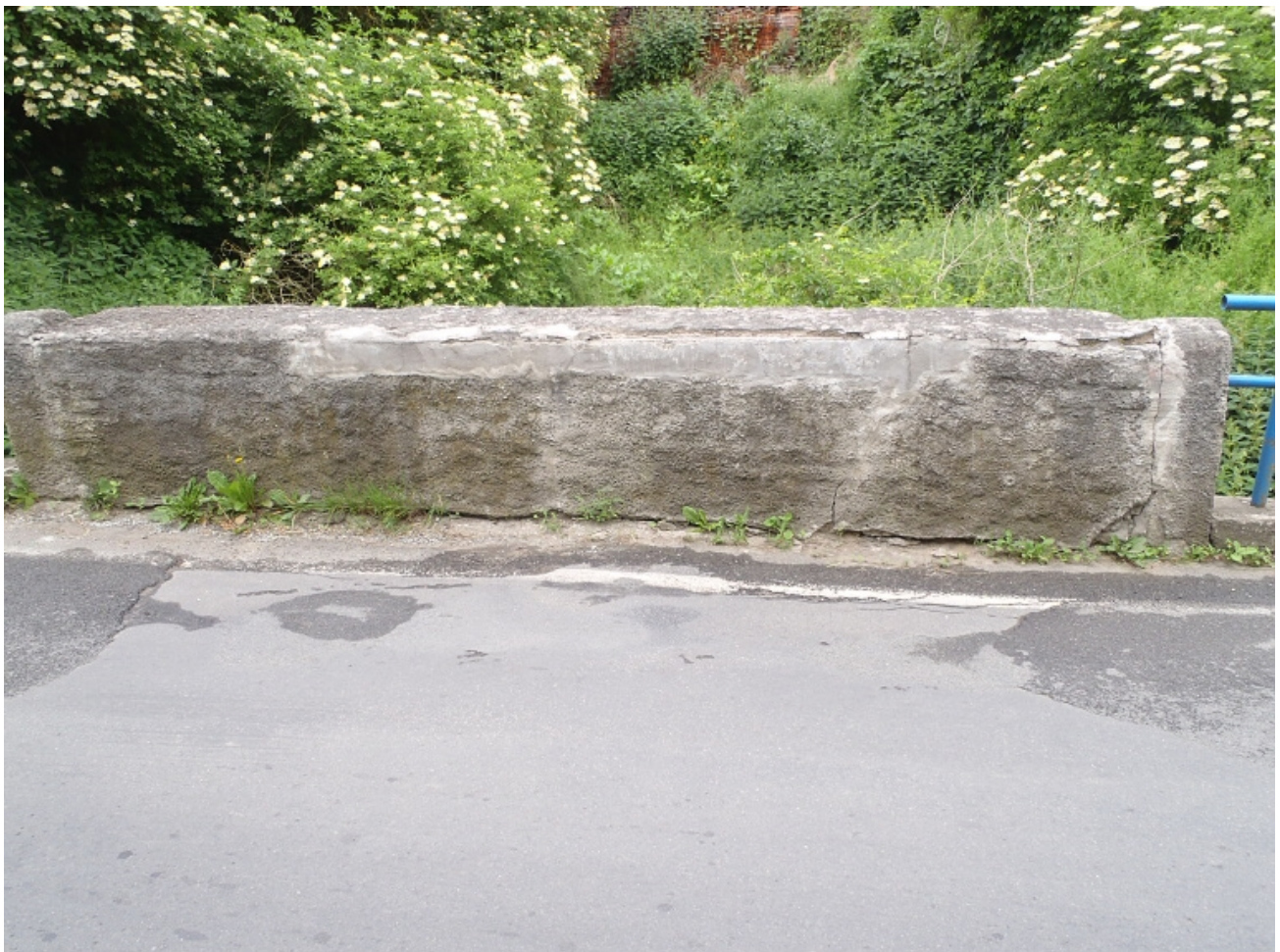
18 poruchy na parapetní zídce - uchycená vegetace
