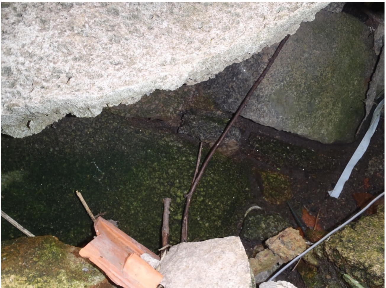
14 podemletí opěry na líci směrem do svahu - detail
