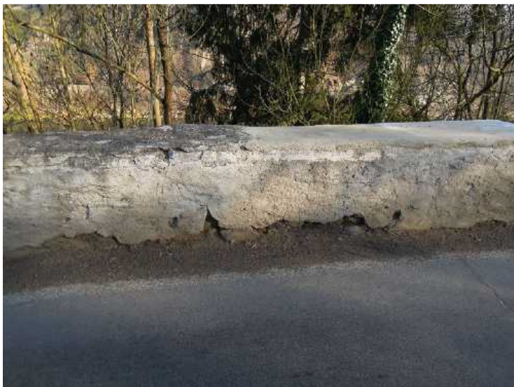
stav a poškození levé parapetní zídky
