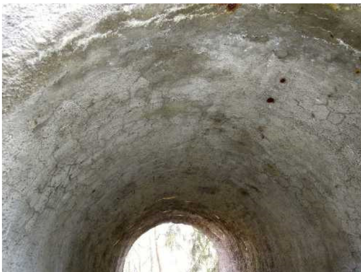
podhled NK, síť trhlin v torkretu, lokální průsaky a stopy rzi
