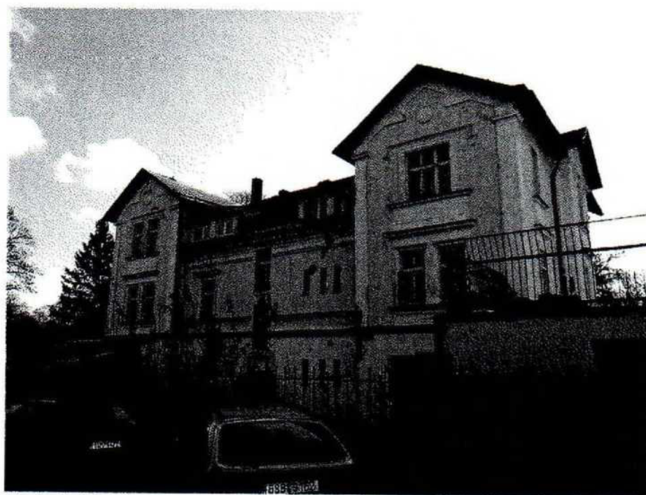
obrázek č.3 Severní pohled na budovu
