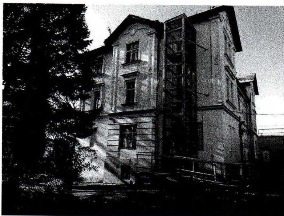
obrázek č.4 Východní pohled na budovu
