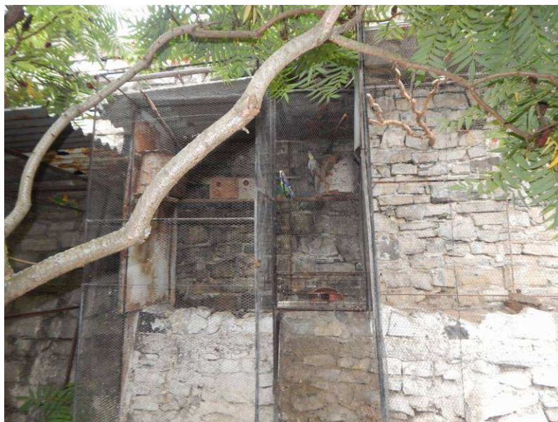
Obr. 2.9 – pohled na zeď ve staničení 32,0 – 35,0 m, před zdí jsou voliéry ptactva, zdivo je v horní části rozvolněné
