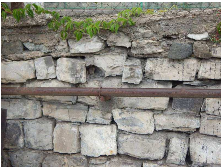
Obr. 2.4 – detail zcela chybějícího spárování a rozvolnění zdiva opěrné zdi
