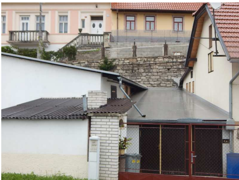
Obr. 2.12 – pohled na zeď ve staničení 45,0 – 50,0 m, k opěrné zdi je přizděna řada objektů – garáž, díly a část budovy
