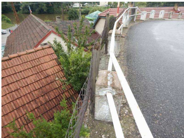
Obr. 2.38 – pohled na vozovku nad místem největších poruch zdi
