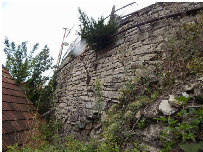
Obr. 2.35 – vyvalená část zdi ve staničení 82,0 m, v ploše cca 1,2 x 1,2 m došlo k destrukci paty zdi (zdivo ujelo po šikmé skále), zdivo nad místem poruchy je nestabilní a hrozí dalším sesunutím
