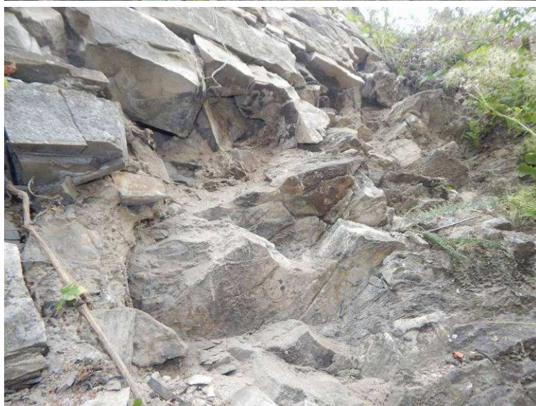
Obr. 2.34 – vyvalená část zdi ve staničení 82,0 m, v ploše cca 1,2 x 1,2 m došlo k destrukci paty zdi (zdivo ujelo po šikmé skále), zdivo nad místem poruchy je nestabilní a hrozí dalším sesunutím
