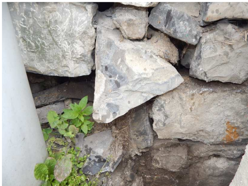
Obr. 2.2 – detail zcela rozvolněného zdiva opěrné zdi ve staničení cca 5,0 m, několik kamenů vypadlých
