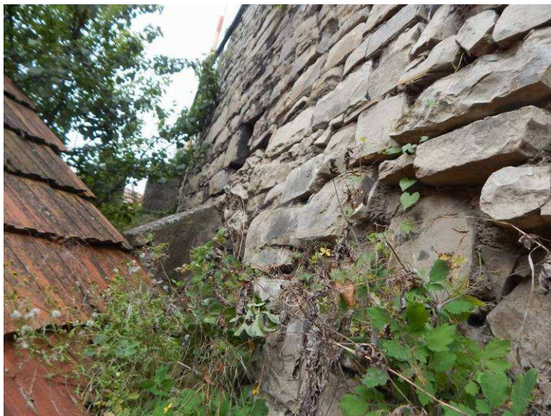
Obr. 2.32 – velmi špatný stav zdi ve staničení 77,0 - 83,0 m, zdivo je deformované, některé kusy kamenů vysunuté
