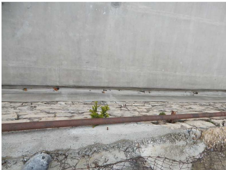
Obr. 2.15 – horní líc zdi nad přizděnou částí budovy, zdivo je rozvolněné, spárování vypadlé, uchycená vegetace
