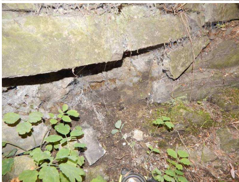
Obr. 2.31 – pata zdi ve staničení 78,0 m, vypadlé kusy kamenů v patě
