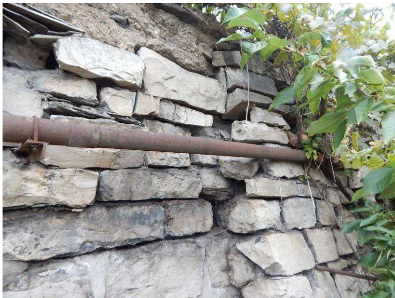
Obr. 2.6 – rozpadlý první zesilující opěrný pilíř ve staničení 20,0 m, kusy zdiva jsou zcela uvolněné a hrozí vypadnutím
