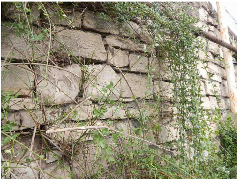
Obr. 2.25 – detail plošně vypadlého spárování zdi, uchycená vegetace
