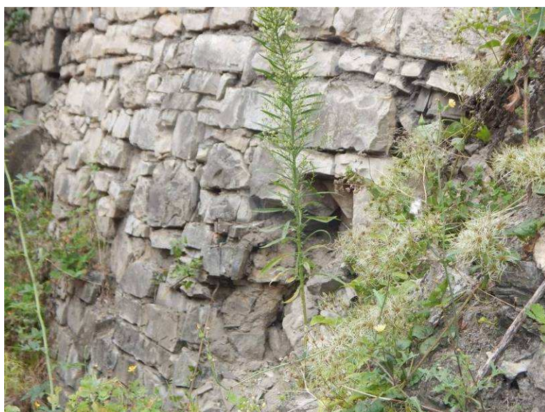
Obr. 2.36 – vyvalená část zdi ve staničení 82,0 m, v ploše cca 1,2 x 1,2 m došlo k destrukci paty zdi (zdivo ujelo po šikmé skále), zdivo nad místem poruchy je nestabilní a hrozí dalším sesunutím
