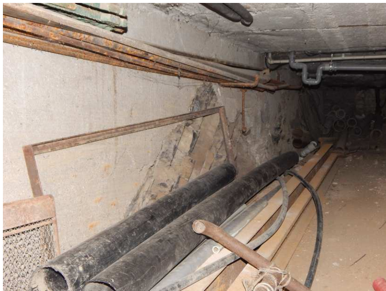
Obr. 2.18 – skalní výchoz v technologické místnosti pod částí budovy přizdžené přímo k opěrné zdi
