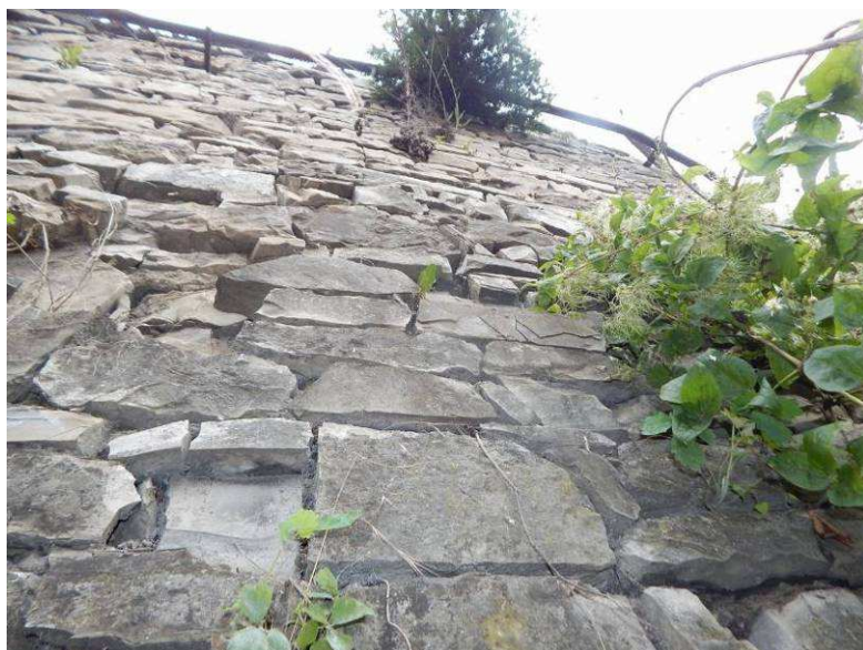
Obr. 2.33 – velmi špatný stav zdi ve staničení 78,0 - 83,0 m, zdivo je deformované, některé kusy kamenů vysunuté
