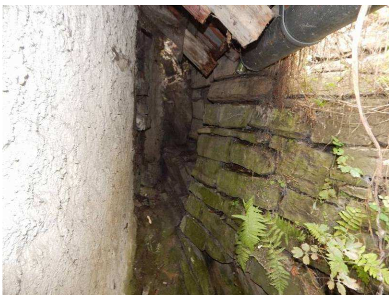
Obr. 2.30 – pata zdi ve staničení 78,0 m, zdivo je rozvolnění, lokálně vypadlé
