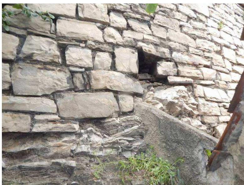
Obr. 2.27 – původní odvodňovací otvor ve zdi, spárování je plošně vypadlé
