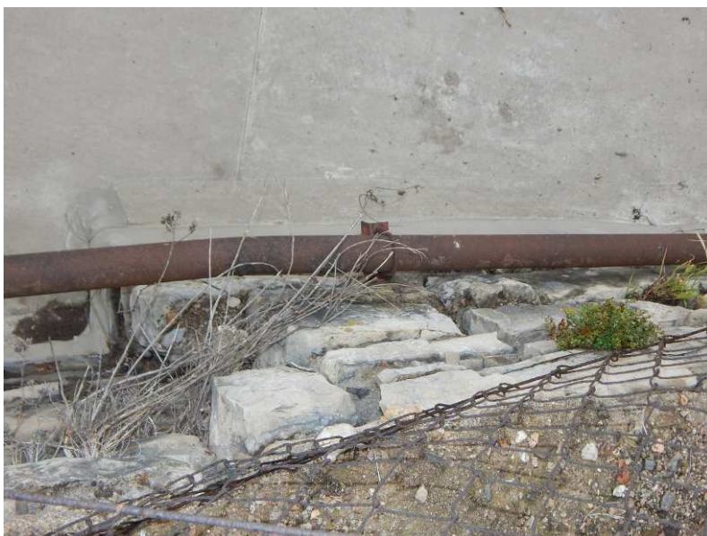
Obr. 2.16 – horní líc zdi nad přizděnou dílnou, některé kusy zdiva jsou uvolněné – vysouvají se, spárování plošně chybí
