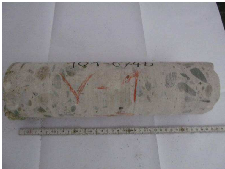
zkušební vývrt V1 pro stanovení vlastností betonu spodní stavby
