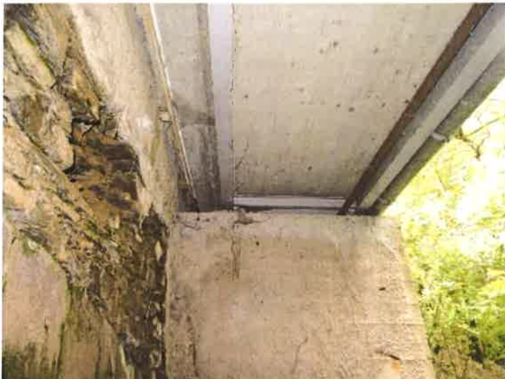
Spodní líc nosné konstrukce lávky.
