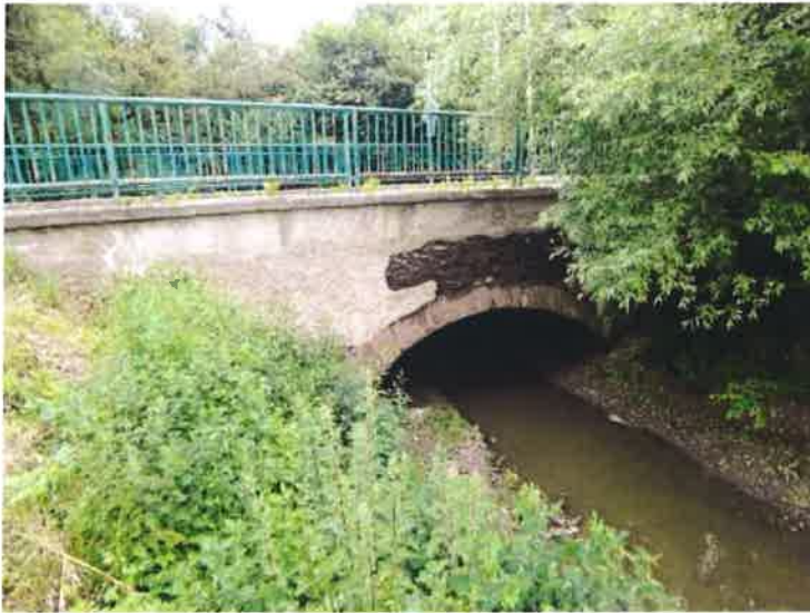
Pohled na pravý bok mostu.
