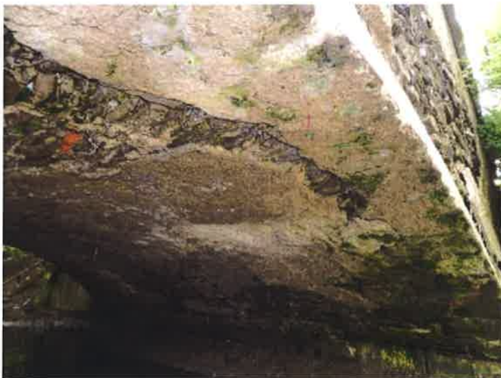
Spodní líc nosné konstrukce.
