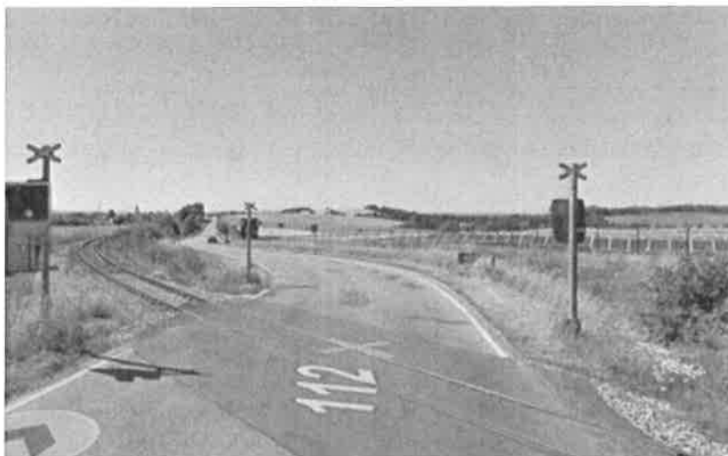
Začátek úseku, staničení km 6,70
