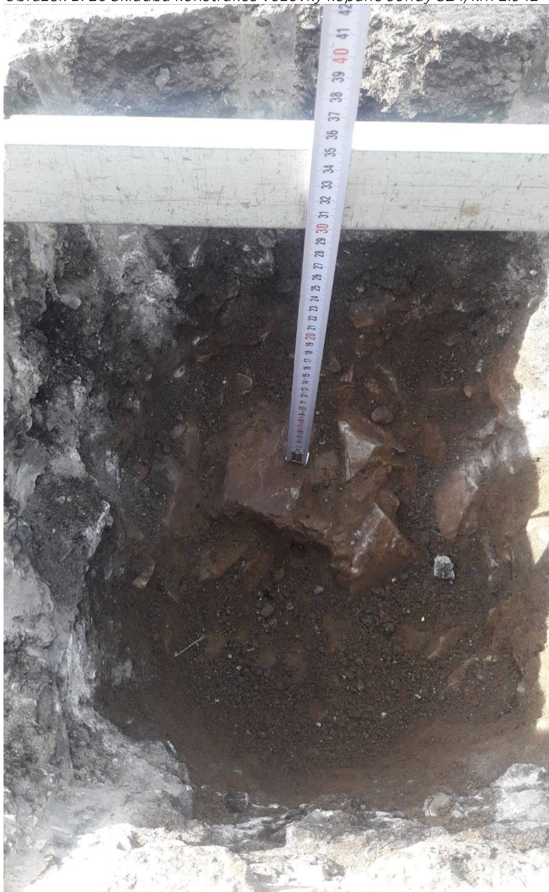
Obrázek B. 26 Skladba konstrukce vozovky kopané sondy SZ4, km 2.942
