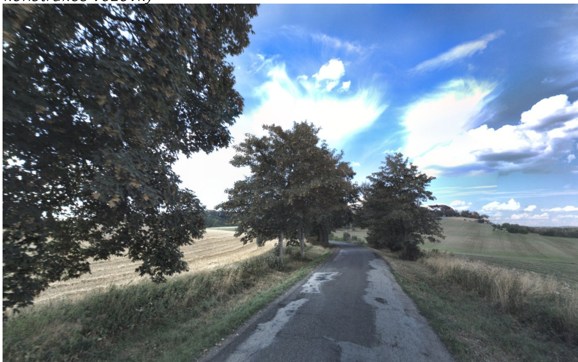
Obrázek A. 8 Nedostatečná únosnost okrajů vozovky
