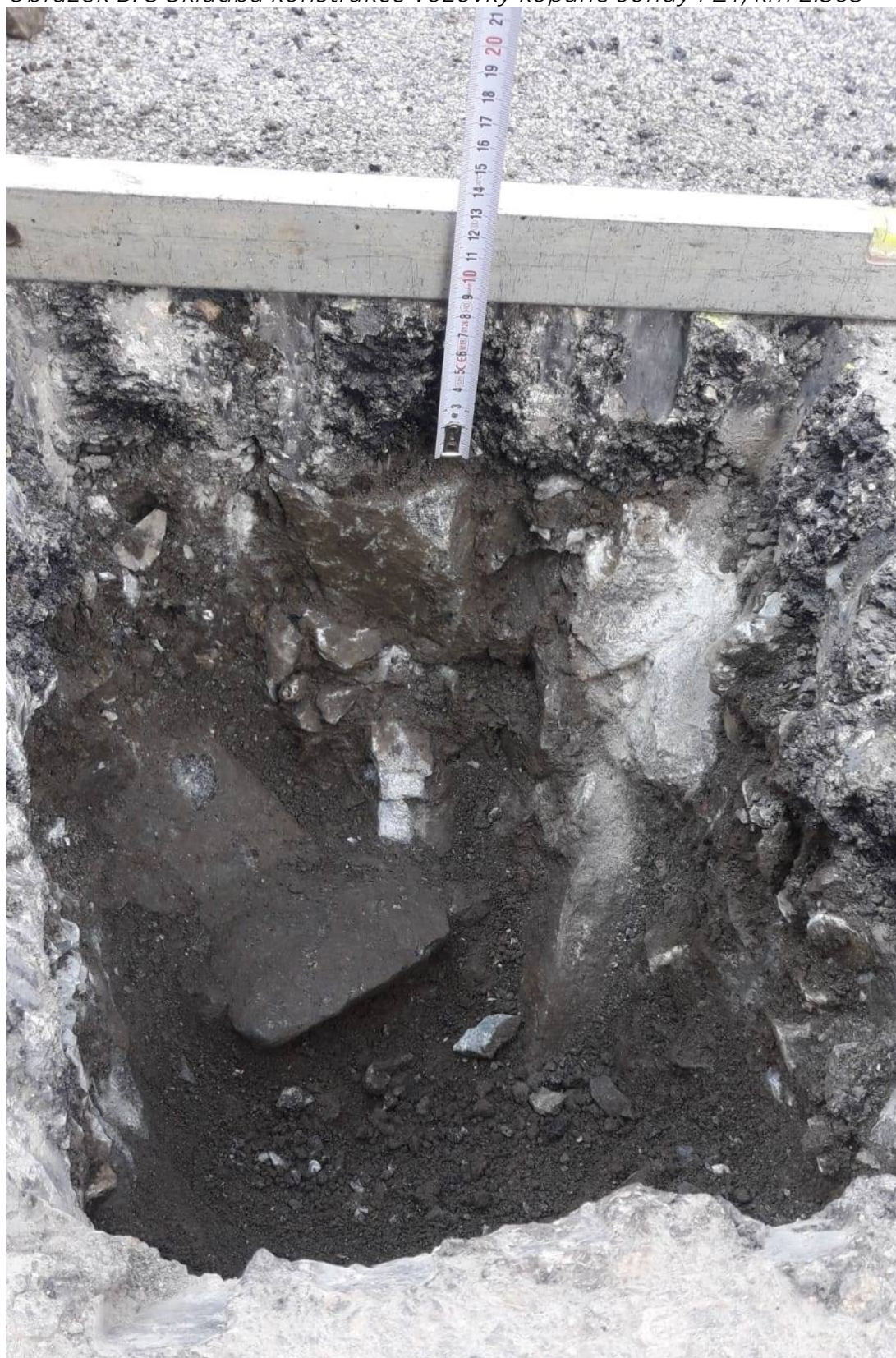
Obrázek B. 3 Skladba konstrukce vozovky kopané sondy PZ1, km 2.303
