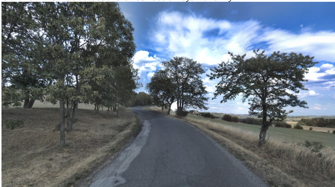
Obrázek A. 8 Nedostatečná únosnost okrajů vozovky
