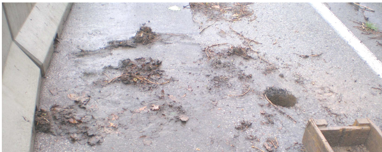
Obr. 4 Poškozený povrch vozovky a poloha nového ověřovacího vrtu J 1 na jižním okraji mostu.
