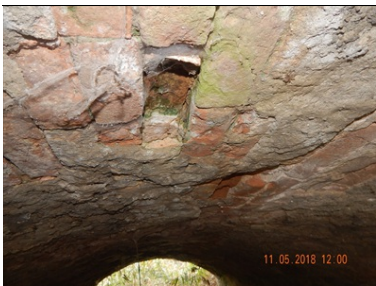
Lokálně vypadlé cihelné zdivo.
