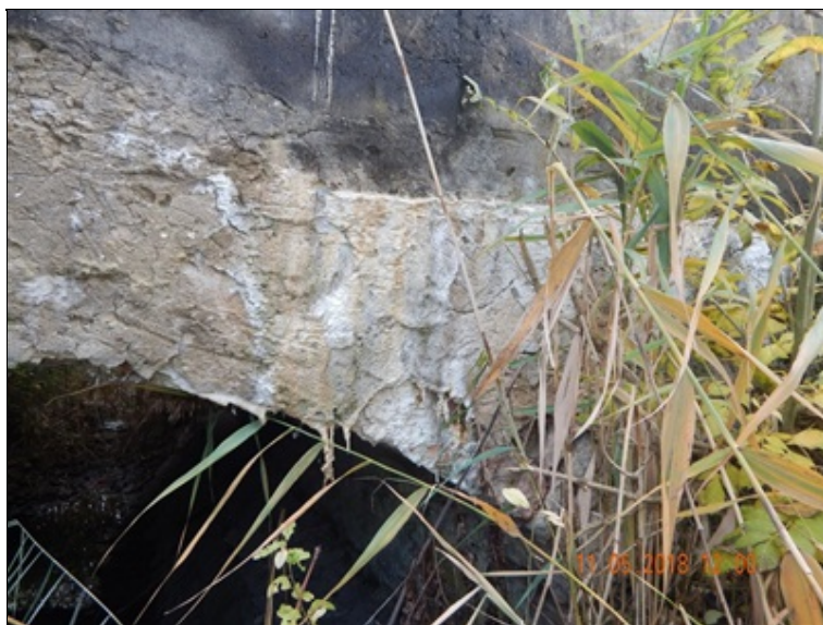
Stopy po prúscacích na pravém boku klenby, výluhy pojiva.
