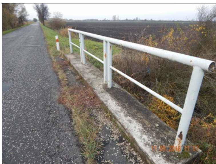
Nánosy vegetace podél levé římsy.
