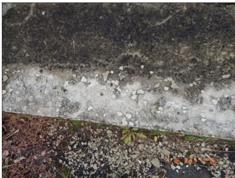
Degradace římsy.
