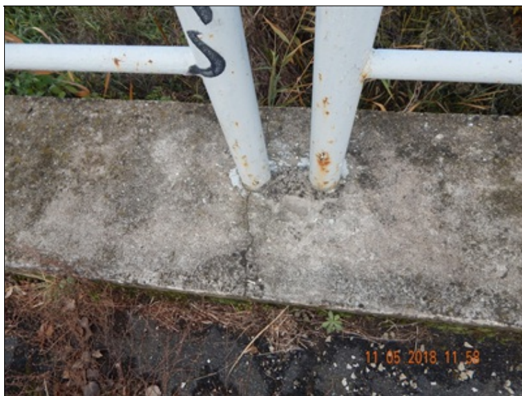
Příčná trhlina v římse.
