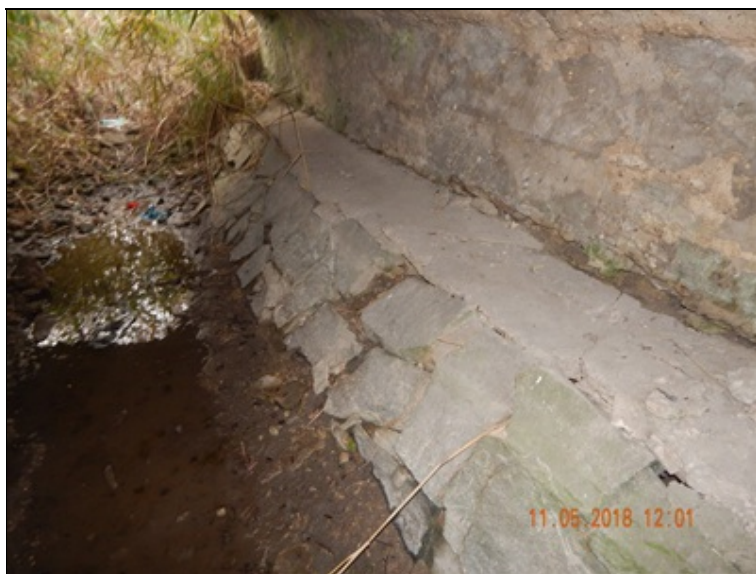
Rozvolněné spárování opevnění koryta.
