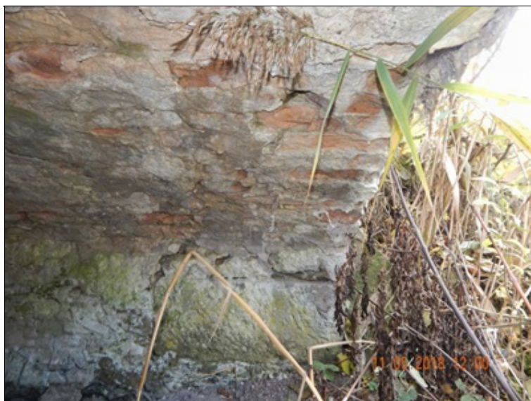
Povrchová degradace zdiva, stopy po zatékání na pravé straně.
