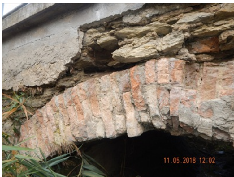
Hlubkový rozpad levé čelní včetně poškození zdiva nosné konstrukce klenby.
