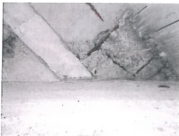
dobetonávka ve vetknutí nosníku do NK
