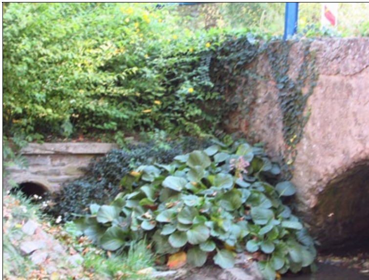
Pravé křídlo OP1
