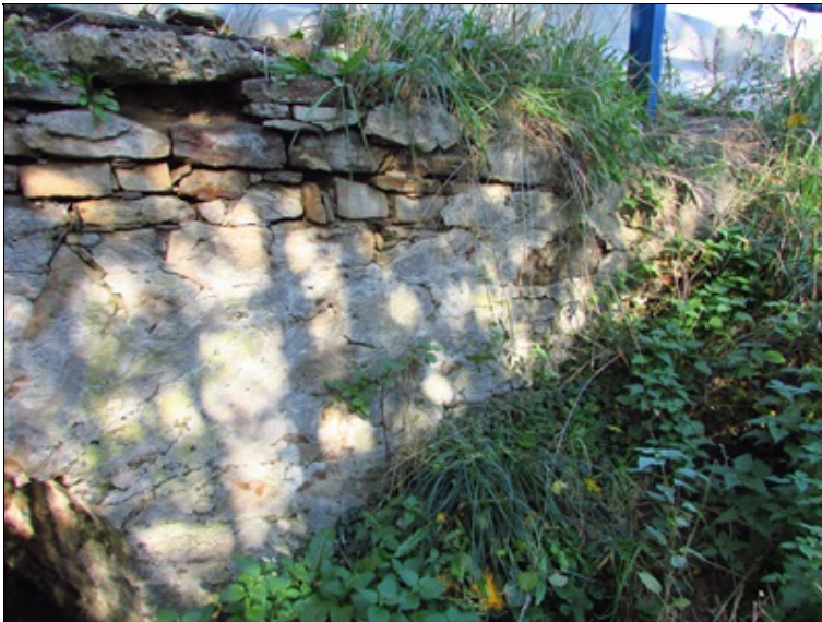
Levé křídlo OP1
