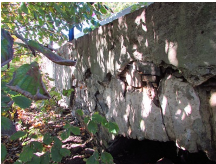
Levé křídlo OP3
