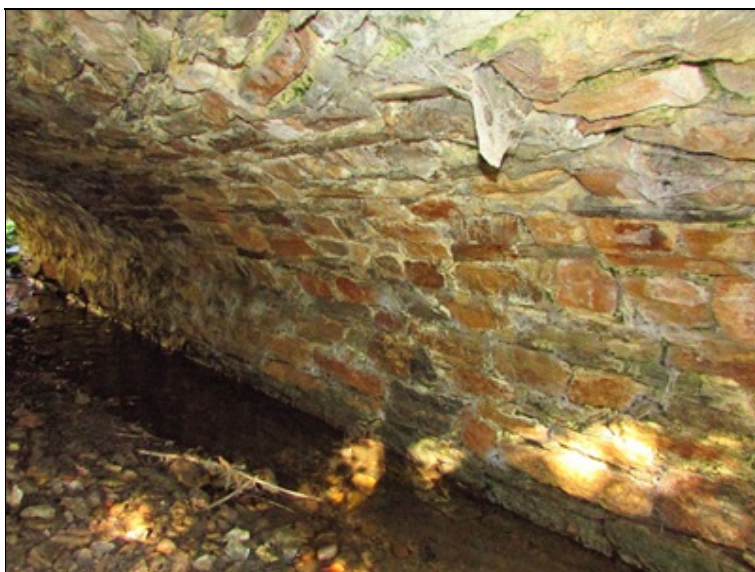
Pohled na OP1
