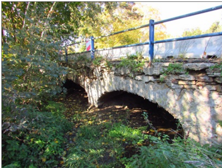
Pohled na most z levé strany
