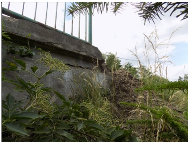
Kypřý zásyp svahu za levým křídlem OP1, přibetonávka křídla
