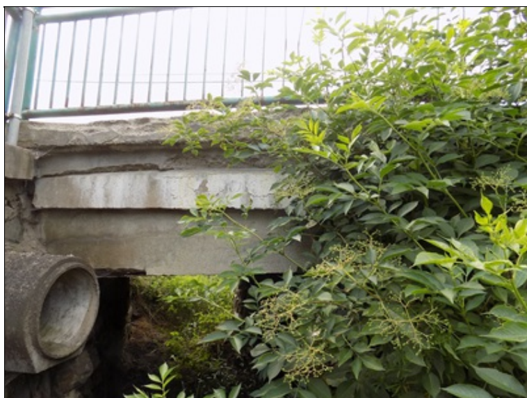
Levá strana mostu
