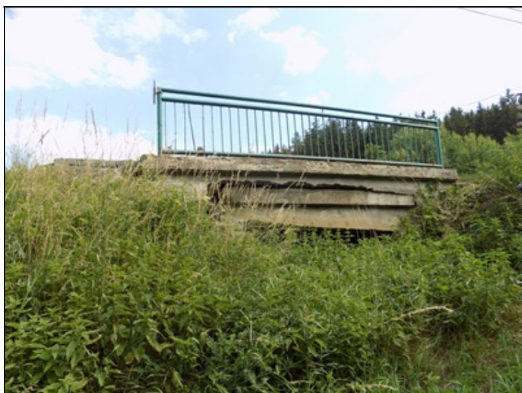
Pohled na most zprava
