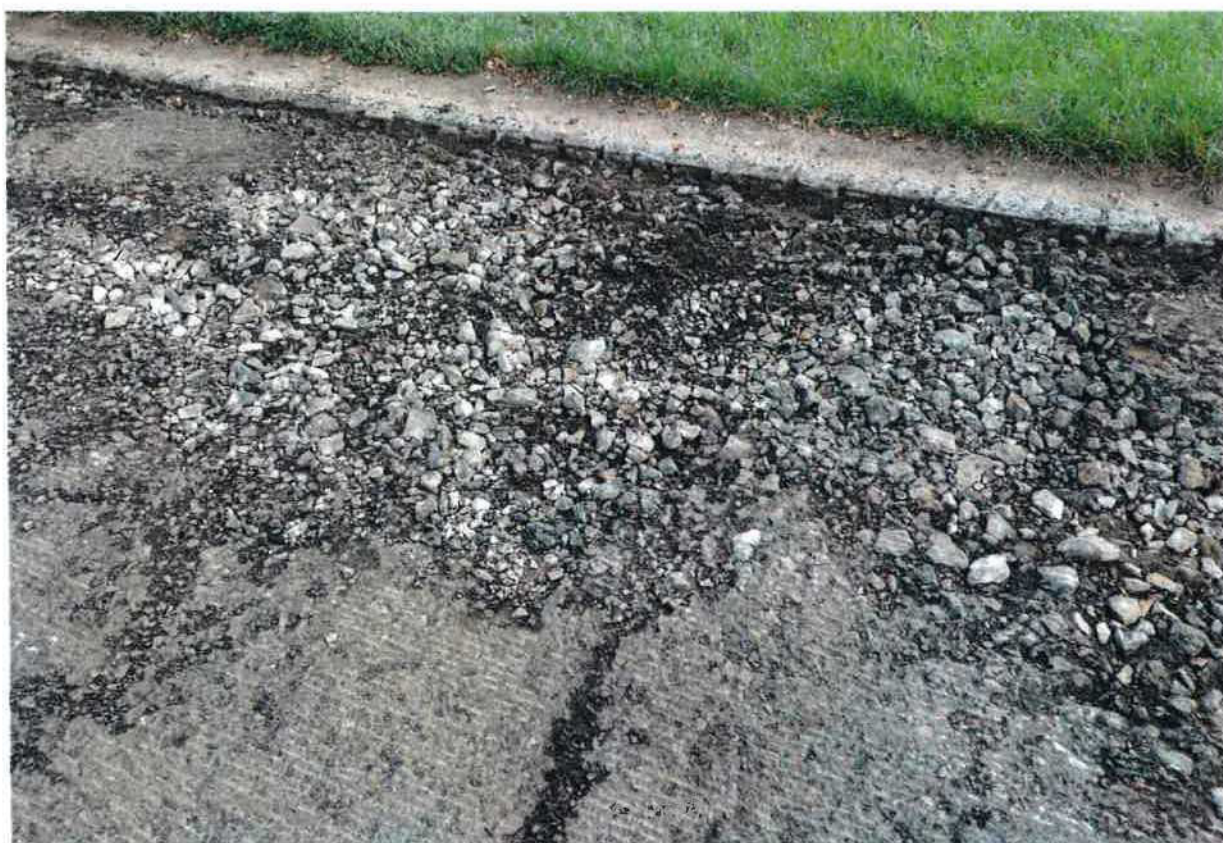
Zastižený podklad po odfrézování – detail SO 113
