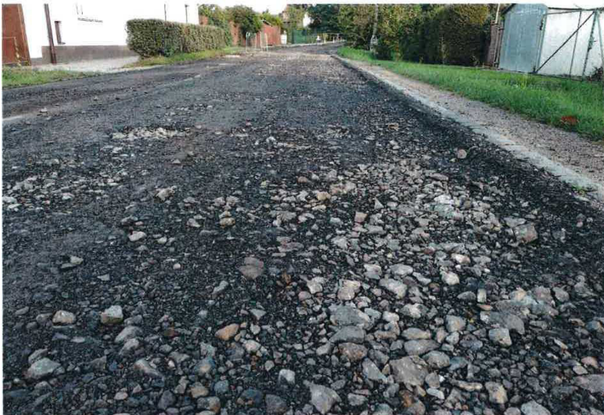
Zastižený podklad po odfrézování SO 113
