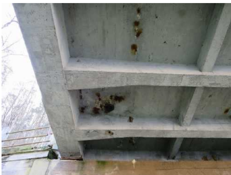
průsaky nosnou konstrukcí v okolí korodujícího svodu odvodnění
