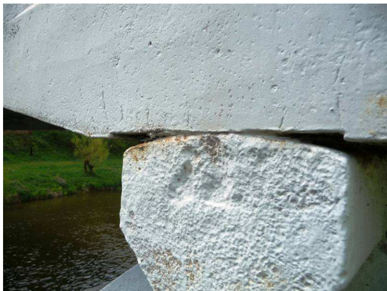
levé ložisko na pilíři P2, detail styčné (kyvné) plochy ve vrcholu stolice
