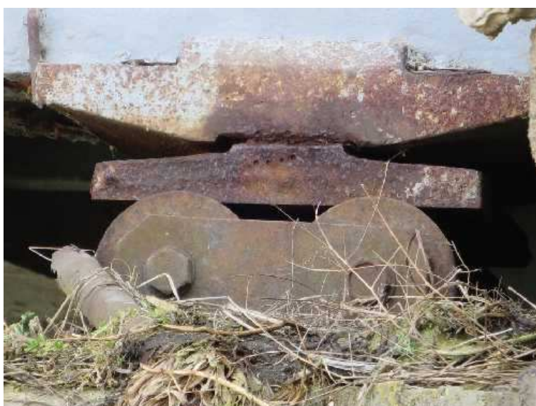
koroze pravého ložiska na opěrou O4
