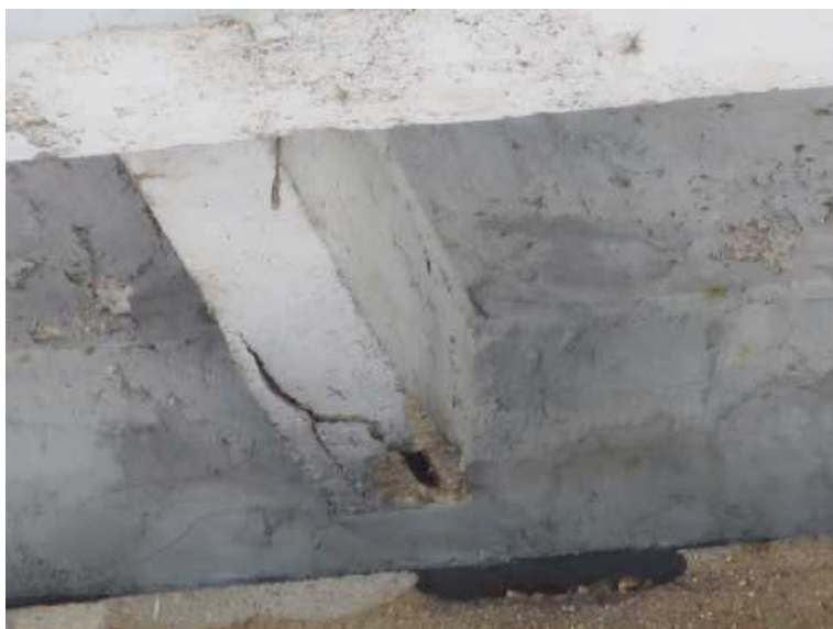
DTTO u podélníku, část krycí vrstvy již odpadla
