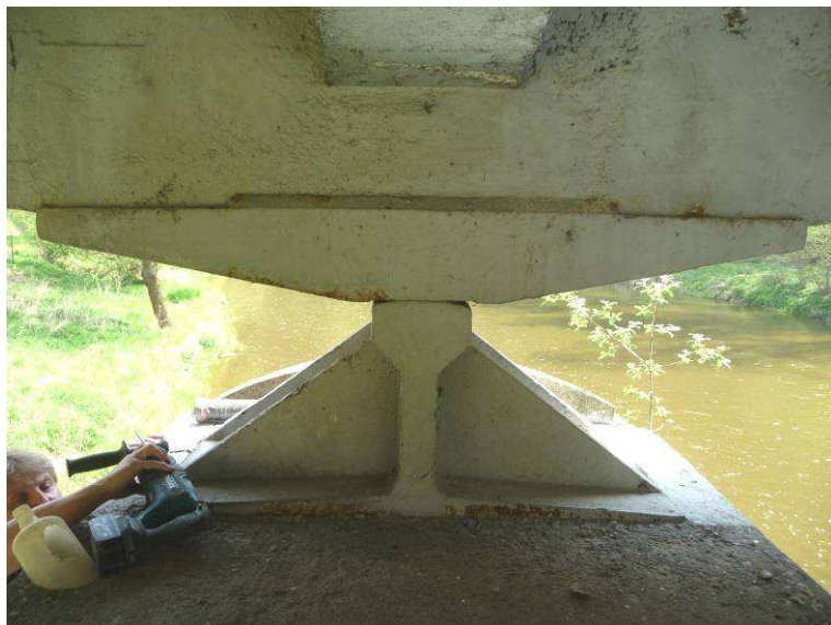
levé ložisko na pilíři P2, pohled z úložného prahu
