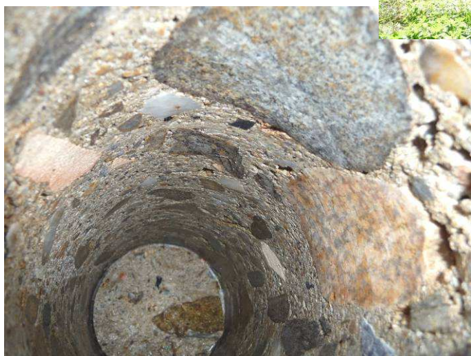
Pohled do otvoru jádrového vrtu V3 v dříku pilíře P2. Jsou patrná velká zrna použitého kameniva i nezanedbatelná mezerovitost materiálu.
