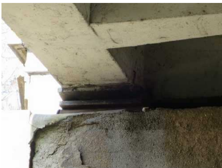
pravé ložisko na opěrou O1 stojí ve zjevně degradovaném betonu
