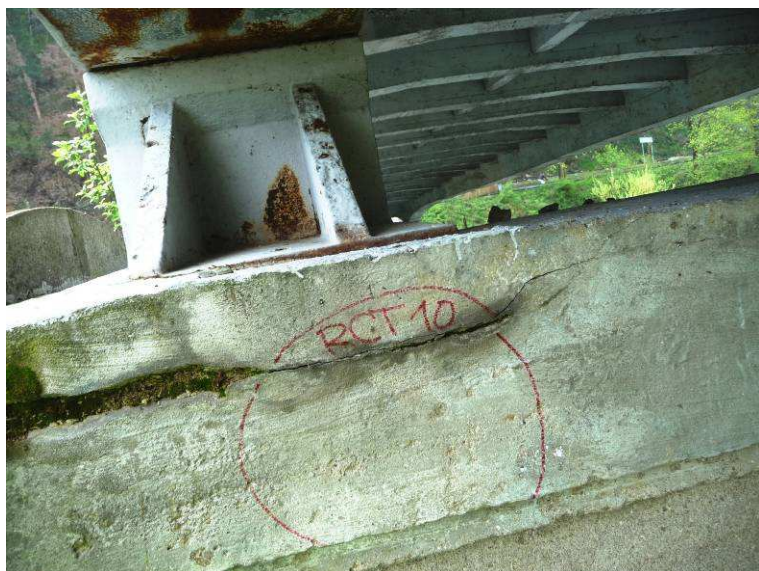
levé ložisko na pilíři P2, pohled ve směru parapetního trámu z pole 1
