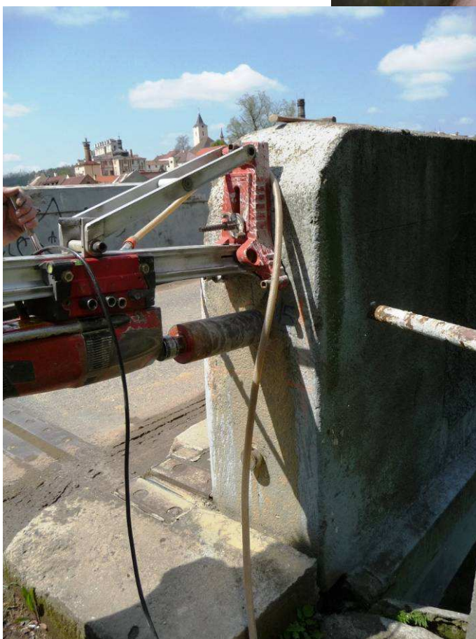
Odběr vzorku betonu V5, koncové čelo levého parapetního trámu, cca 0,75 m nad povrchem odrazného pruhu.
