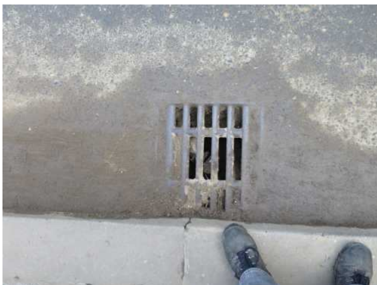
částečně ucpaný odvodňovač
