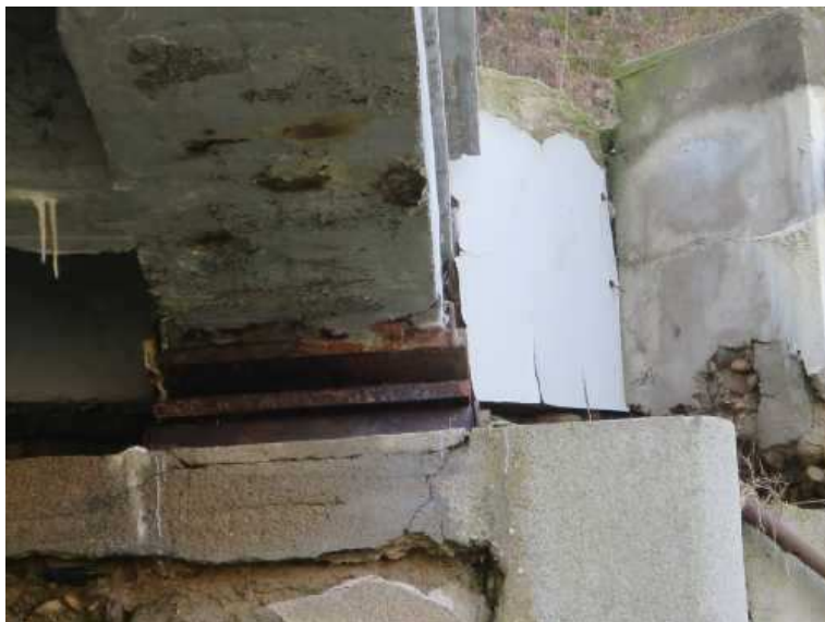
pravé ložisko je osazeno na úložném prahu opěry O4 v oblasti hloubkově degradovaného betonu
