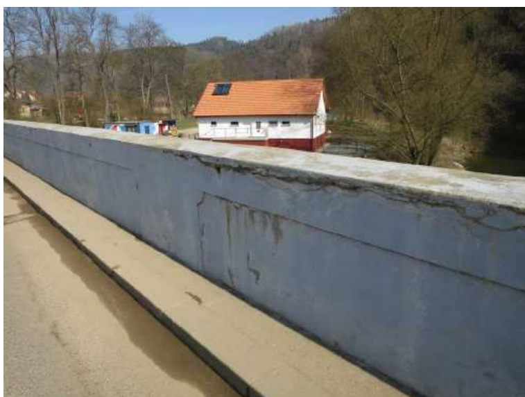
separace krycí vrstvy nad korodující výztuží na horním líci hlavního parapetního trámu
