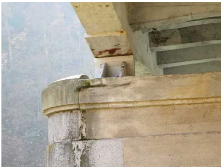
trhlina v úložném prahu pilíře P2 v místě uložení levého ložiska, které koroduje
