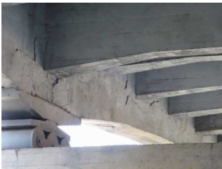
separace krycí vrstvy na vnitřním boku pravého hlavního parapetního trámu v oblasti nad pilířem P3
