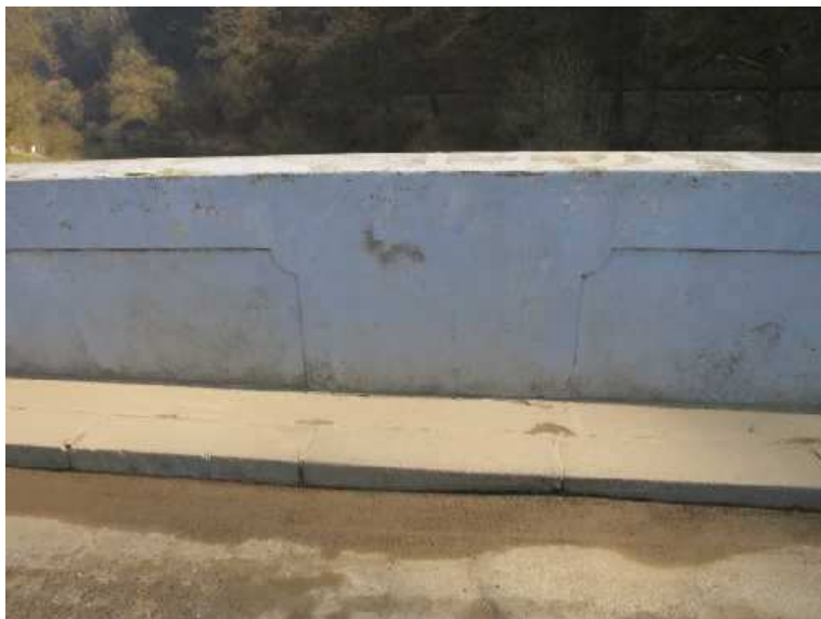
svislá trhлина v nadpilířovém průřezu hlavního trámu
