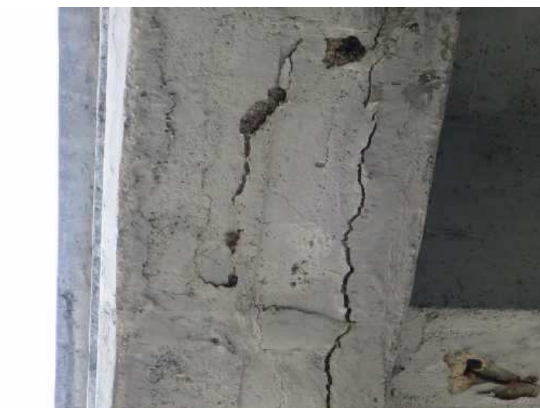
podélné trhliny charakteristické pro separaci krycí vrstvy na spodním líci parapetního rámu (detail)
