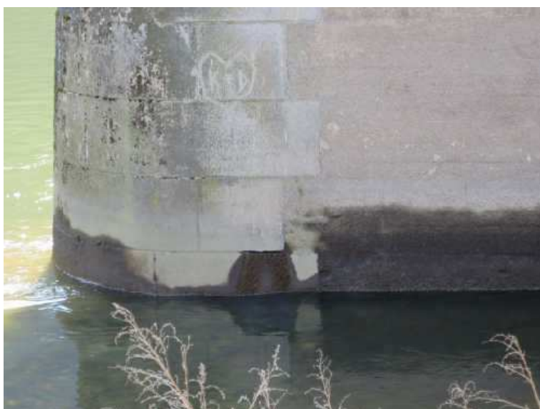
průsak ze spáry obkladního zdiva dřívku pilíře P2
