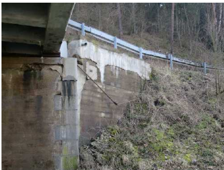
vykloněné pravé křídlo opěry O4
