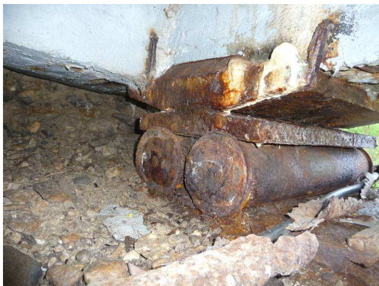
pravé ložisko na opěře O4, pohled z úložného prahu
