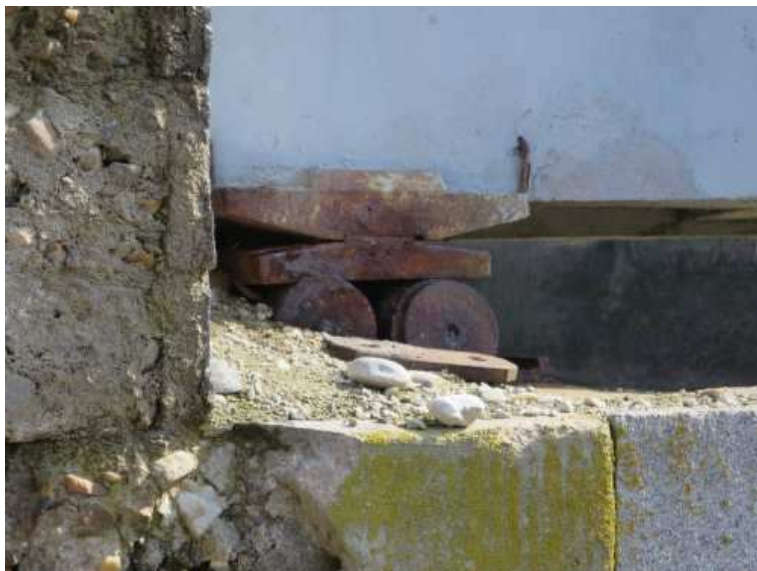
pravé ložisko na O1 je zjevně omezeně funkční
