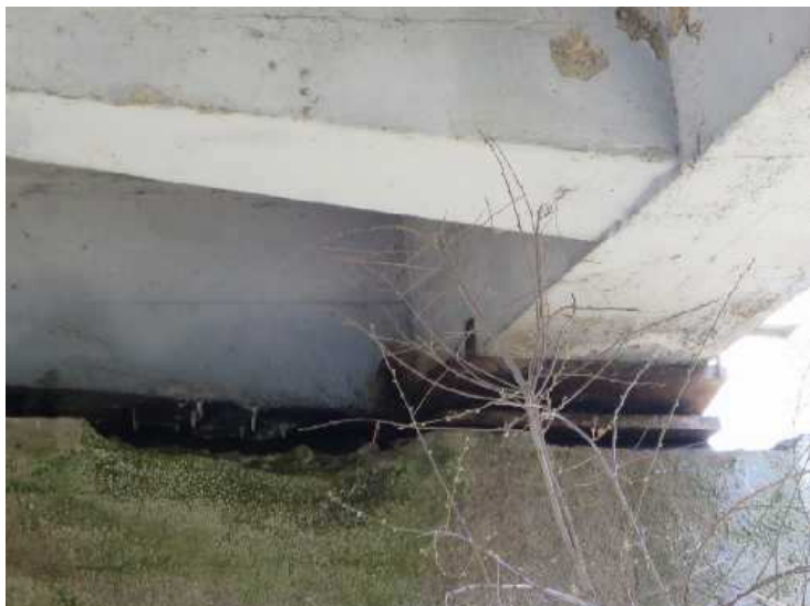
degradace betonu úložného prahu opěry O1 u levého ložiska
