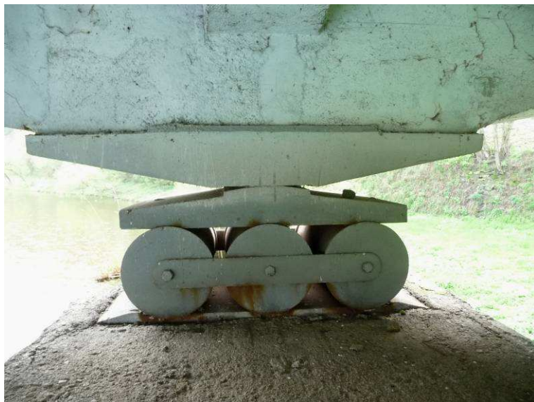
levé ložisko na pilíři P3, pohled z úložného prahu
