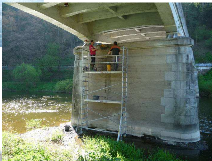
Odběr vzorku betonu V4, úložný práh pilíře P2, cca 0,25 m pod povrchem prahu.
