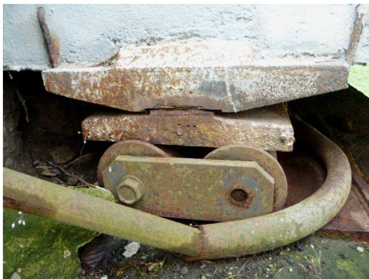
levé ložisko na opěře O4, pohled z boku dřívku
