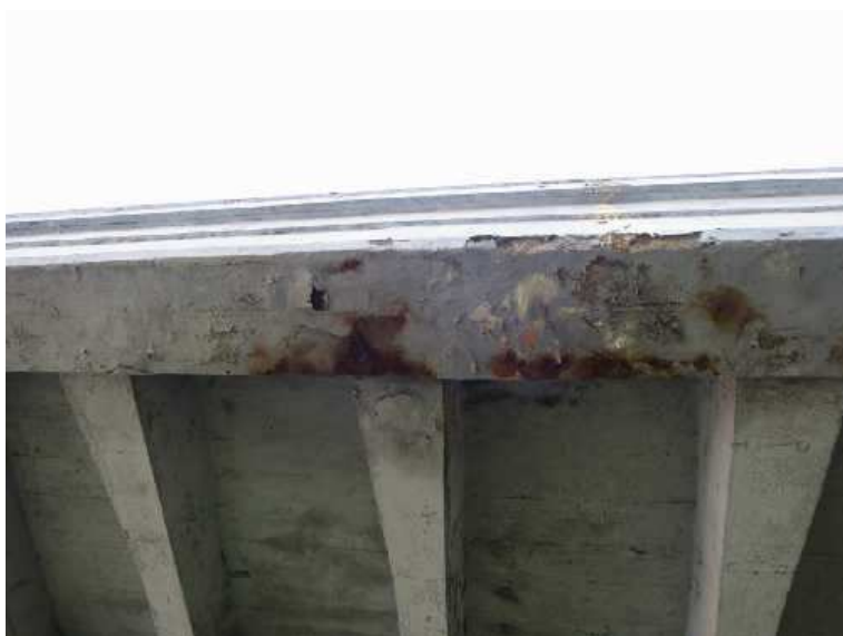
intenzivní stopy koroze výztuže a výluhů pojiva v oblasti separované krycí vrstvy na spodním líci hlavního parapetního trámu
