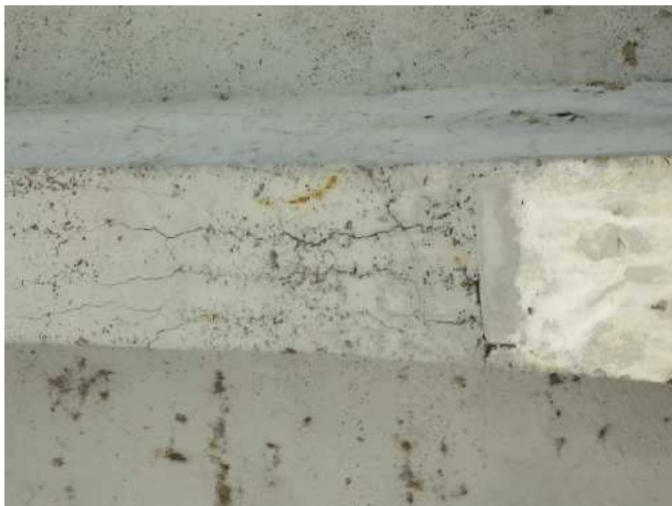
typické trhliny krycí vrstvě na spodním líci příčnicku nad korodující výztuží
