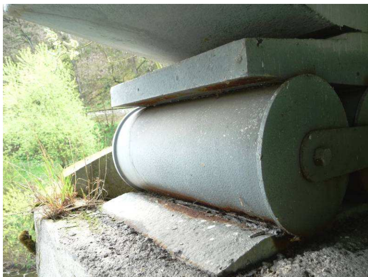
levé ložisko na pilíři P3, pohled na krajní válec z pole 2
