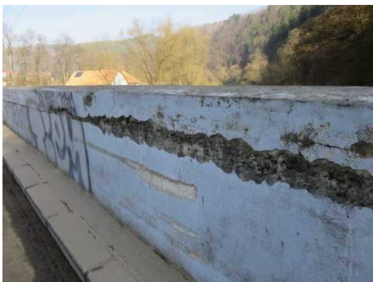
mechanicky poškozený vnitřní líc levého trámu ve 3. poli
