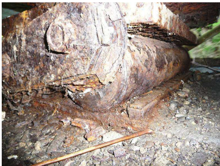
levé ložisko na opěře O, pohled od závěrné zdi
