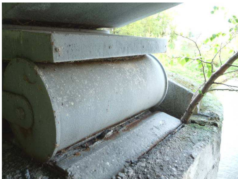
pravé ložisko na pilíři P3, pohled na krajní válec z pole 2
