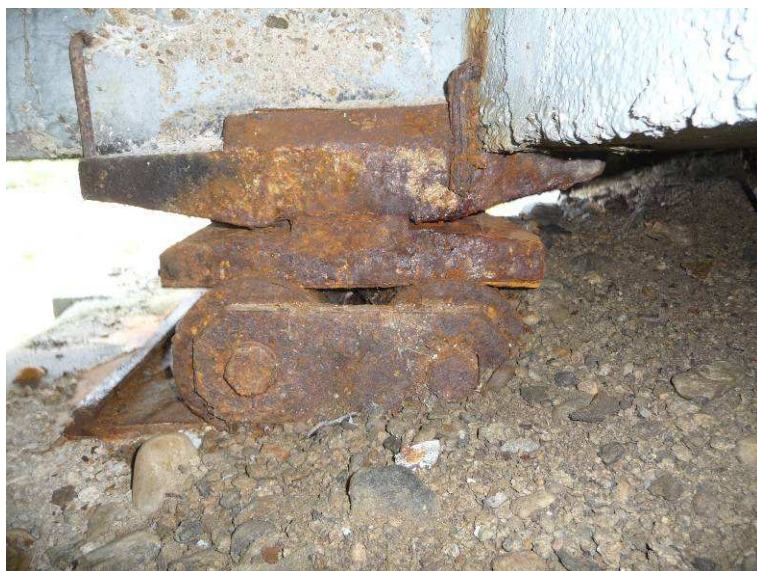
pravé ložisko na opěře O1, pohled z úložného prahu
