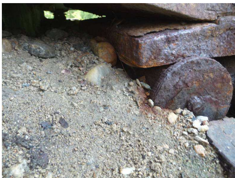
pravé ložisko na opěře O1, detail zadní strany u závěrné zdi
