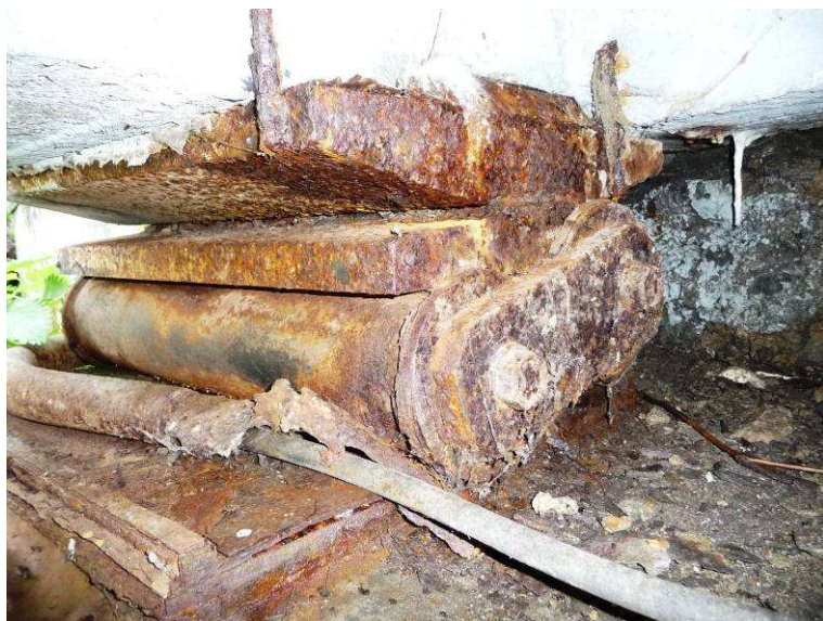
levé ložisko na opěře O4, pohled z úložného prahu
