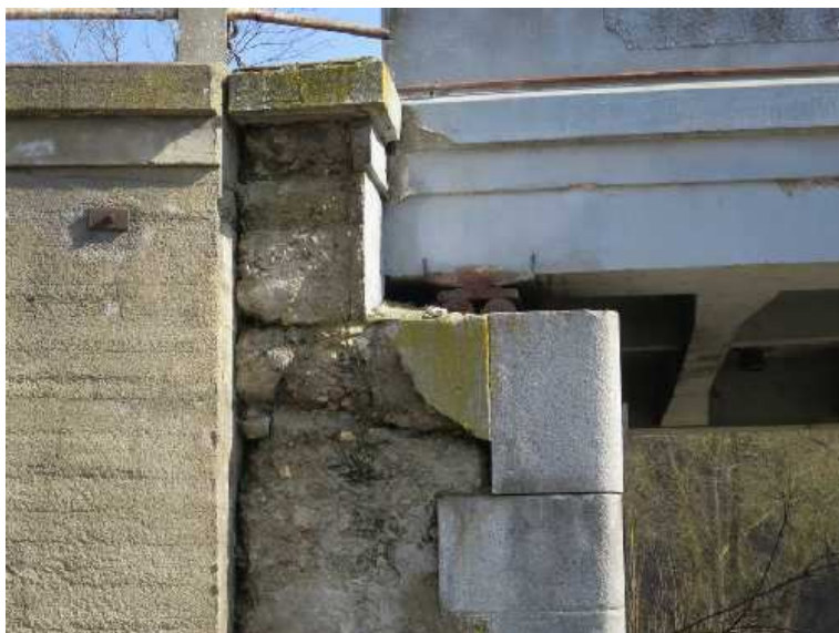
detail hloubkového poškození pravého boku O1
