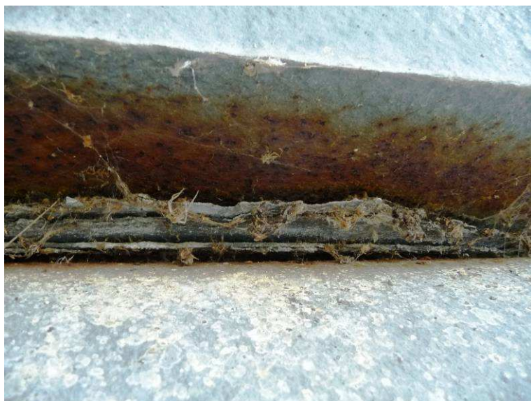
pravé ložisko na pilíři P3, detail mezery mezi krajním válcem a deskou vahadla
