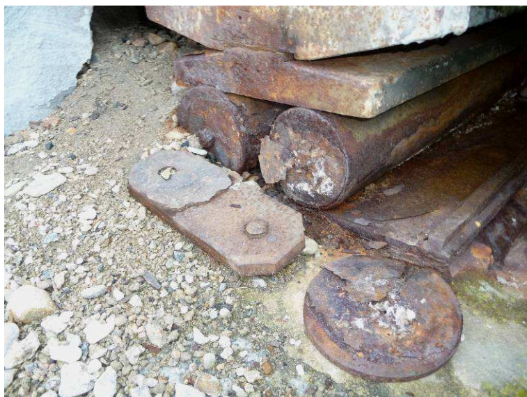
pravé ložisko na opěře O1, pohled z boku dříku
