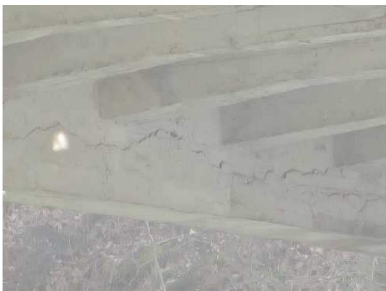
separace krycí vrstvy nad korodující výztuží na spodním líci levého hlavního parapetního trámu ve 2. poli
