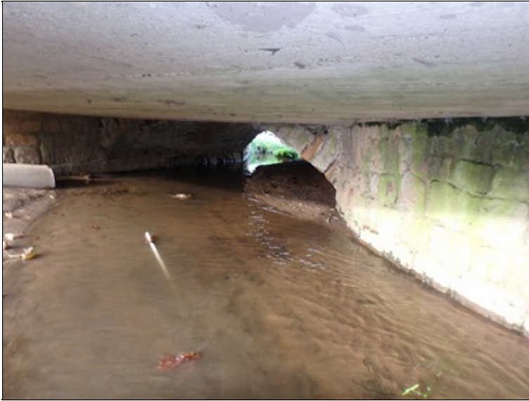
Podhled nosnou konstrukcí zleva - rozšiřující deska
