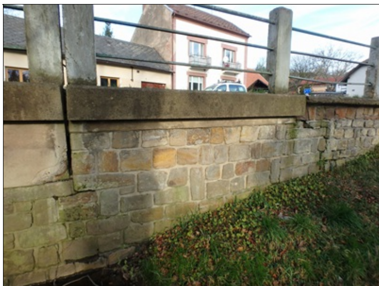
Levé křídlo opěry 1 a navazující zídka
