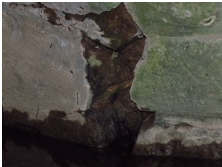
Kaverna v místě navázání původní opěry klenby a opěry pravého rozšíření OP2
