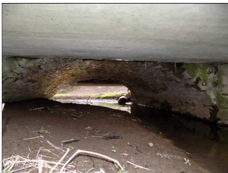
Podhled nosnou konstrukcí zprava - pravé rozšíření
