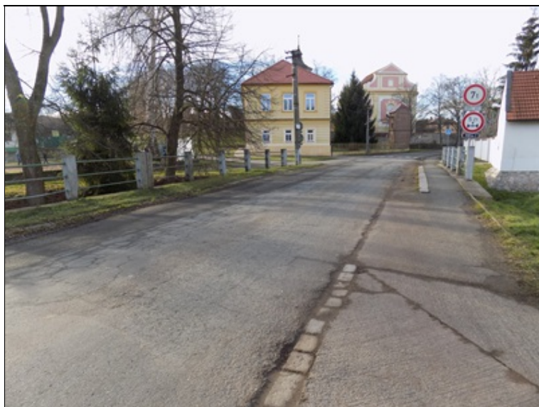
Uspořádání na mostě ve směru staničení
