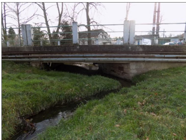
Pohled na most zprava
