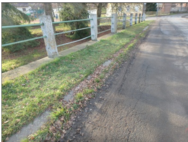
Levá krajnice na mostě
