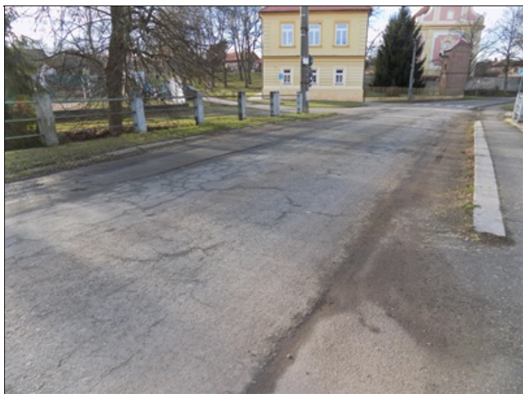
Vozovka na mostě
