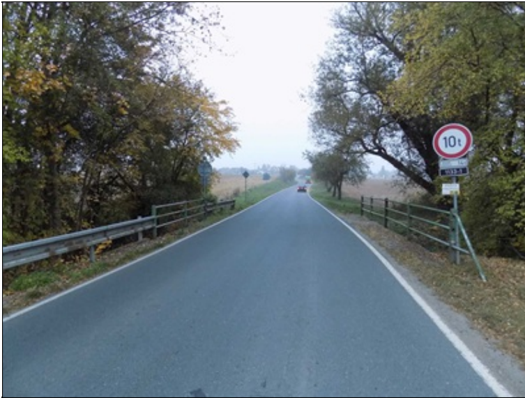
Pohled na most proti směru staničení.
