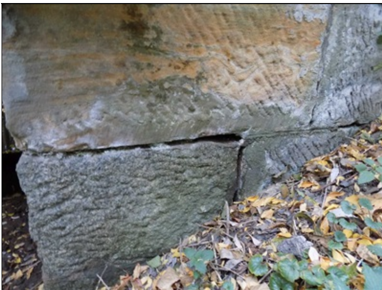
OP1 vlevo - vydrolené spárování.
