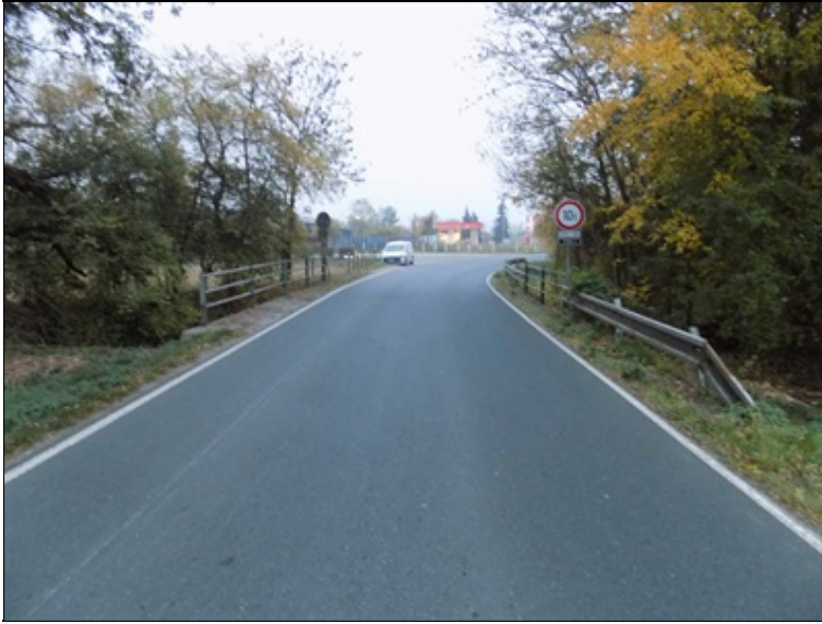
Pohled na most po směru staničení.
