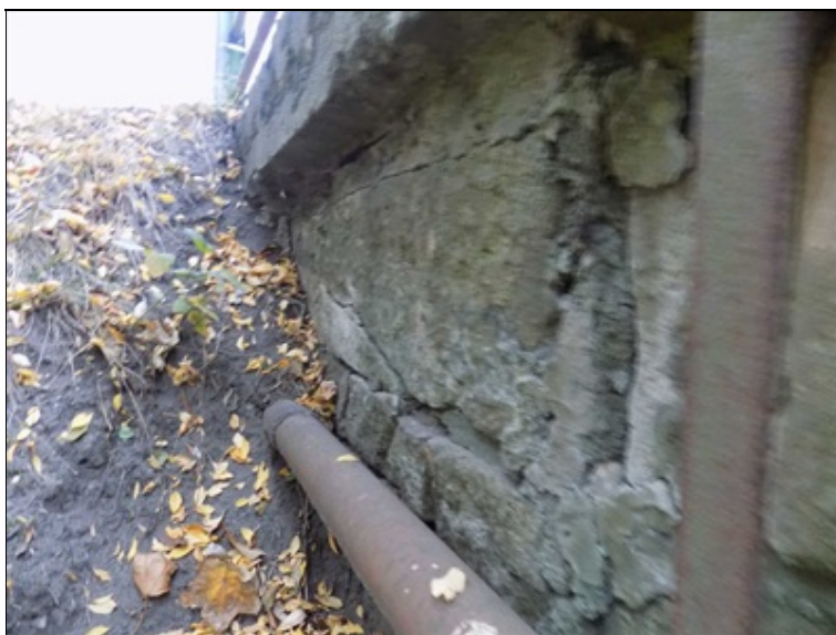
OP2 vlevo křídlo: vysouvá se kámen až o 30 mm.
