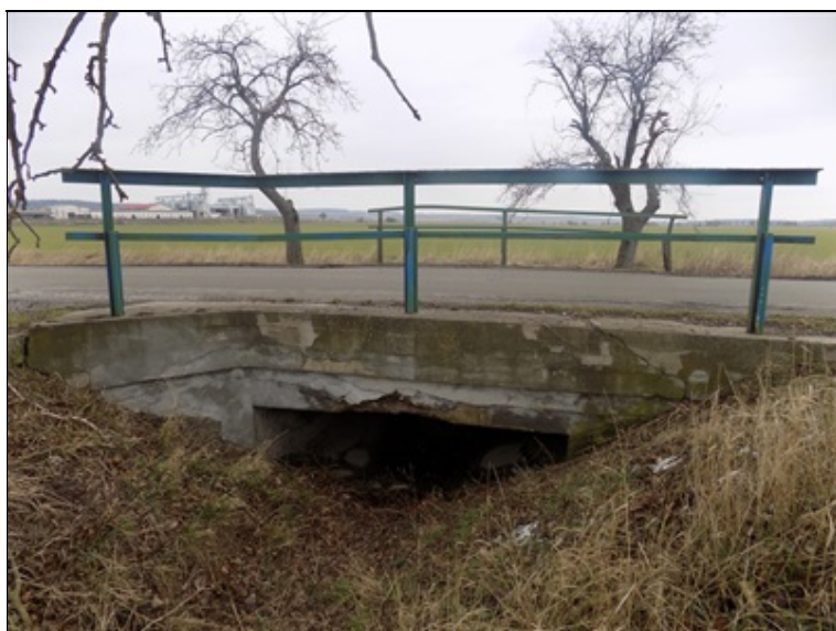
Pohled na levou stranu mostu.
