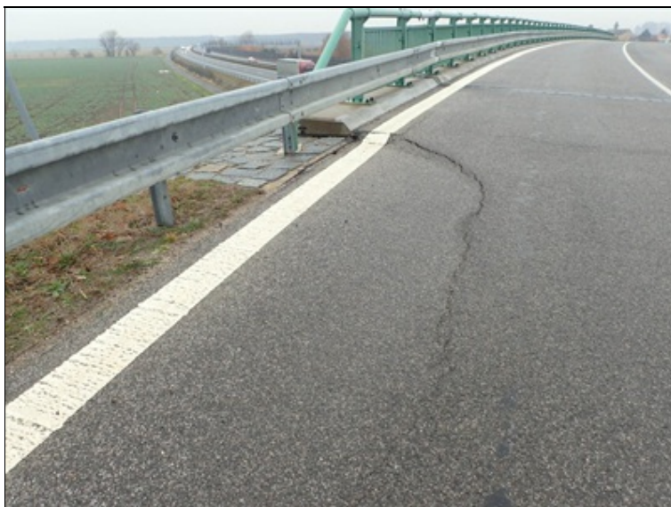
Levá krajnice na předpolí O1.
