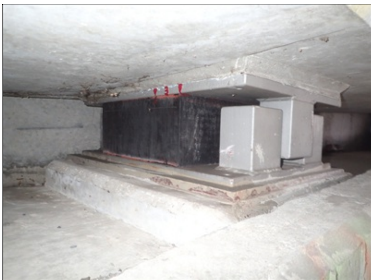
Opěra O1, celkový pohled na P ložisko.
