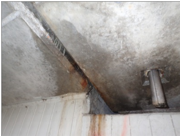
Opěra O1, pohled dilatační spáry s P konzolou NK.
