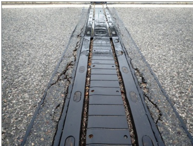
Mostní závěr nad O5, detail přejezdné plochy vozovkového úseku.
