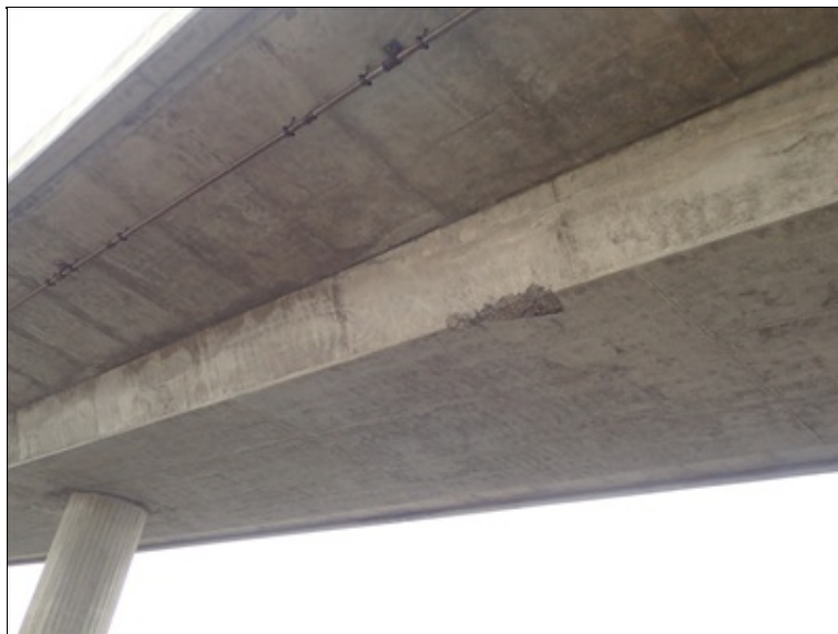
Podhled NK, pole 3 nad dálnicí.
