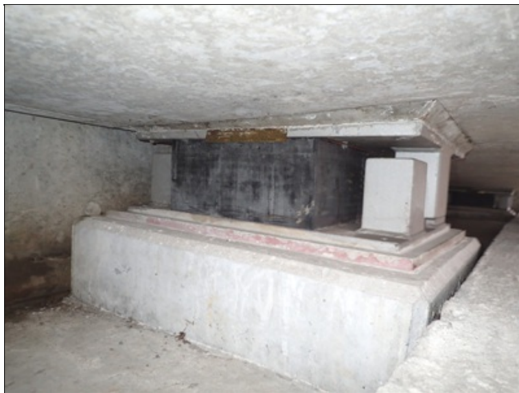
Opěra O5, celkový pohled na L ložisko.
