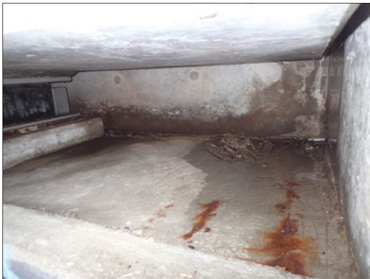
Opěra O5, P strana úložného prahu za boční plentou.
