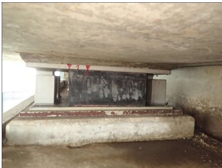
Opěra O5, P ložisko, kontrola podélného zkosení elastomeru.
