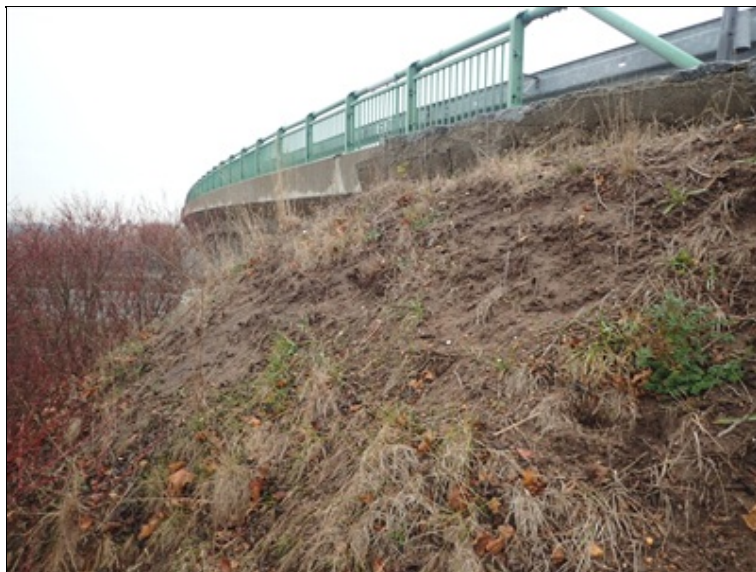
Nejspíše nestabilní mírně vyboulený svah zemního tělesa u boku L křídla O1, z vrcholu splavená zemina.
