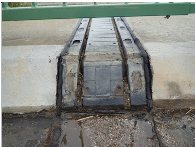
Mostní závěr nad O5, P římsový úsek.
