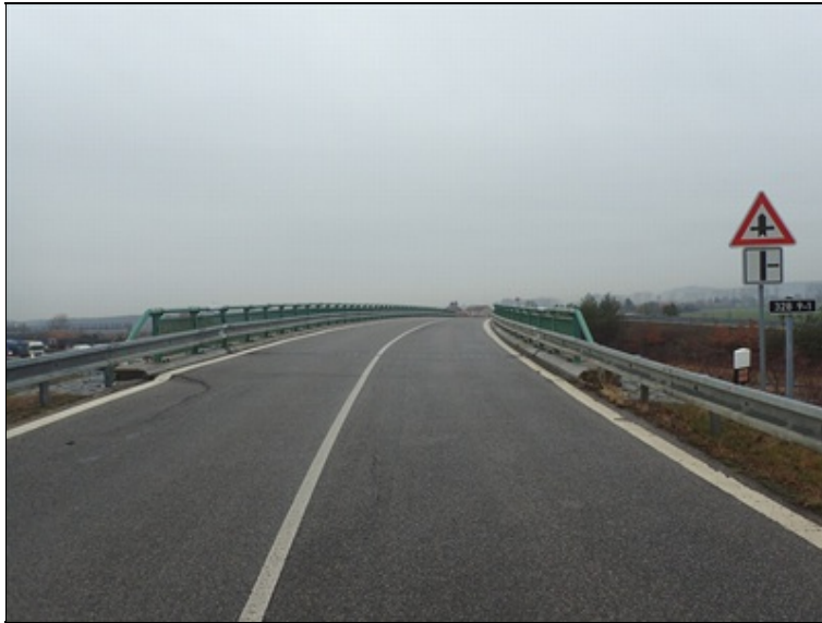
Prostorové uspořádání na mostě, pohled po směru staničení z předmostí O1.
