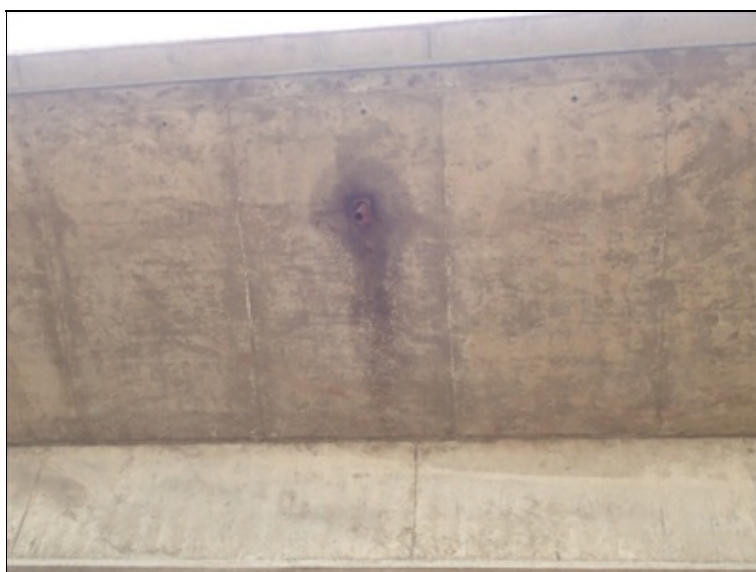
Pole 4, pohled P konzoly NK.
