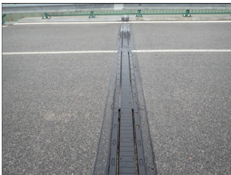
Pohled v linii mostního závěru nad O1.
