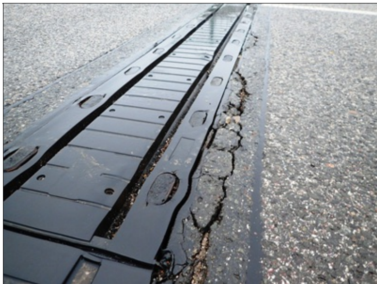
Mostní závěr nad O1, detail přejezdné plochy vozovkového úseku.
