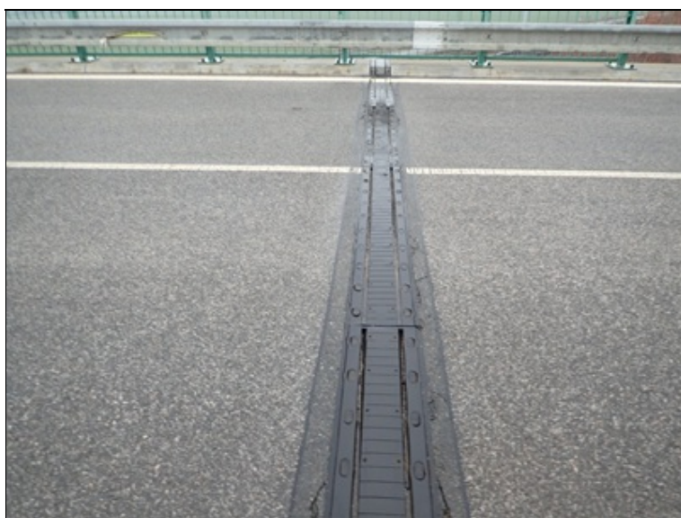
Pohled v linii mostního závěru nad O5.
