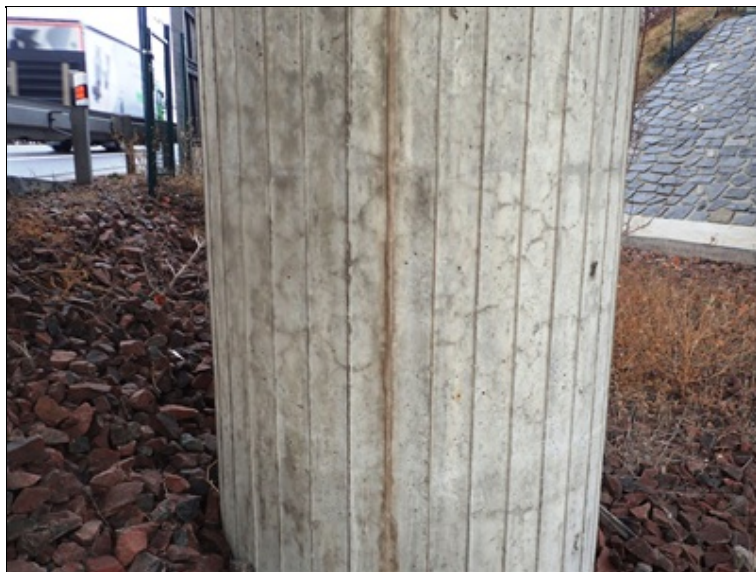
Pilíř P4, detail povrchu nad terémem.
