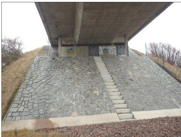
Zpevněný svah + líc opěry O1.
