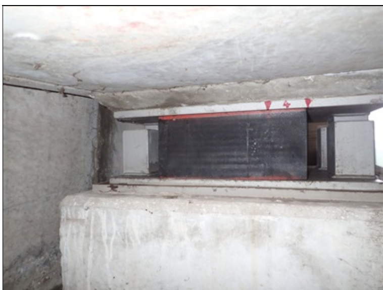
Opěra O1, L ložisko, kontrola podélného zkosení elastomeru.
