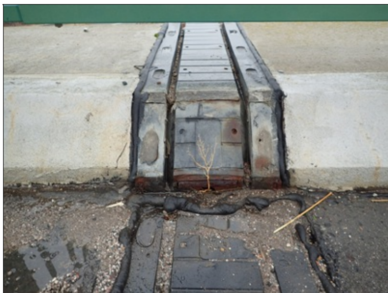
Mostní závěr nad O1, P římsový úsek.
