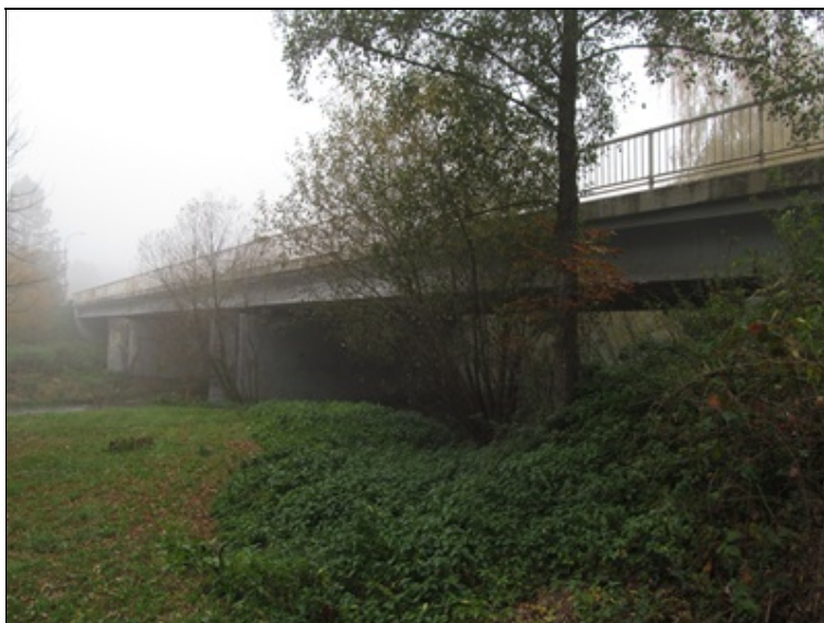
Pohled na most z levé strany
