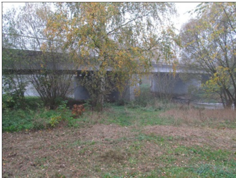
Pohled na most z pravé strany
