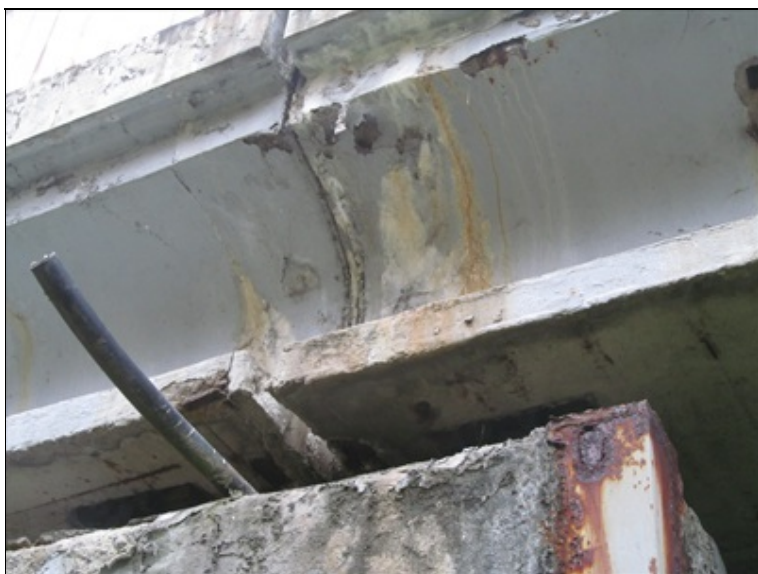
Nosná konstrukce nad P3
