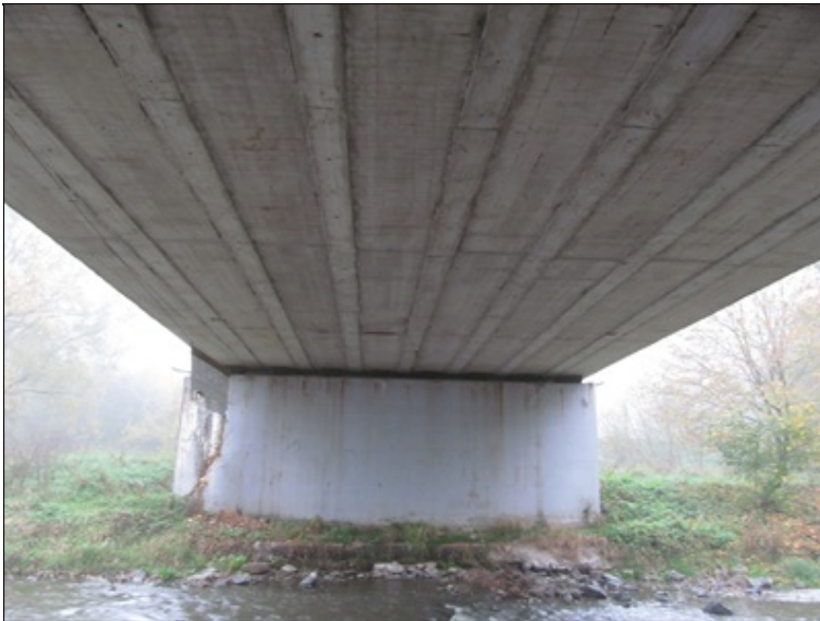
Pohled na P3, spodní líc nosné konstrukce 3. pole
