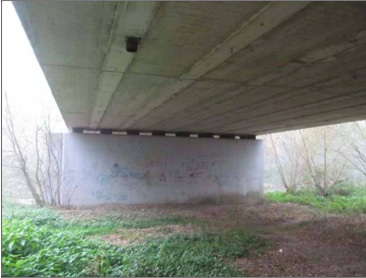
Pohled na P2, spodní líc nosné konstrukce 1. pole
