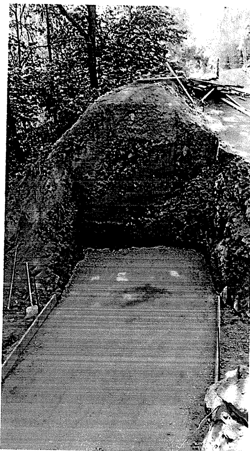
SO 104 – Zásyp ŠD fr. 0-32mm tl.= 0,5m pod základ (povodní strana)
