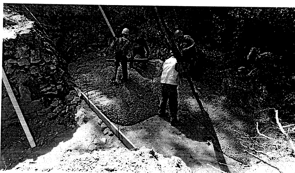
SO 104 - Betonáž podkladního beton
