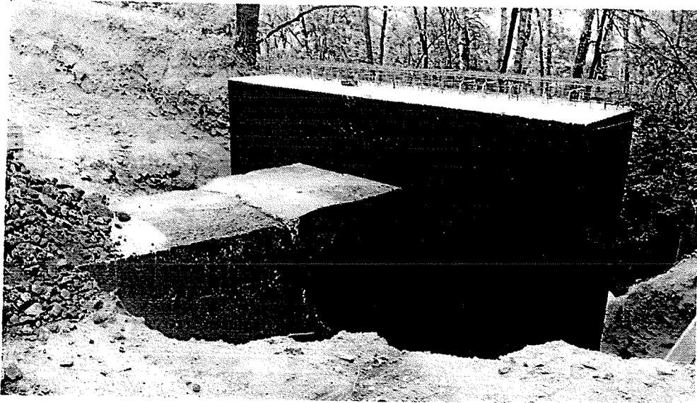
SO 104 – Pohled po aplikaci izolaci proti vlhkosti na rub.straně propustku (povodní strana)
