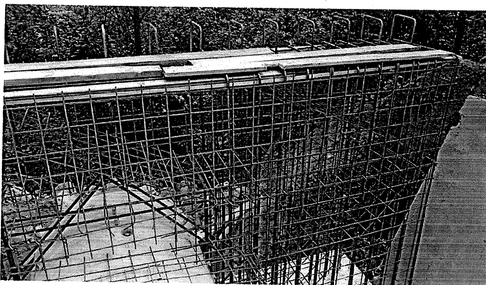
SO 104 – Armování čela propustku (povodní strana)
