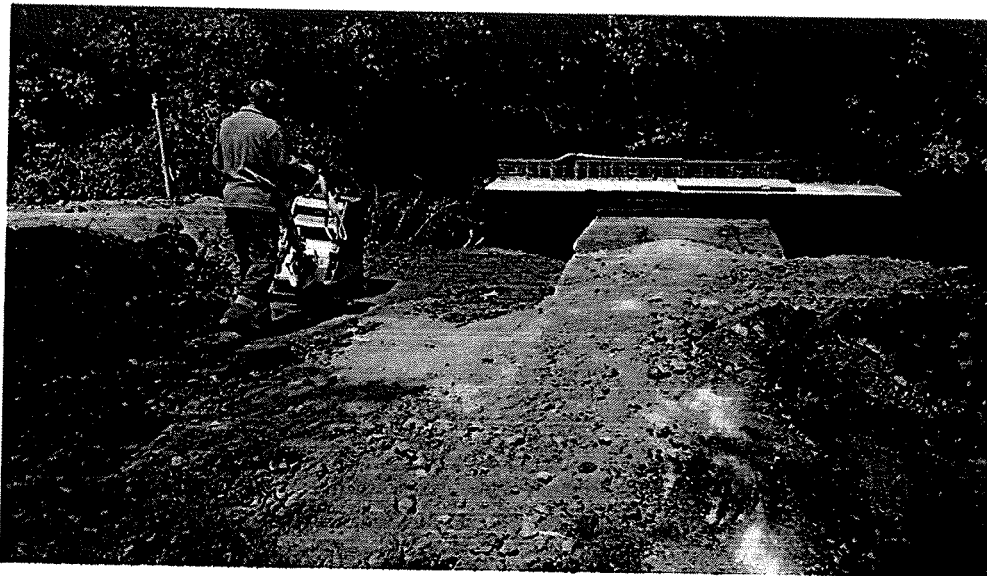
SO 104 – Zásyp a hutnění propustku v km 1,492 štěrkopískem
