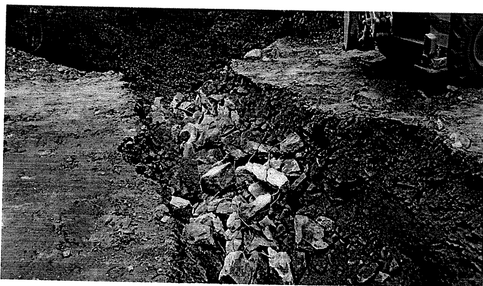
SO 101 - Pohled po zbourání propustku v km 1,492
