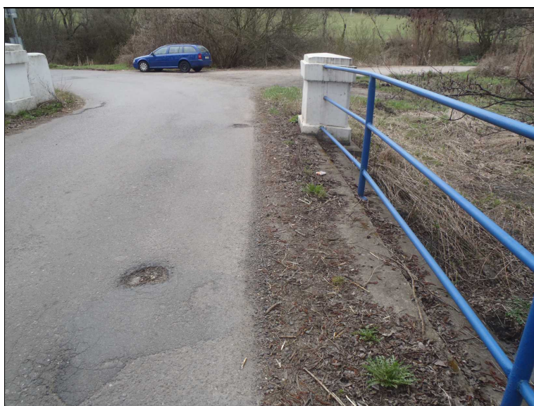
Nadvýšení vozovky, přelivná římsa a výtluk vlevo
