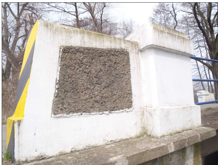
Trhlina v betonové části zábradlí vpravo
