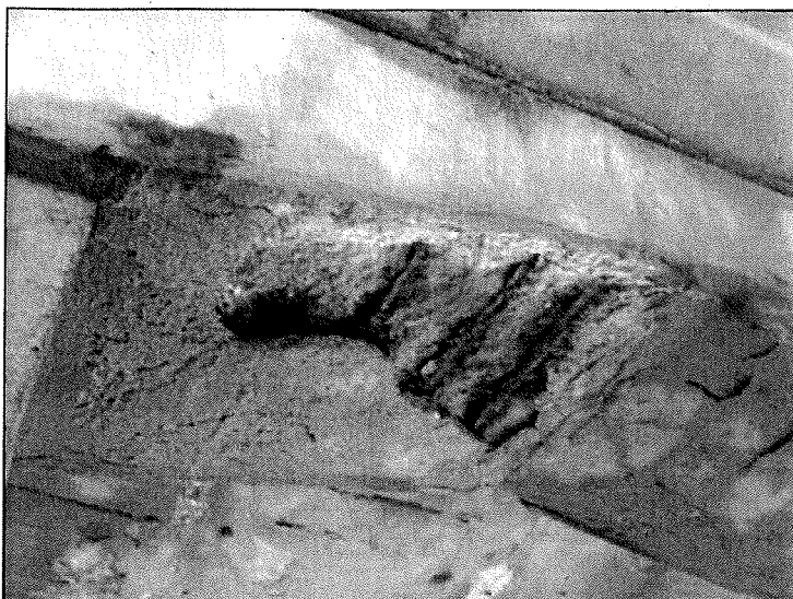
podhled stativa P7
