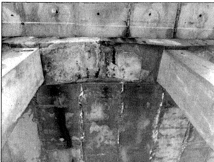
podhled stativa P6
