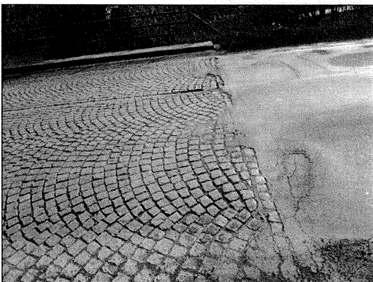
příčný pohled na vozovku nad O1
