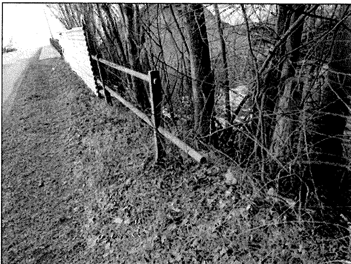
zábradlí na levé straně za mostem
