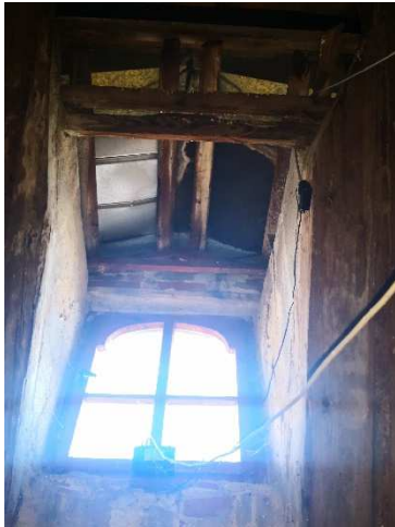
A5. Pohled na vikýř půdy z interiéru, který je v dezolátním stavu. V průběhu prohlídky byla zjištěna zcela nevyhovující oprava plechové krytiny, degradované venkovní omítky včetně lokální degradace zdiva, nefunkční oplechování vikýře a poškozená keramická střešní krytina štítu vikýře. Tento stav se opakuje na všech půdních vikýřích.
