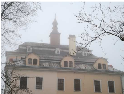
A25. Ilustrativní foto. Pohled na střechu ze severní strany.
