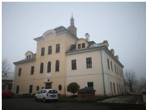
A27. Ilustrativní foto. Pohled na střechu z východní strany.
