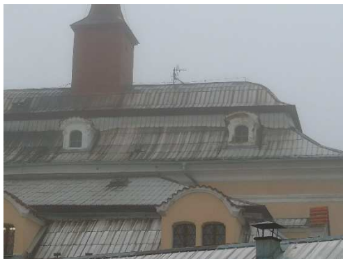
A26. Ilustrativní foto. Pohled na střechu z jižní strany.
