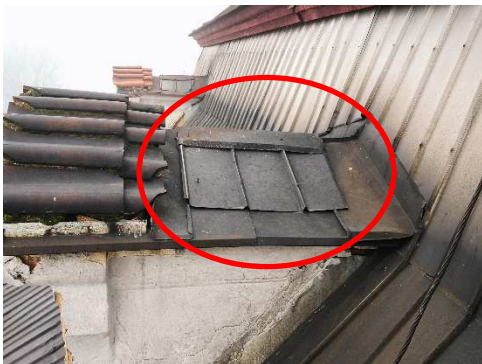
A5. Pohled na vikýř půdy z interiéru, který je v dezolátním stavu. V průběhu prohlídky byla zjištěna zcela nevyhovující oprava plechové krytiny, degradované venkovní omítky včetně lokální degradace zdiva, nefunkční oplechování vikýře a poškozená keramická střešní krytina štítu vikýře. Tento stav se opakuje na všech půdních vikýřích.
