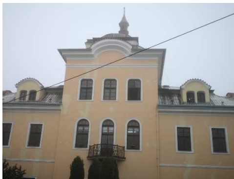
A28. Ilustrativní foto. Pohled na střechu ze západní strany.
