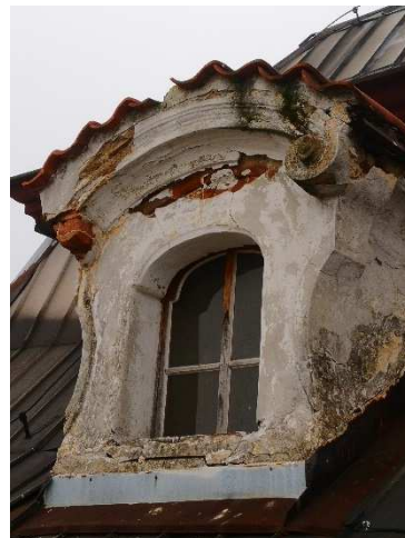
A8. Pohled na vikýř půdy z exteriéru. Dále viz předchozí komentář k foto A5.
