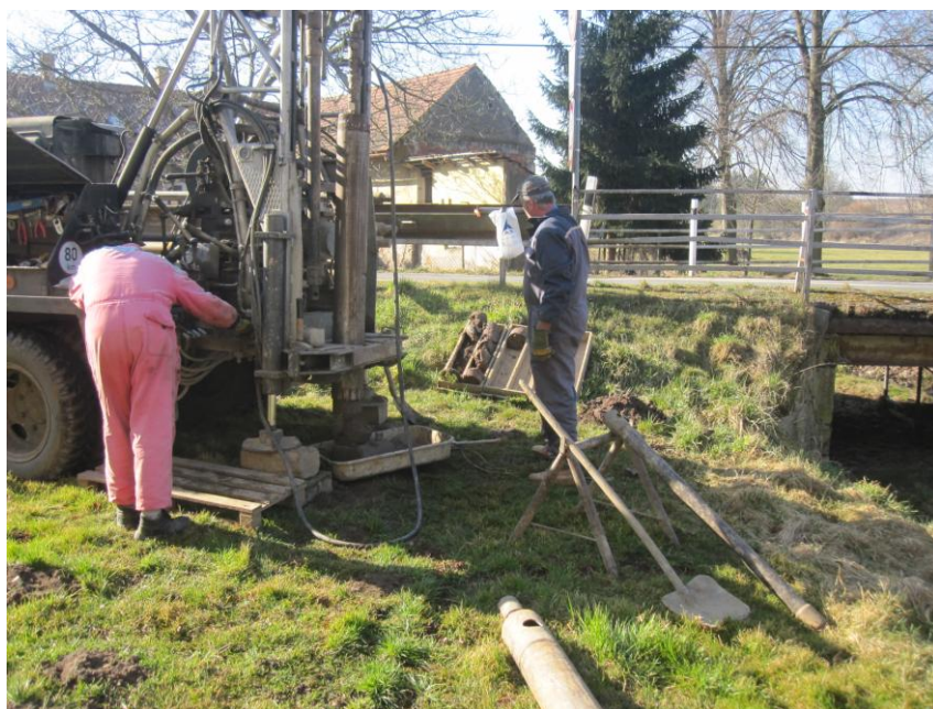
Vrtná souprava při hloubení sondy V1
