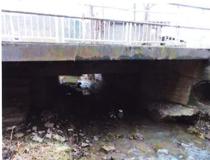
Pohled na pravou stranu mostu.
