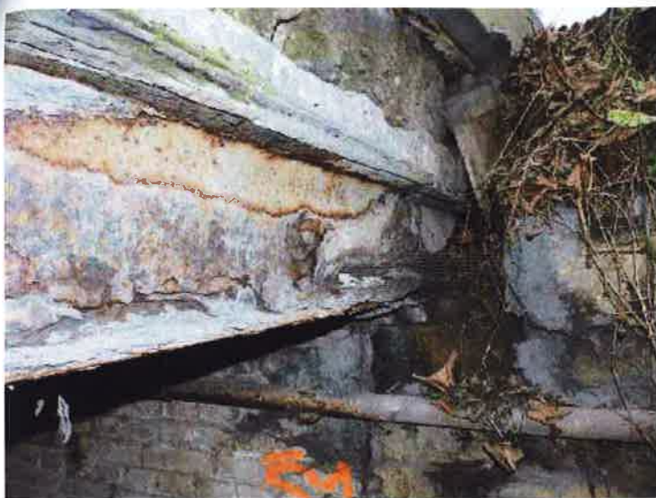
Pohled na krajní nosník na levé straně mostu.
