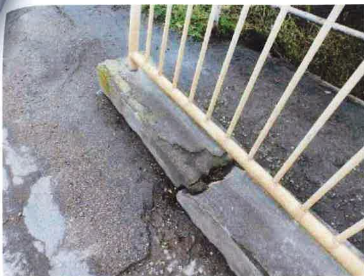
Přeražená římsa na pravé straně nad OP2.
