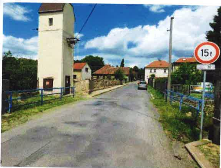
Pohled na most proti směru staničení.
