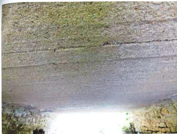
Podhled nosné konstrukce.
