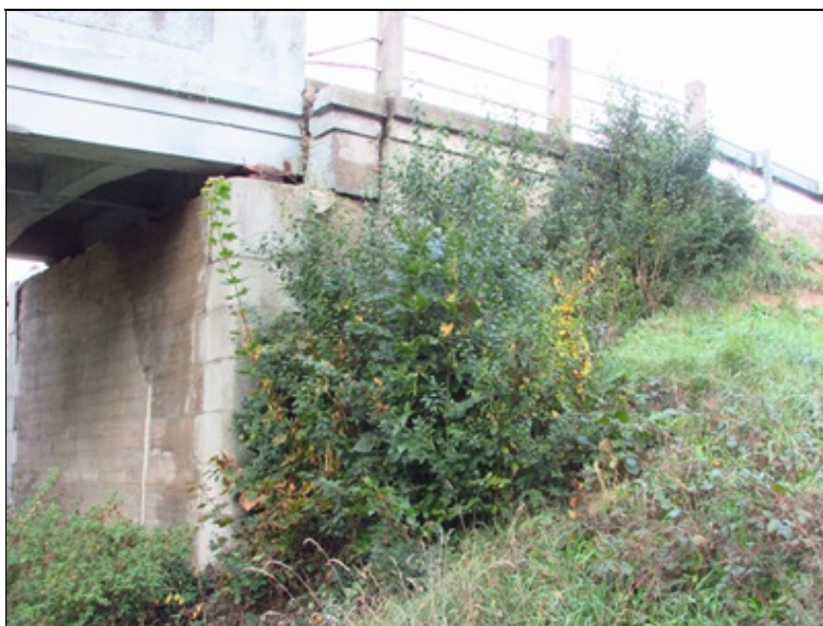
Levé křídlo OP1
