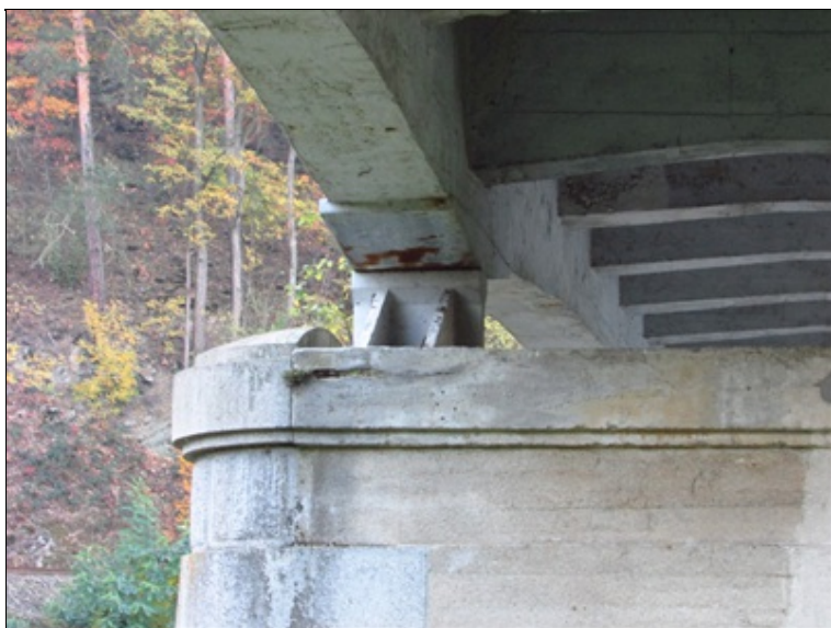
Pevné ložisko na P2
