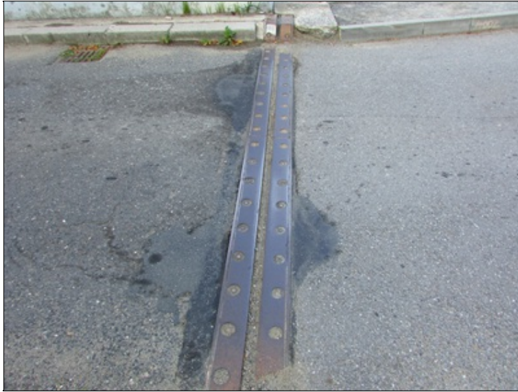
Mostní závěr nad OP1
