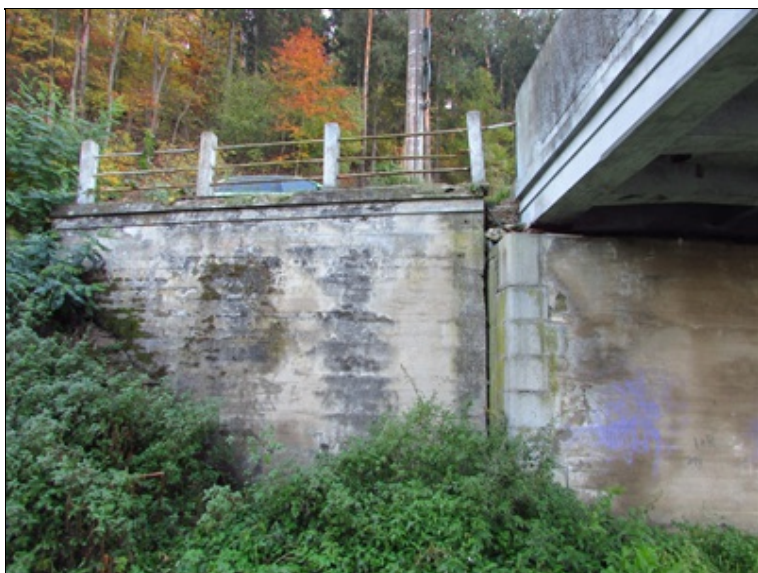
Levé křídlo OP4
