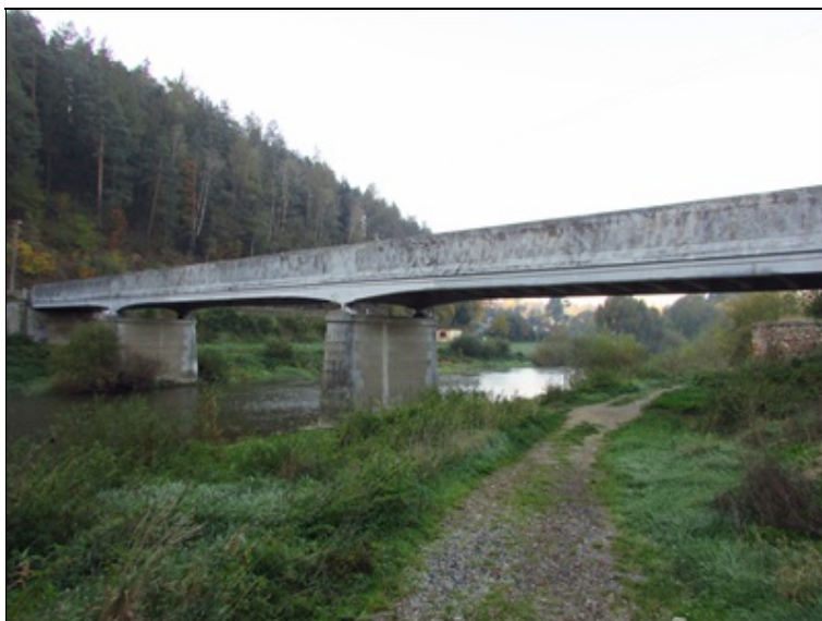
Pohled na most z levé strany
