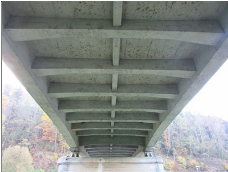
Spodní líc nosné konstrukce, 1. pole
