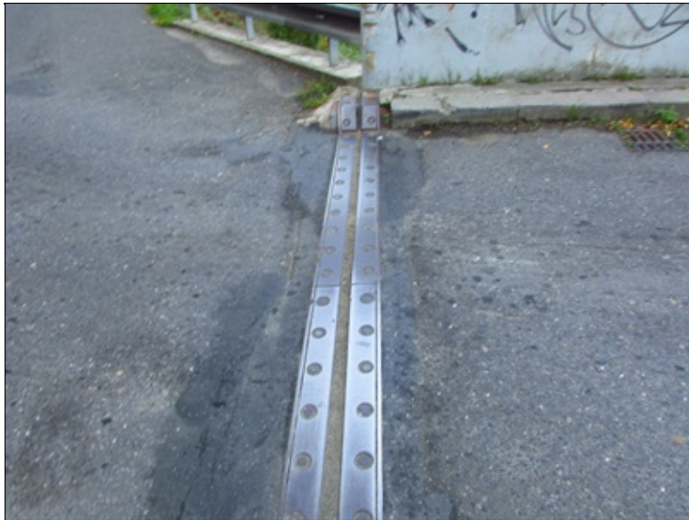
Mostní závěr nad OP4
