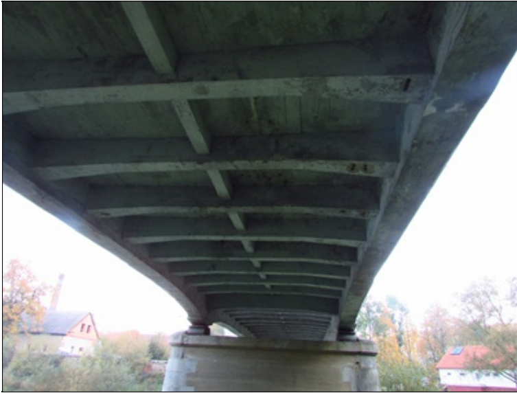
Spodní líc nosné konstrukce, 3. pole
