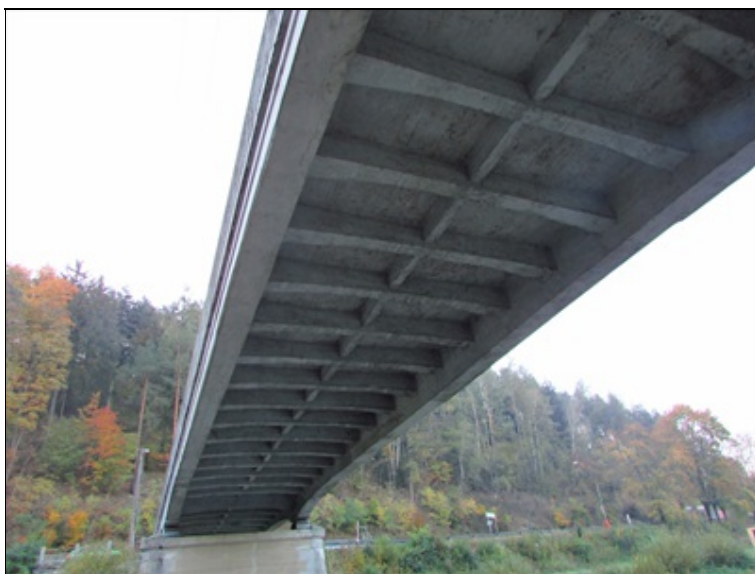
Spodní líc nosné konstrukce, 2. pole
