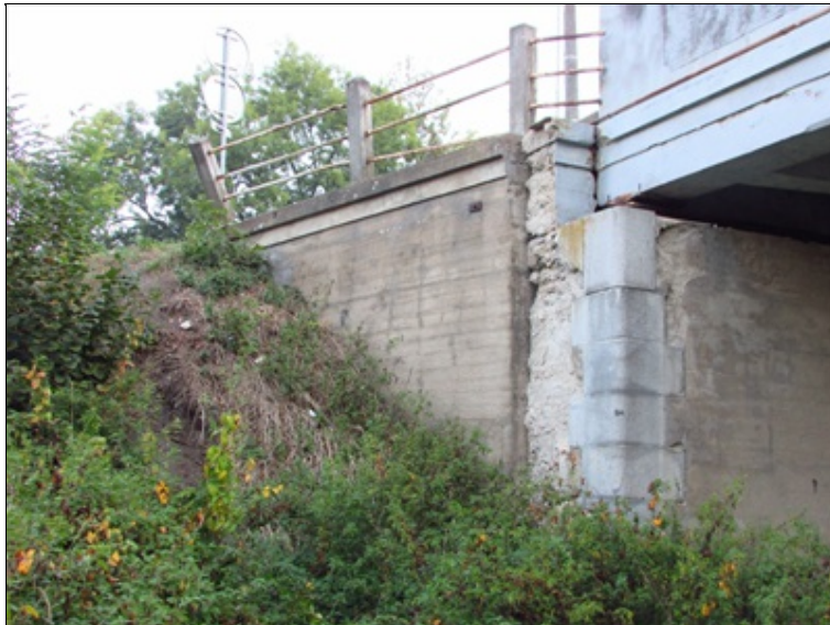
Pravé křídlo OP1 je vykloněné. Hlubková degradace betonu OP1
