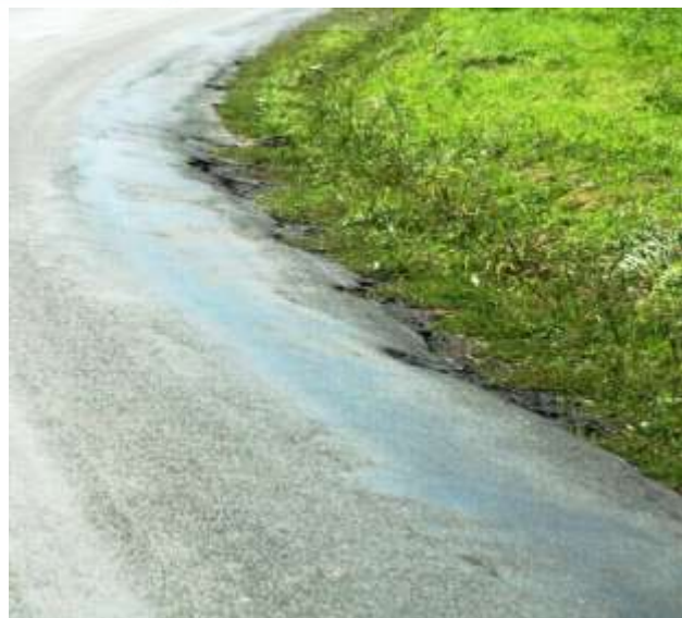
Postupné olamování krajů vozovky způsobené zanesením příkopů.
