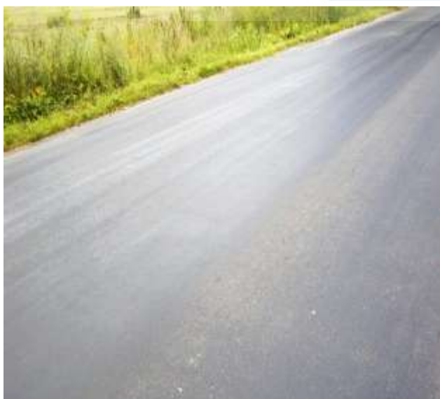
Ztráta makrotextury v celé šířce vozovky.
