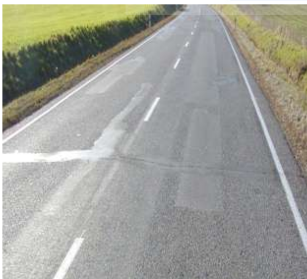
Příčná trhlina ošetřená nátěrem.
