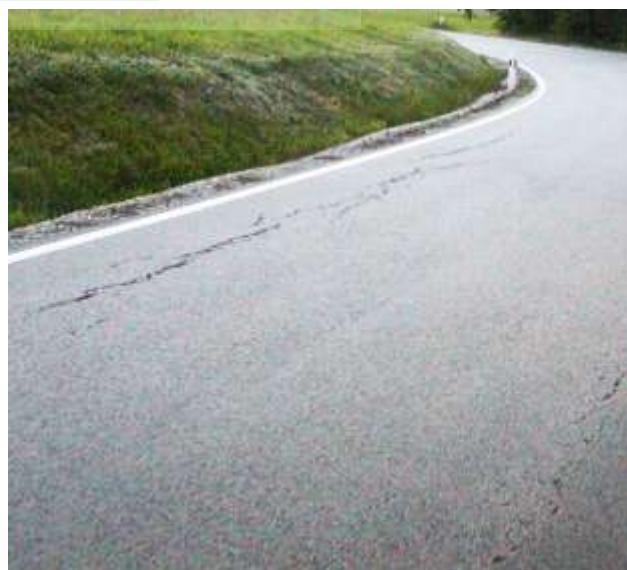
Podélná trhlina v jízdní stopě vozidel.
