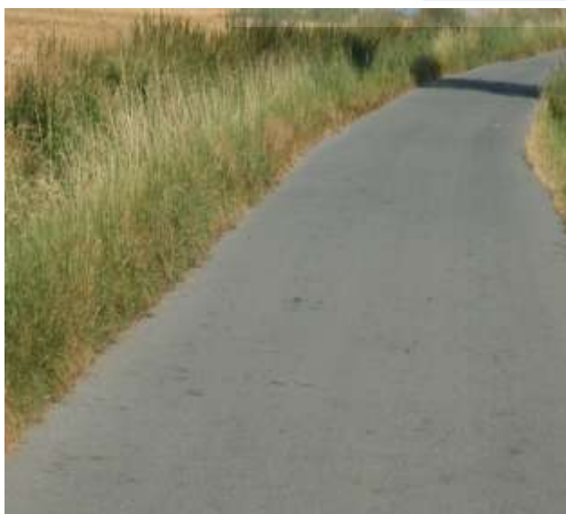
Extremně zvýšený porost na krajnici.
