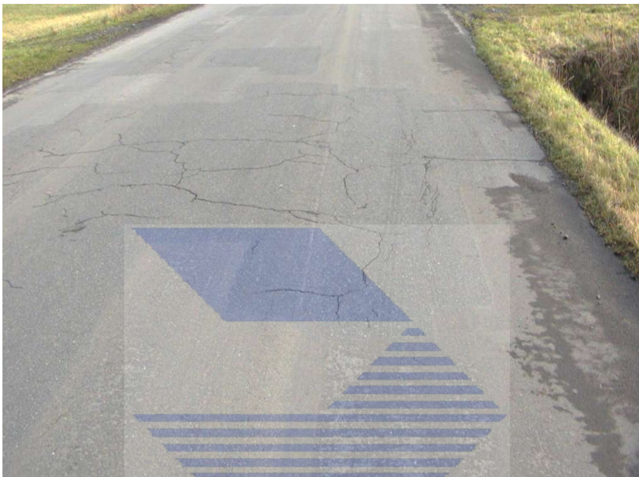
Lokální výskyt mozaikových trhlin.
