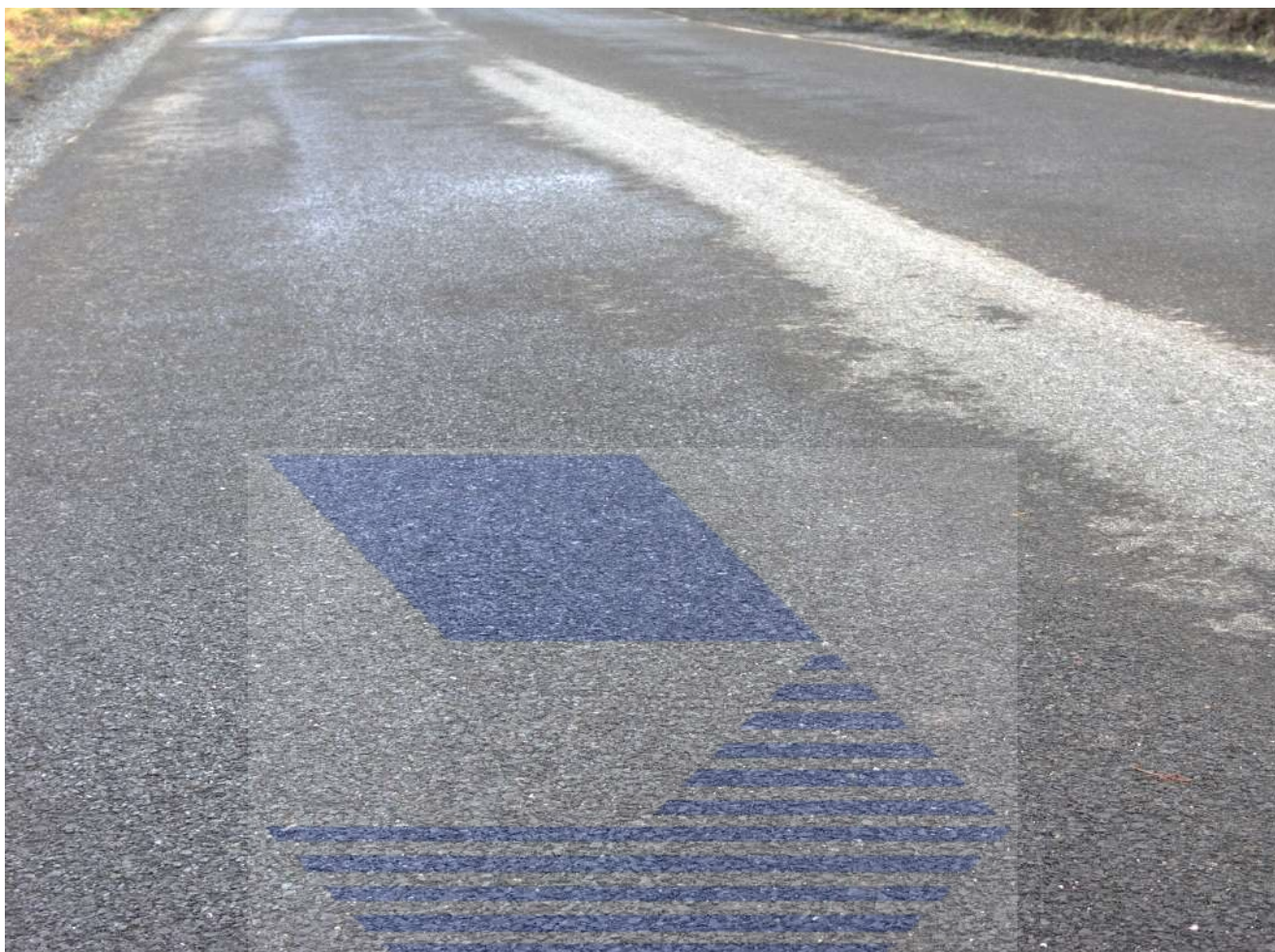
Povrch vozovky s hrubozrnou texturou.
