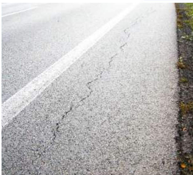
Úzká trhlina u okraje vozovky.
