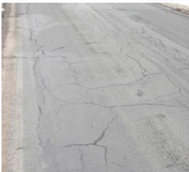
Mozaikové trhliny vzniklé z rozvětvených trhlin.
