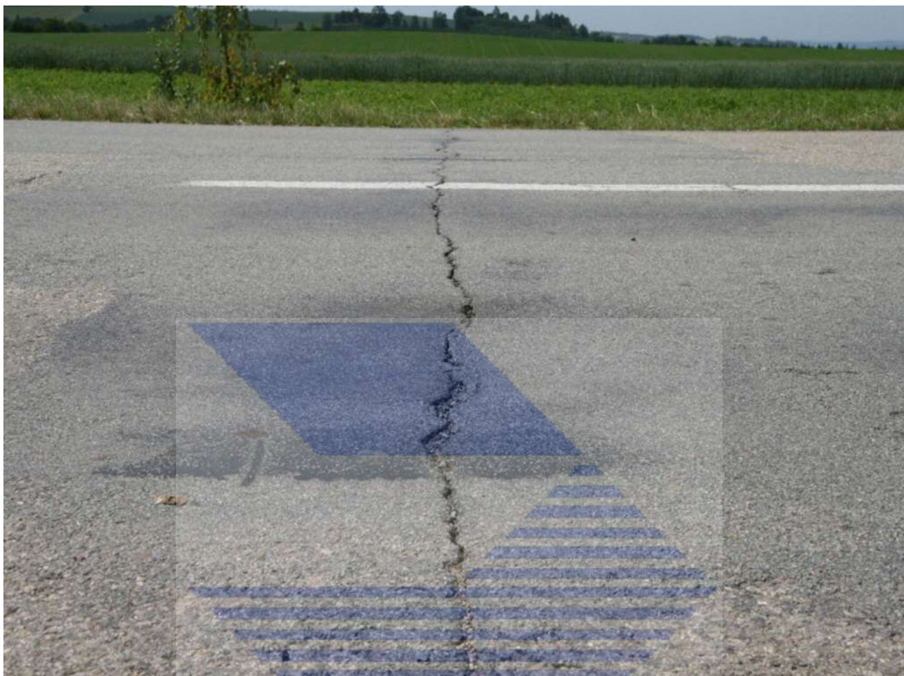
Příčná trhlina částečně překrytá nátěrem.
