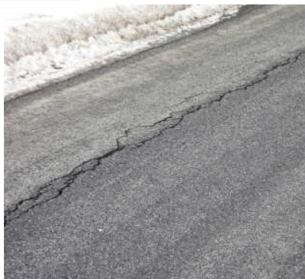
Rozvětvená podélná trhlina způsobená mrazem.
