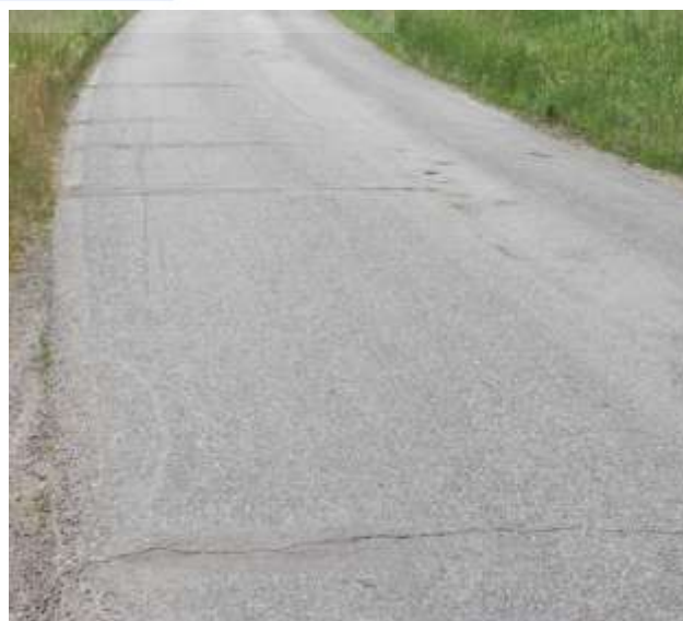
Několik úzkých příčných trhlin jdoucích za sebou.
