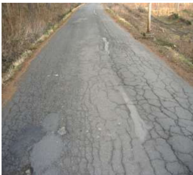
Síťové trhliny s deformací vozovky.
