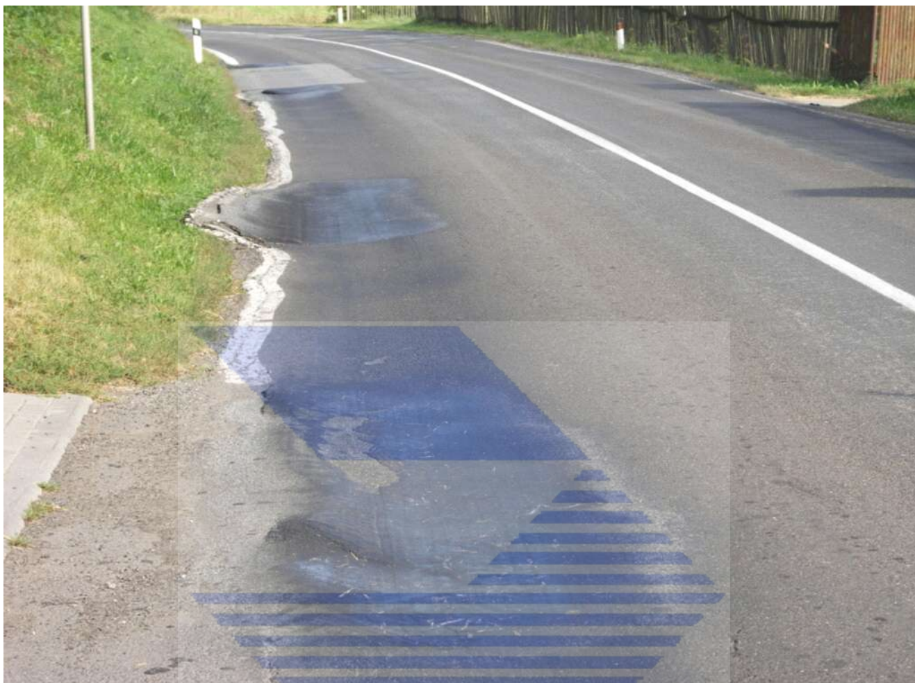
Nepravidelné hrboly vzniklé porušením vysprávek obrusné vrstvy.
