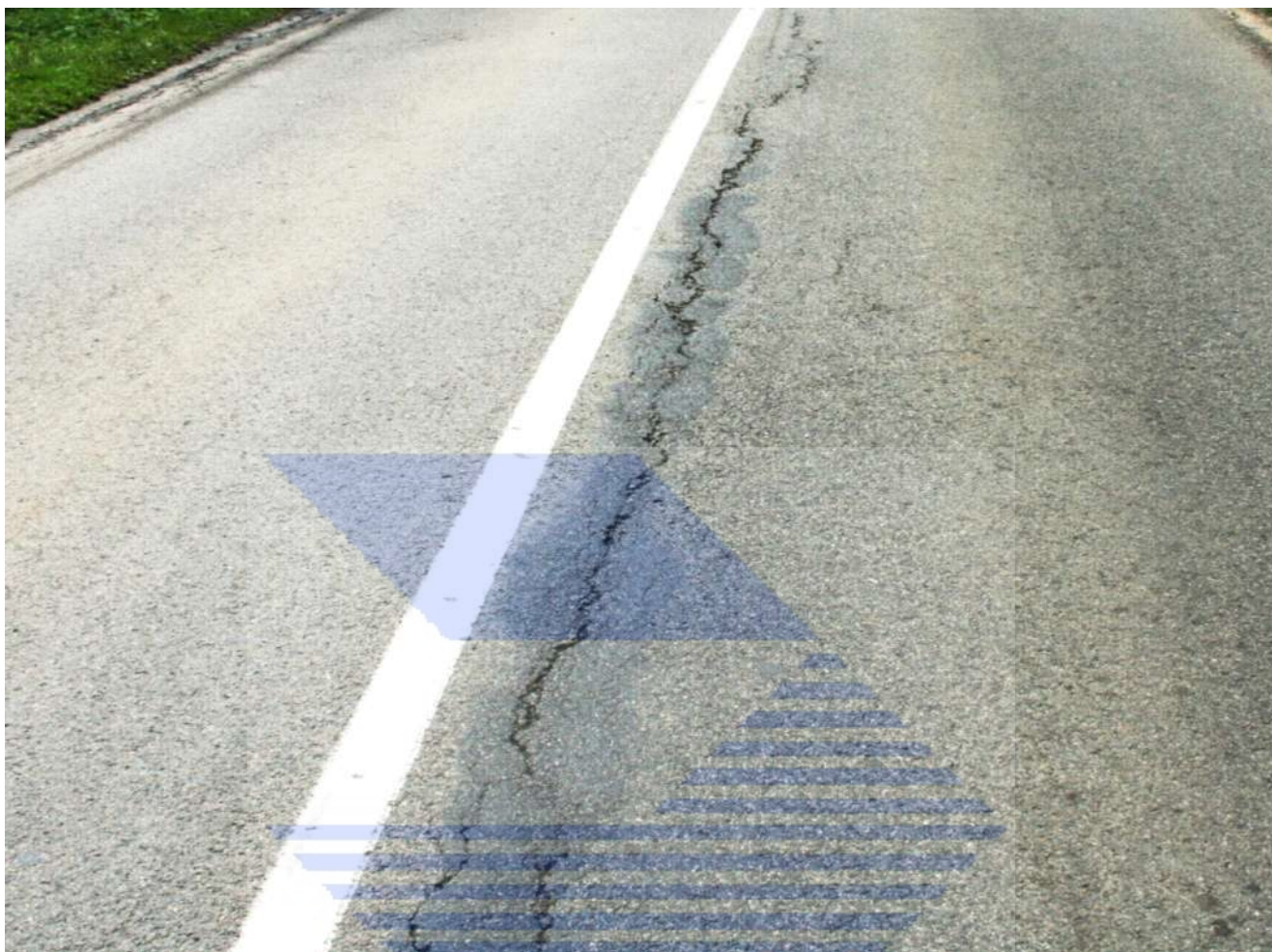
Prokopírování široké trhliny přes vysprávkou.
