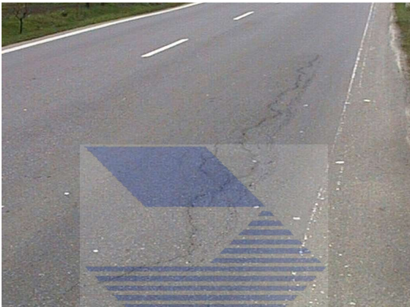
Trhlina podélná rozvětvená v jízdní stopě vozidel s vývojem k síťovým trhlinám.
