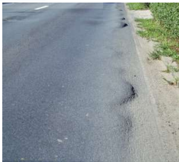
Nepravidelné hrboly vzniklé vytlačeníím asfaltové směsi z jízdní stopy vozidel.
