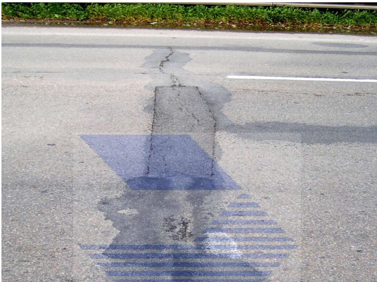
Prokopírování příčné trhliny s přidruženými trhlinami vysprávkou.
