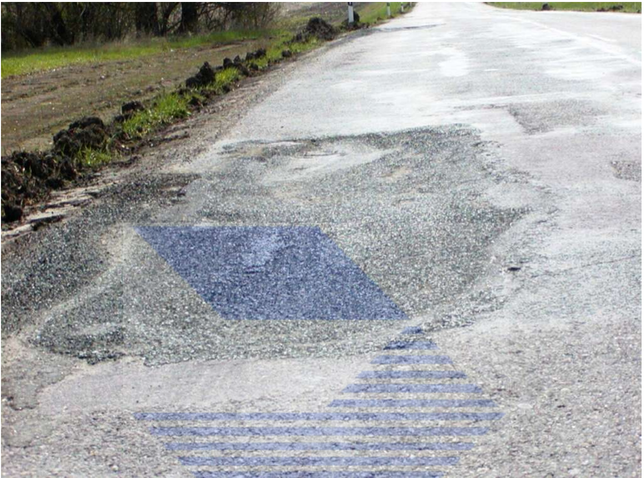
Lokální pokles vozovky velkého rozsahu.
