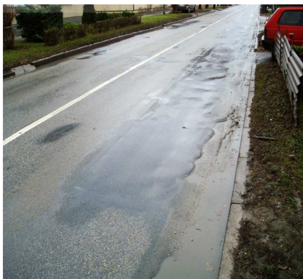
Deformace v jízdní stopě vozidel.
