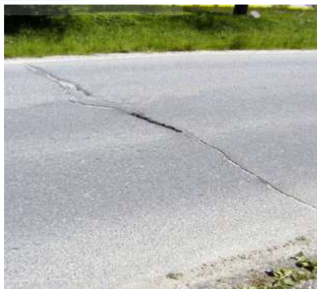
Široká trhlina procházející celou šířkou vozovky.
