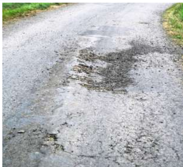
Prolomení uprostřed konstrukce vozovky.
