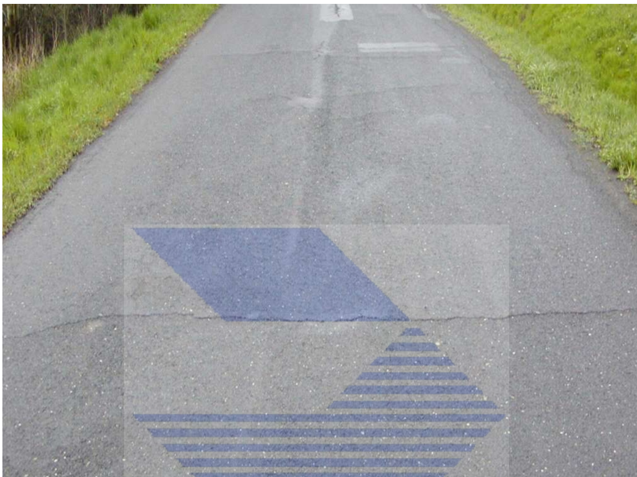
Trhlina úzká příčná přes celou šířku vozovky.
