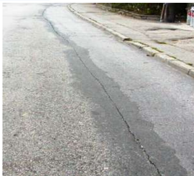
Trhlina na podélné spáře prokopírovaná přes nátěr.
