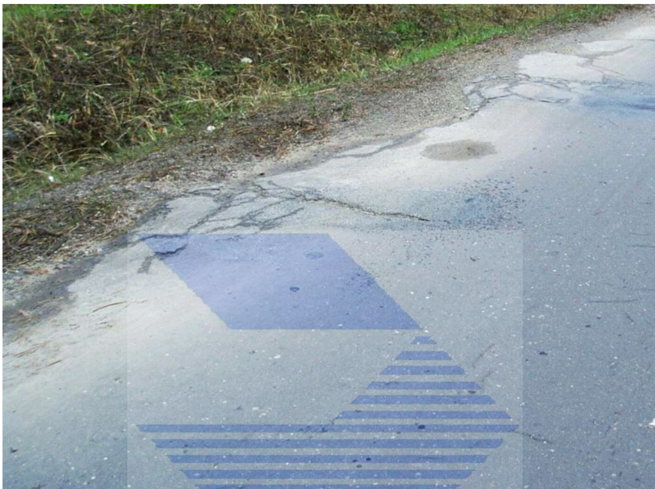
Místní hrboly doprovázené tvorbou trhlin.
