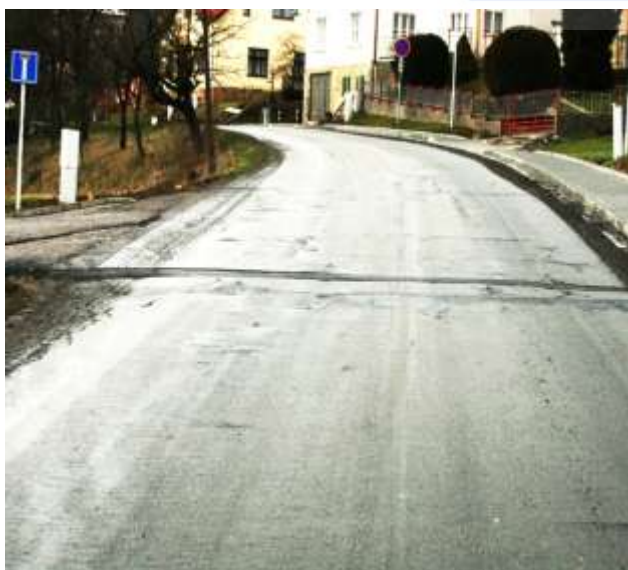
Prohlubeň vzniklá nedostatečným zhutněním záspy rýhy.
