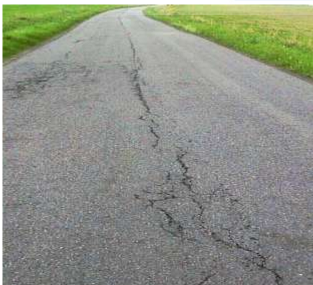
Rozvětvená trhlina na podélné spáře.
