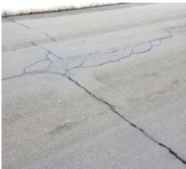
Kombinace široké příčné trhliny s rozvětvenou podélnou.
