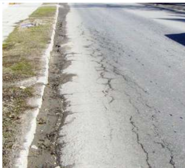
Lokální výskyt síťových trhlin v jízdní stopě vozidel.
