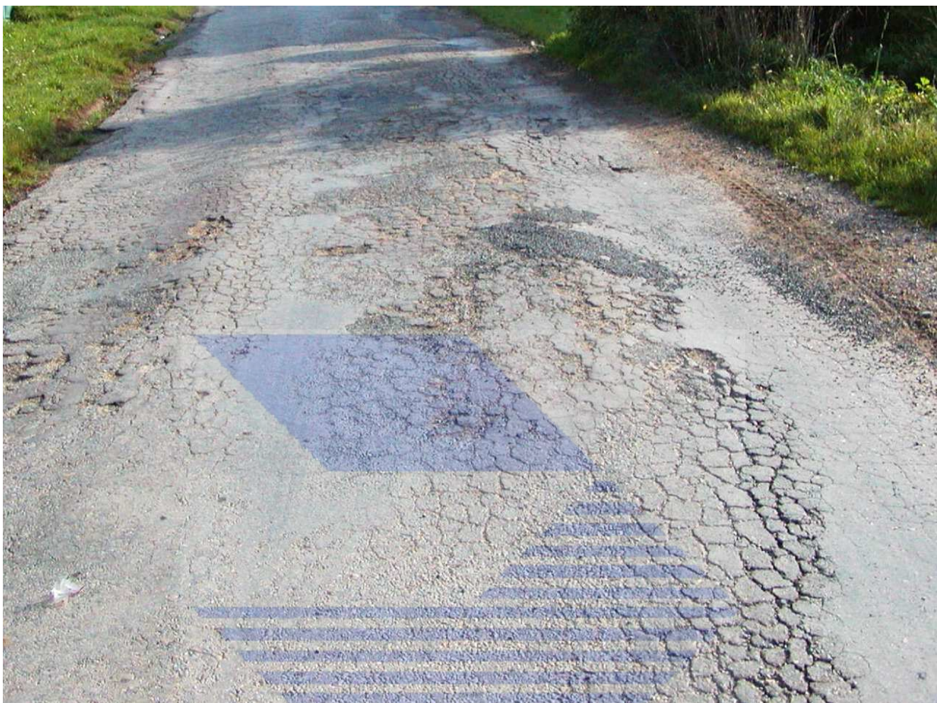
Plošná deformace se ztrátou únosnosti vozovky.
