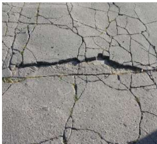
Výtluk vzniklý z mozaikových trhlin.
