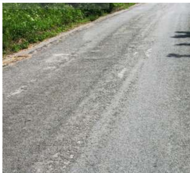
Postupná ztráta kameniva z nátěru.
