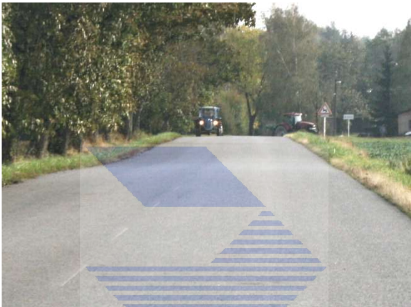
Pokles vzniklý poklesem zemního tělesa.
