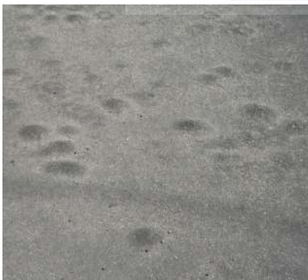
Souvislý výskyt puchýřů v ohrusné vrstvě.
