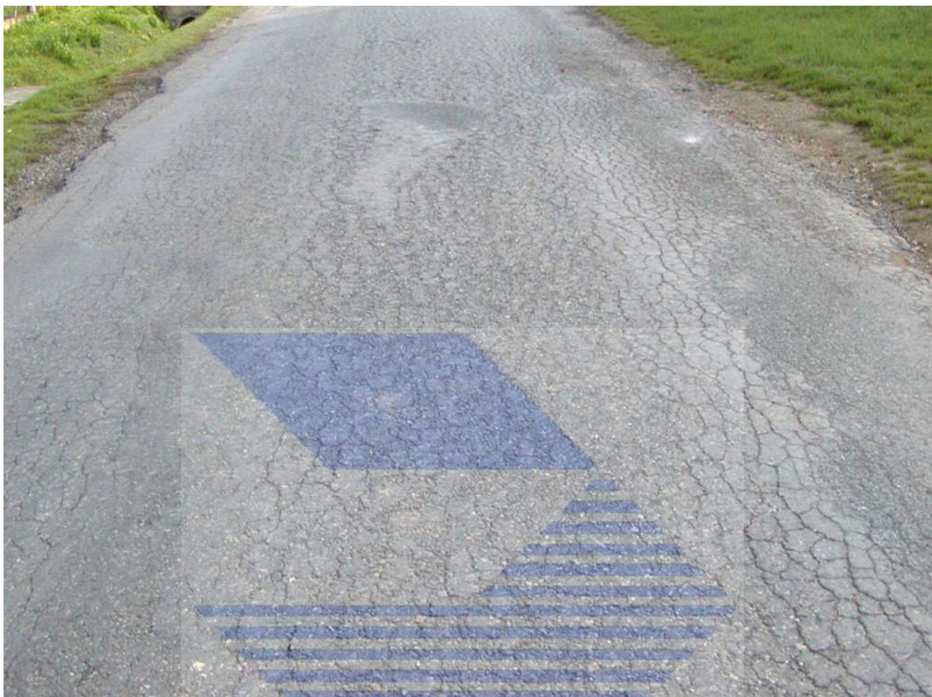
Síťové trhliny přes celou šířku vozovky.
