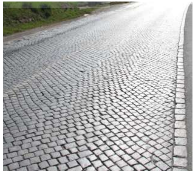
Ztráta mikrotextury na dlážděné vozovce.
