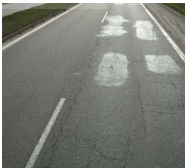
Prokopírování mozaikových trhlin přes nátěr.
