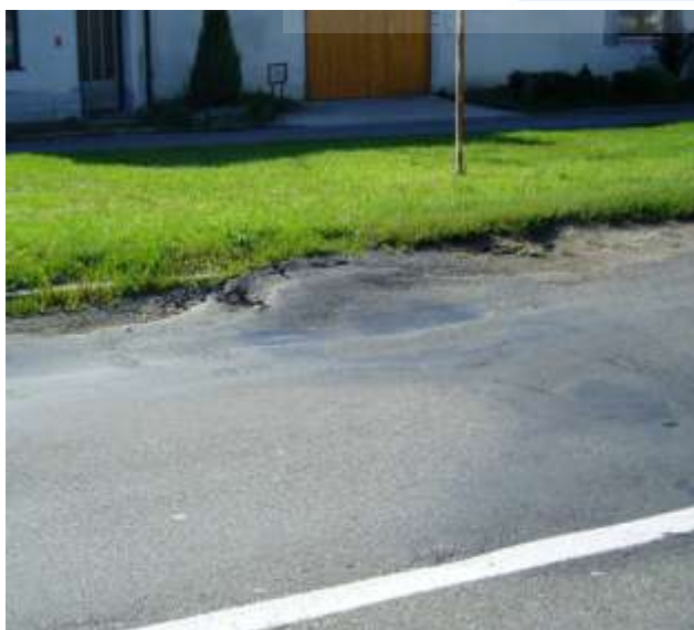
Hrbol vzniklý vytlačeníím asfaltové směsi mimo vozovku.
