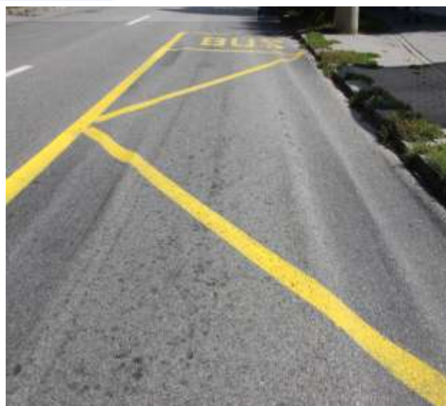
Vyjeté koleje způsobené zastavujícími autobusy na zastávce.
