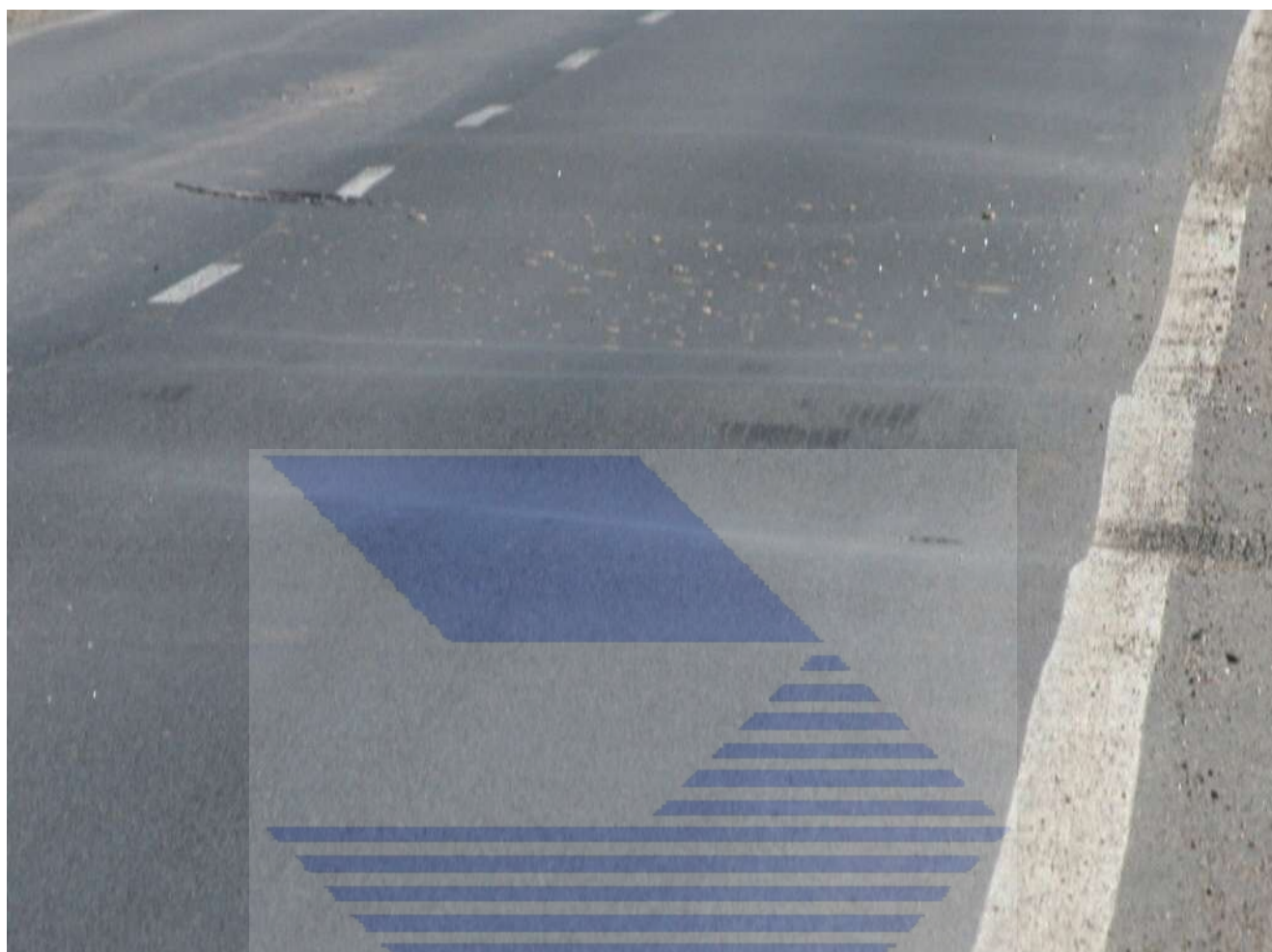
Podélné hrboly způsobené objemovými změnami.
