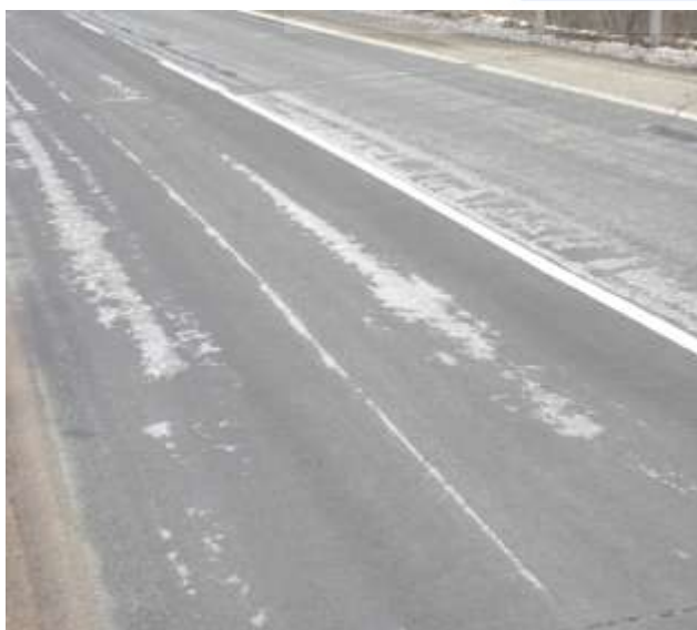
Opotřebení kalové vrstvy.
