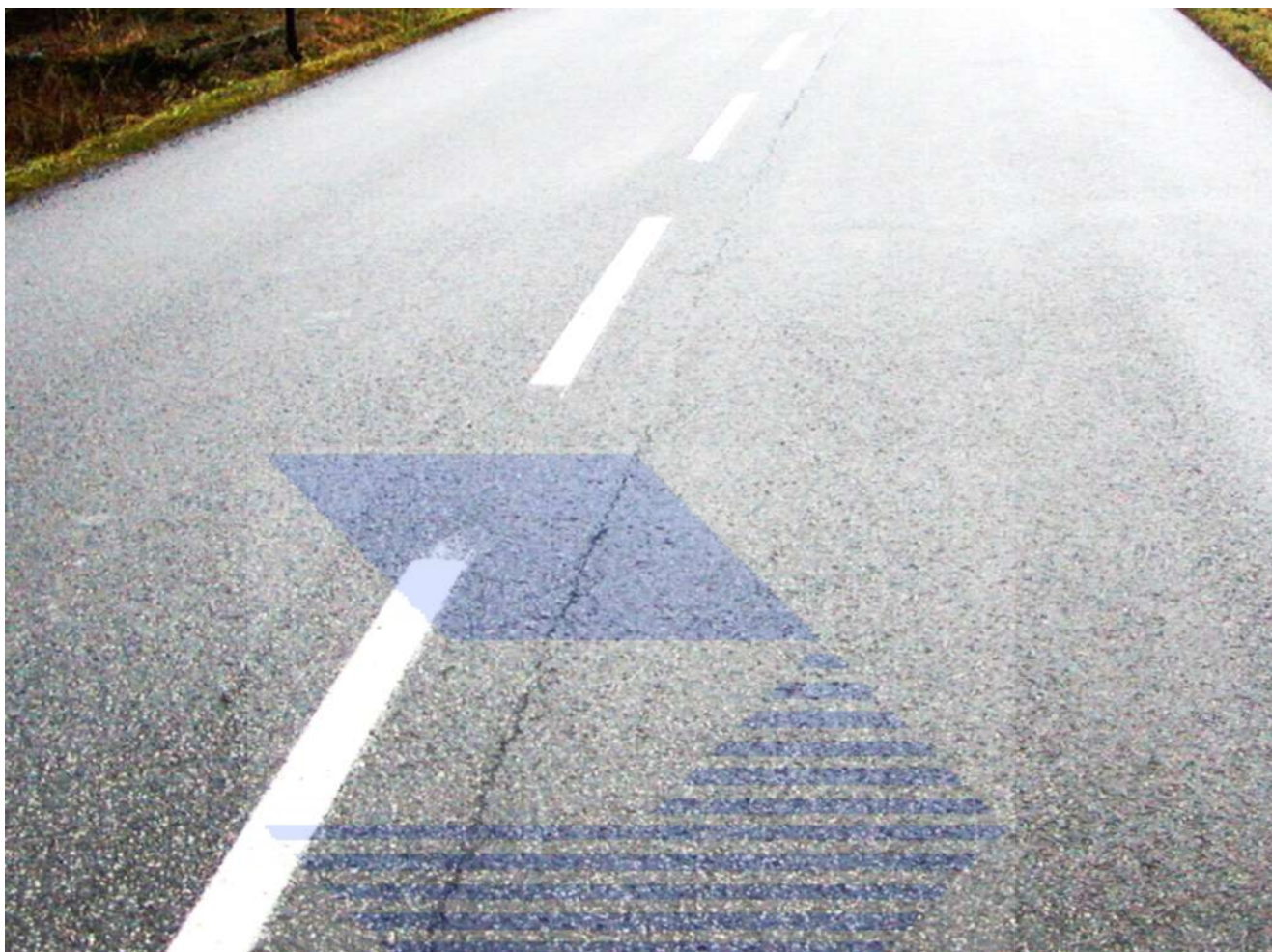
Trhlina uprostřed vozovky.
