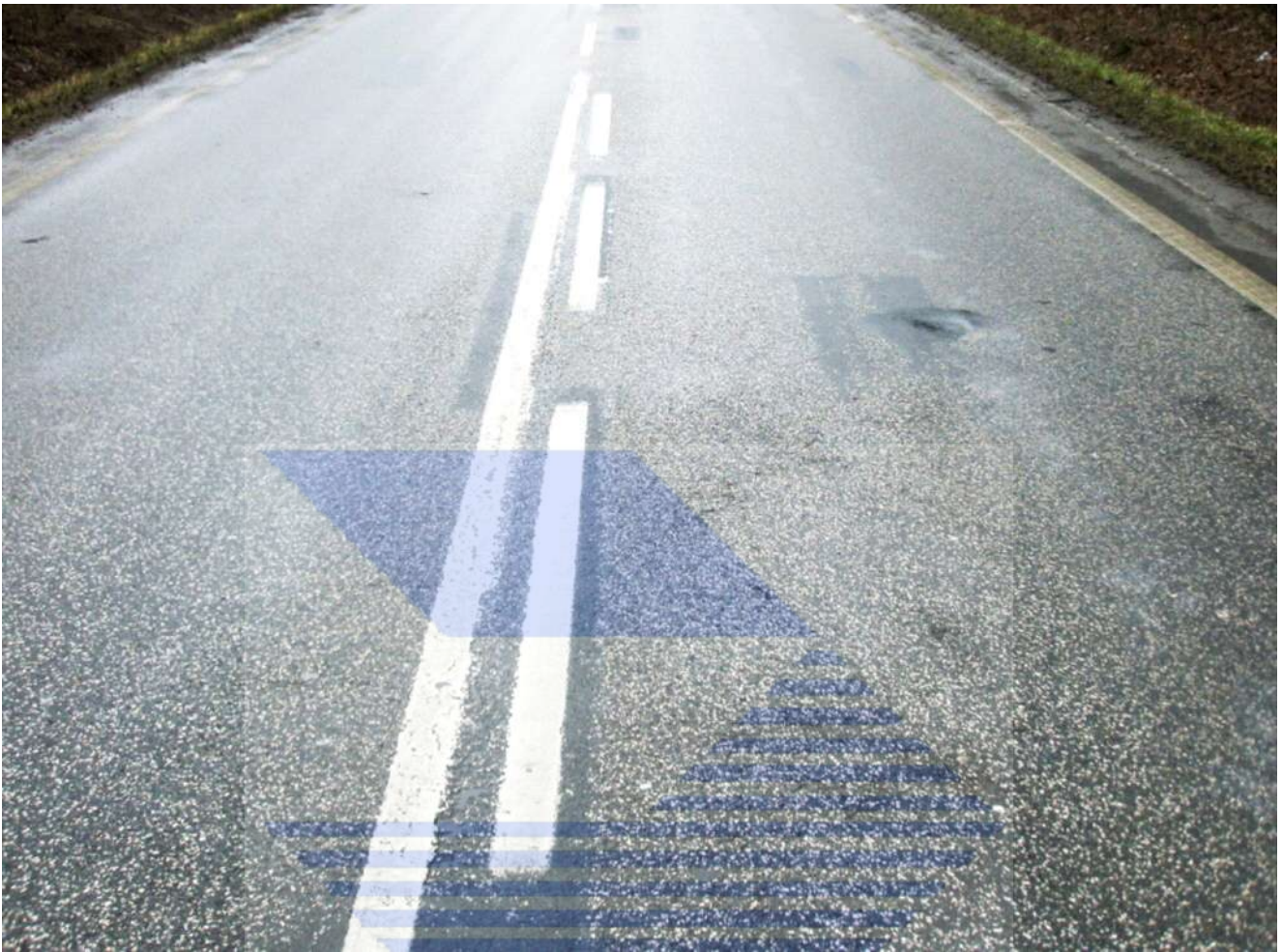
Lesknoucí se vyhlazený povrch vozovky.
