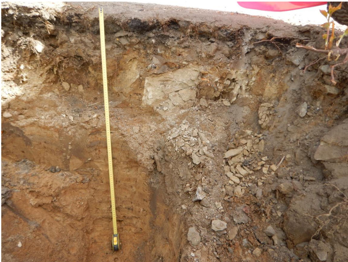
Skladba podkladního souvrství vozovky v místě kopané sondy č. 1
