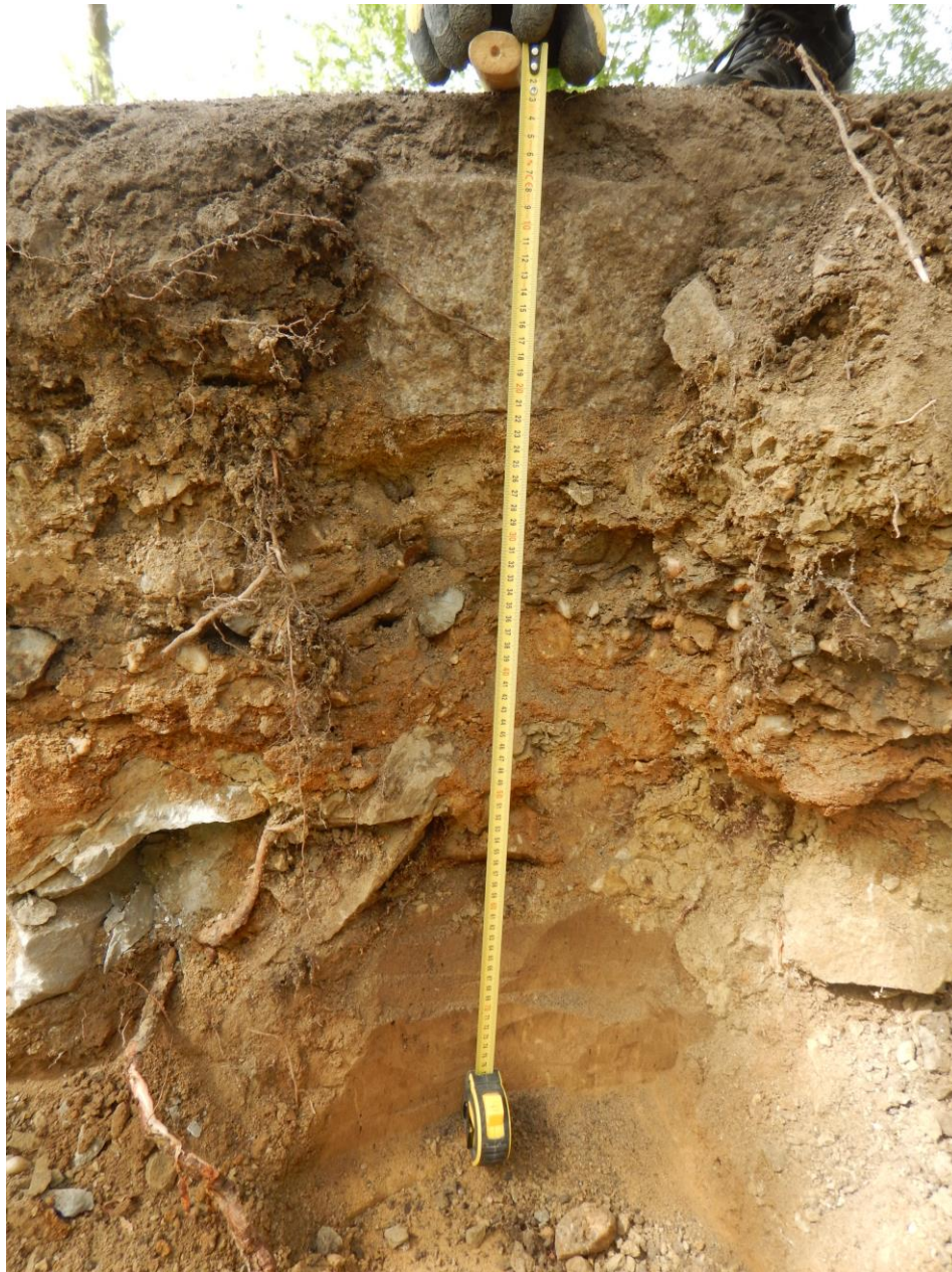
Skladba podkladního souvrství vozovky v místě kopané sondy č. 2
