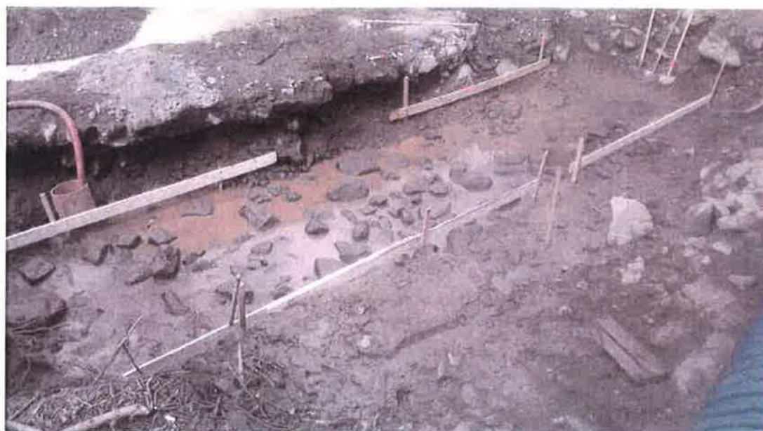
Ve výkopu odkryté kameny a balvany granodioritu.
