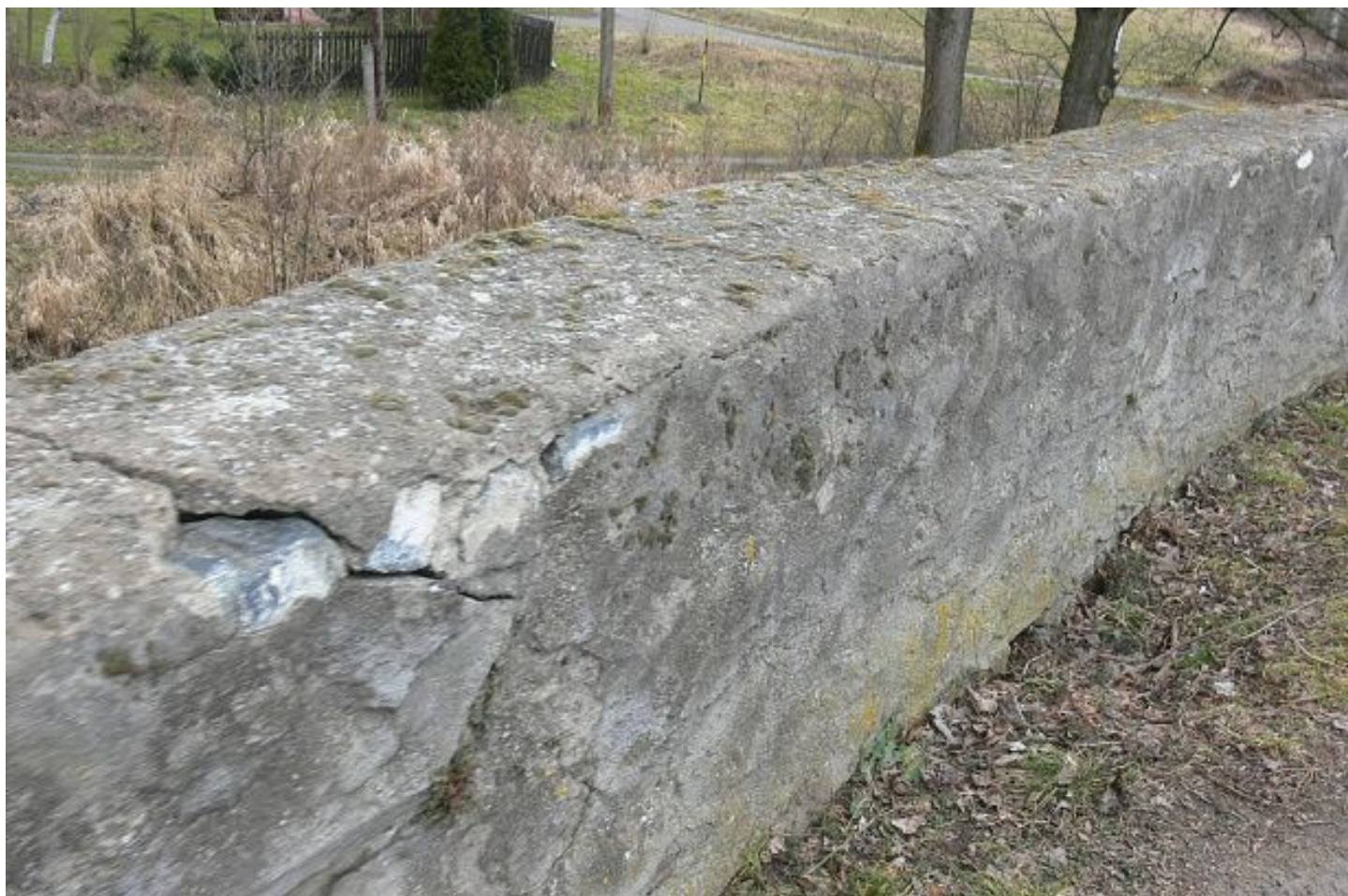
06 detail trhliny ve zdivu parapetní zídky.jpg
