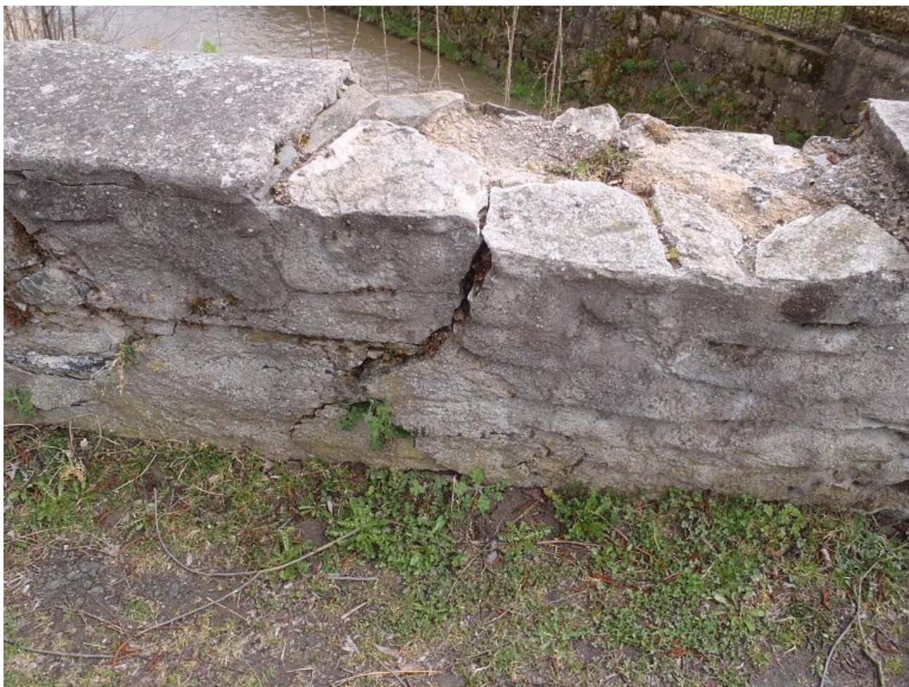
07 detail rozpadu zdiva parapetní zídky.jpg
