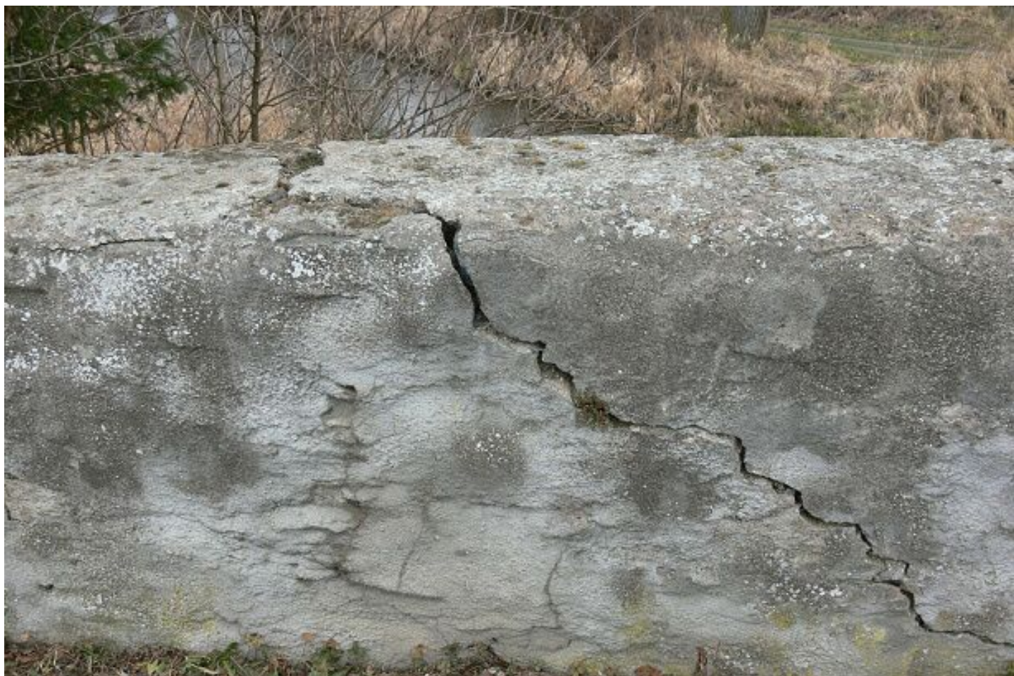
05 detail trhliny ve zdivu parapetní zídky.jpg
