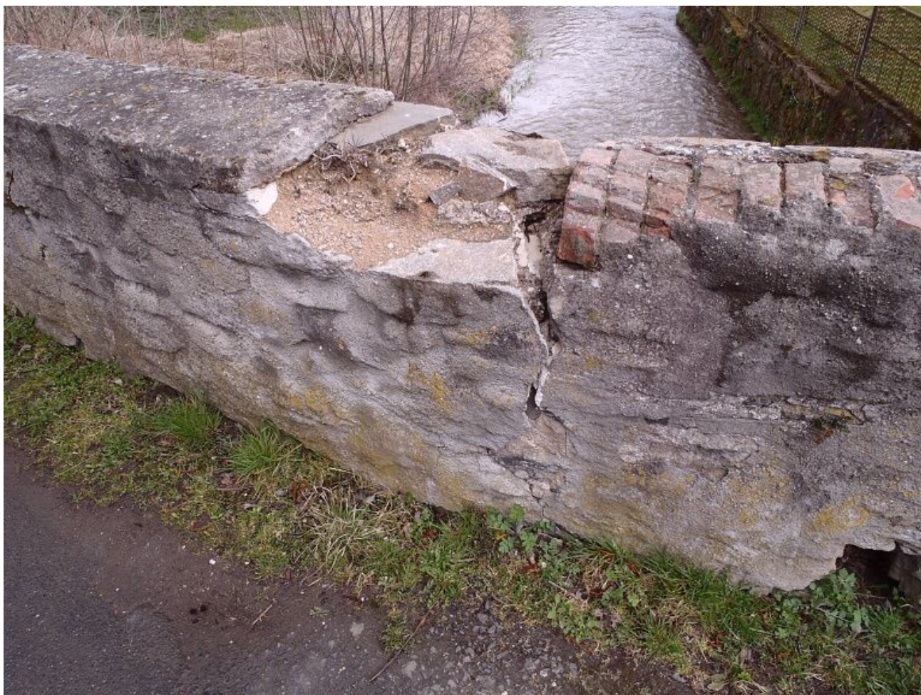
08 detail rozpadu zdiva parapetní zídky.jpg
