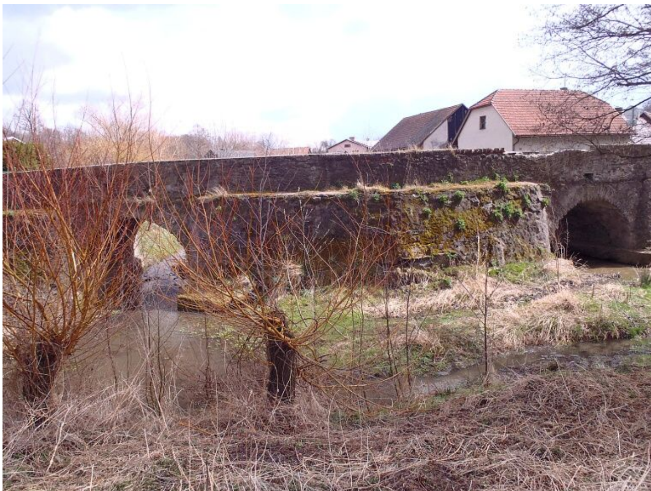
18 propojovací stěna mezi otvory 1 a 2 návodní strana.jpg
