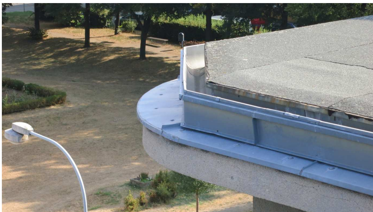
Obr. 21 – oplechování hlavní střešní plochy – zachovat, nepoškodit!
