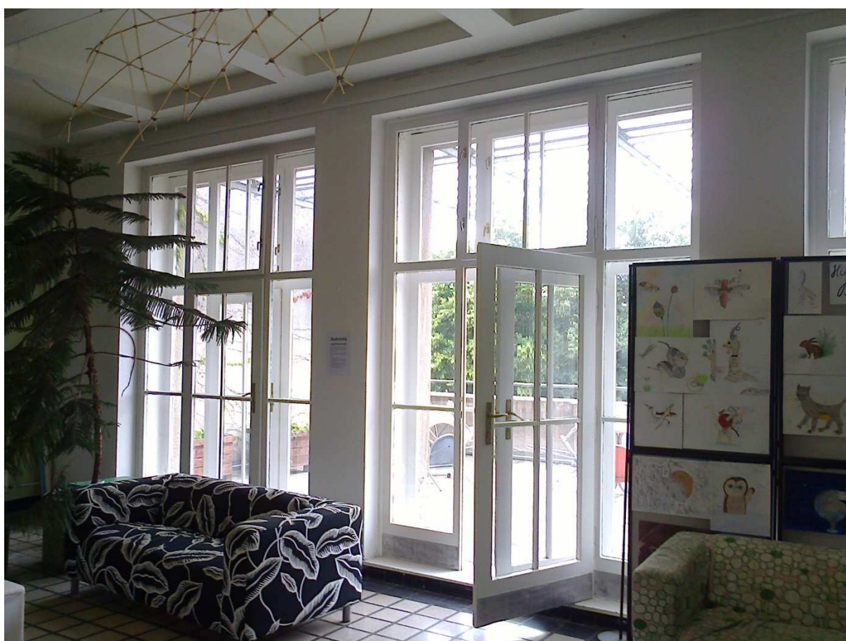
Obr. 28, 29, 30 – příklady stáv. špaletových oken
