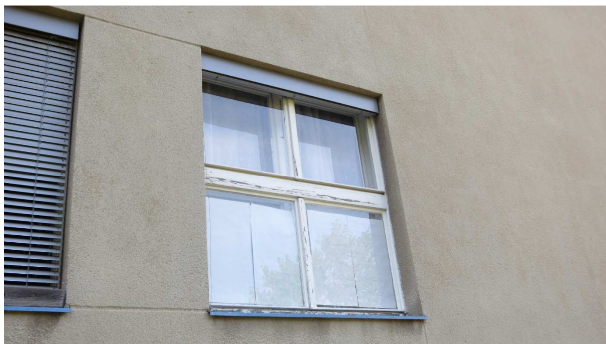
Obr. 11 – původní okno s venkovní žaluzií
