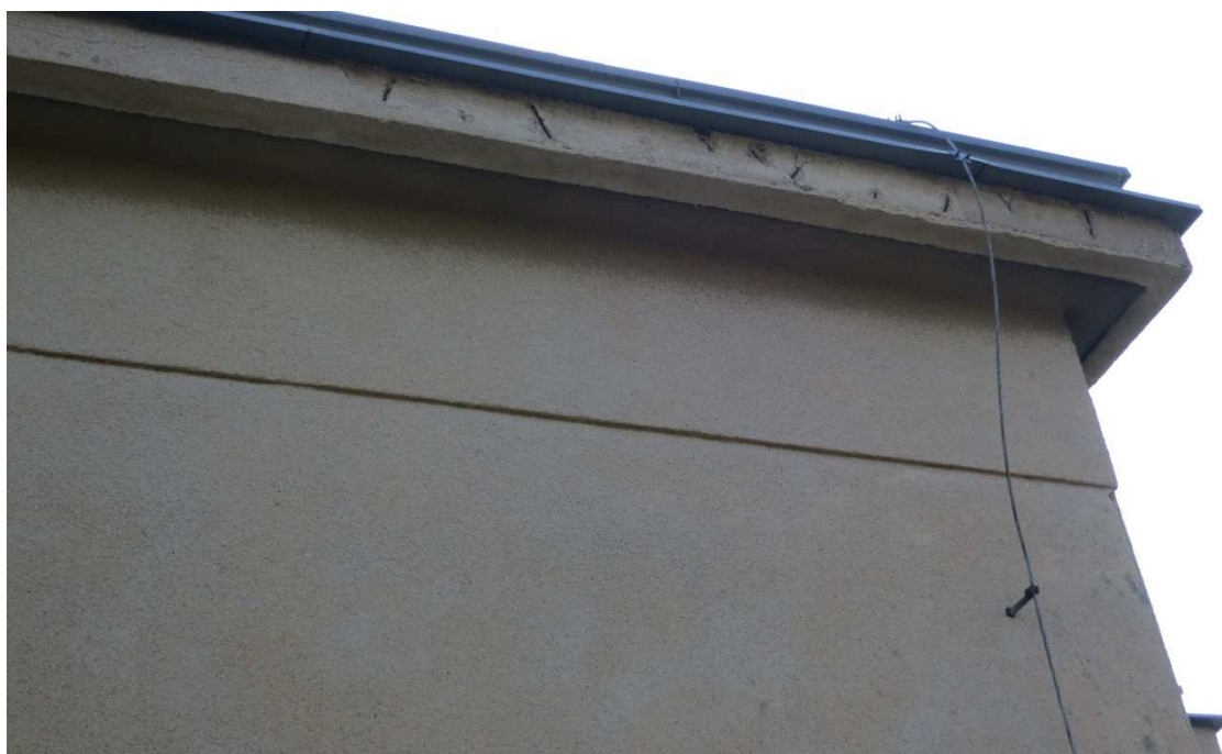
Obr. 16, 17 – poškození ŽB říms, odhalená výztuž detail profilace fasády
