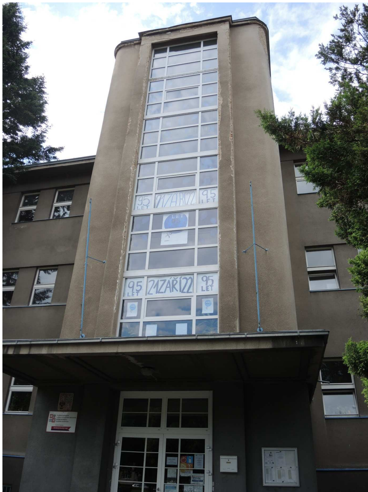
Obr. 3 – centrální věž, hlavní vstup nepůvodní výplně, poškození omítky
