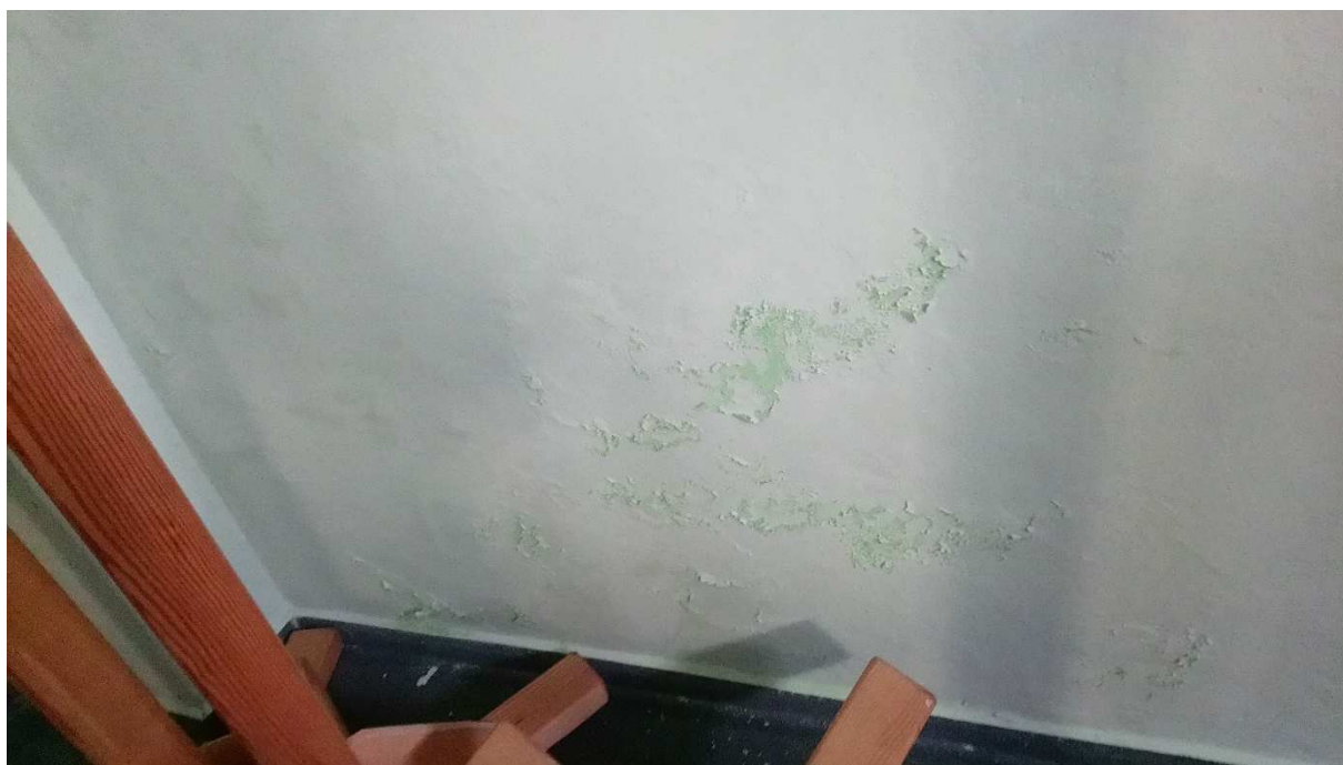
Obr. 23 – vlhké zdivo v interiéru posilovny
