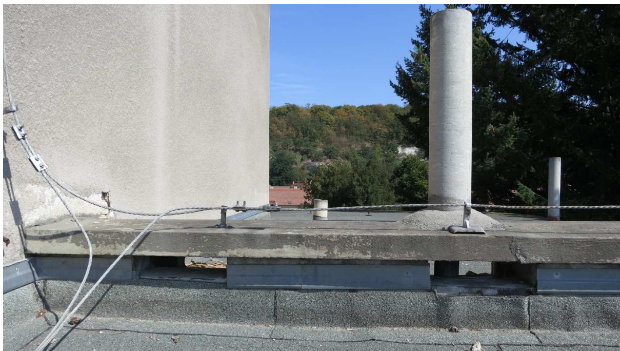
Obr. 37 – vyústění větracích průduchů nad střešní rovinu
