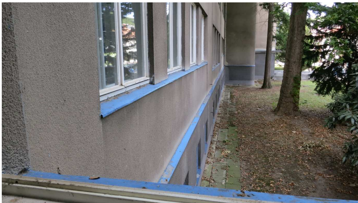
Obr. 20 – detail skupiny oken – ustoupené pilíře a společné oplechování oplechování soklu
