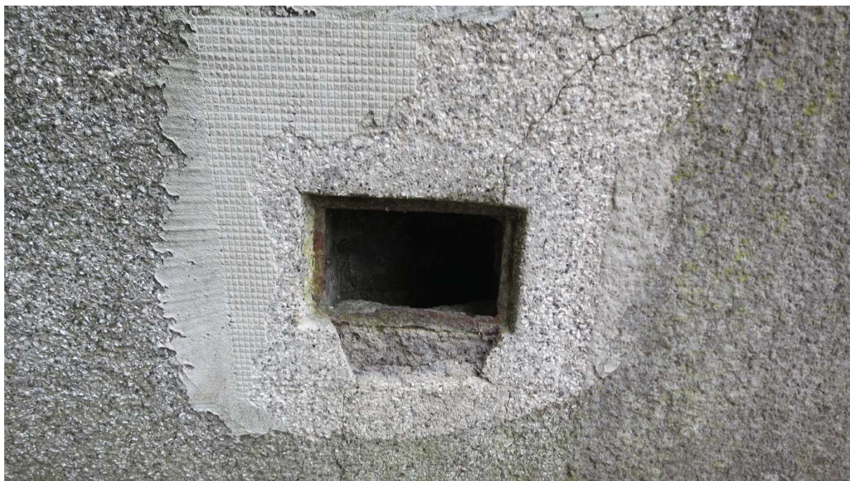
Obr. 26 – větrací otvor soklu vzorek původního teraca
