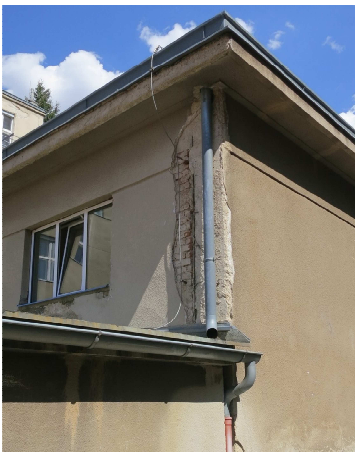
Obr. 13 – poškození fasády tělocvičny, odhalená výztuž ŽB rámu
