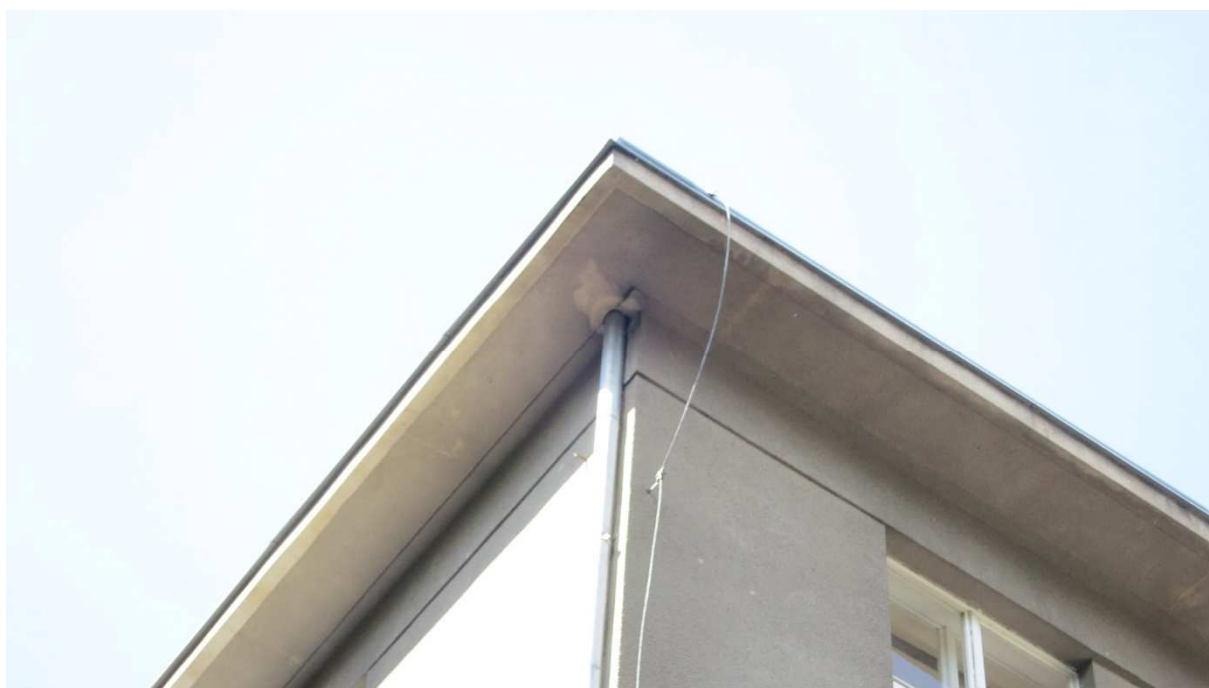
Obr. 14, 15 – spodní profilace korunní římsy, stávající prostupy dešť. svodů
