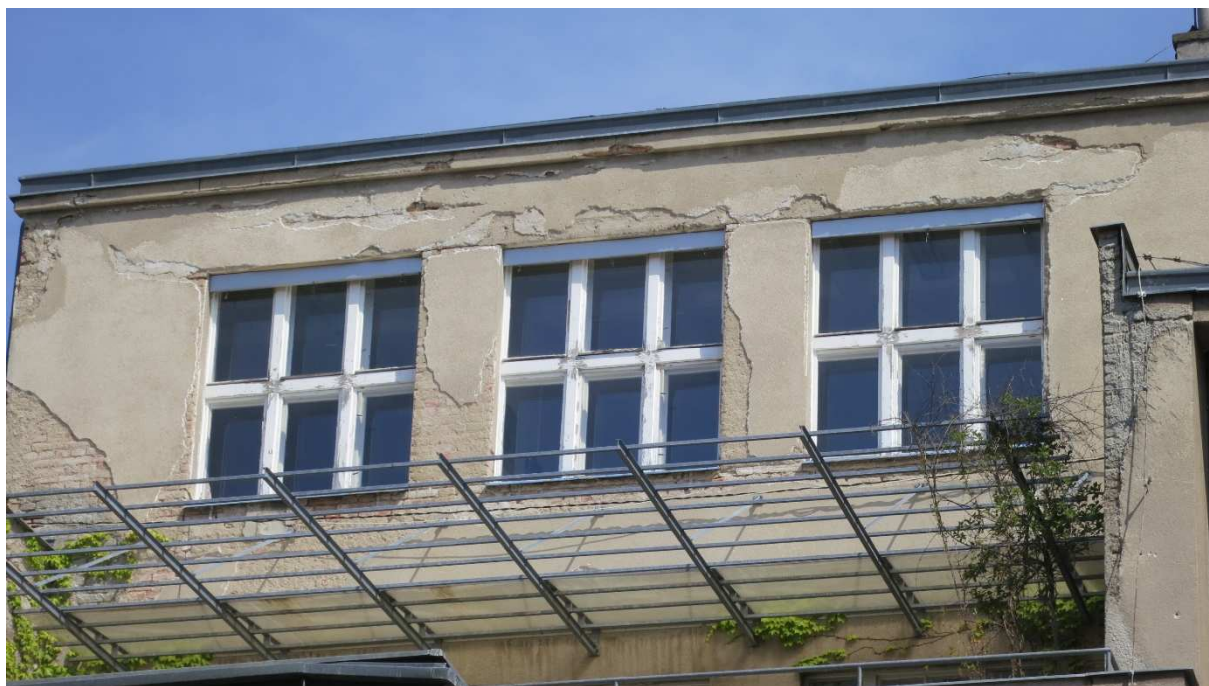
Obr. 8 – poškození omítky a zdiva
