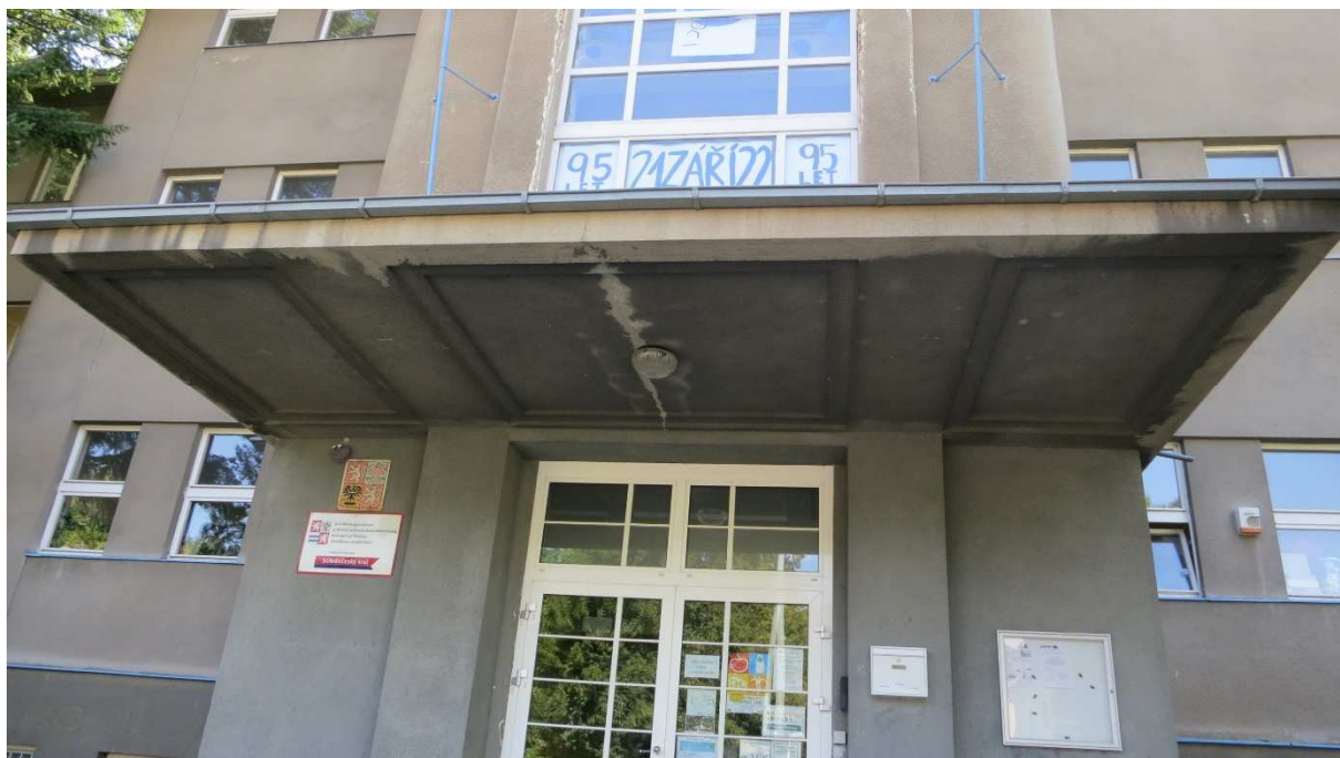
Obr. 4 – detail profilace ŽB markýzy poškození vodou
