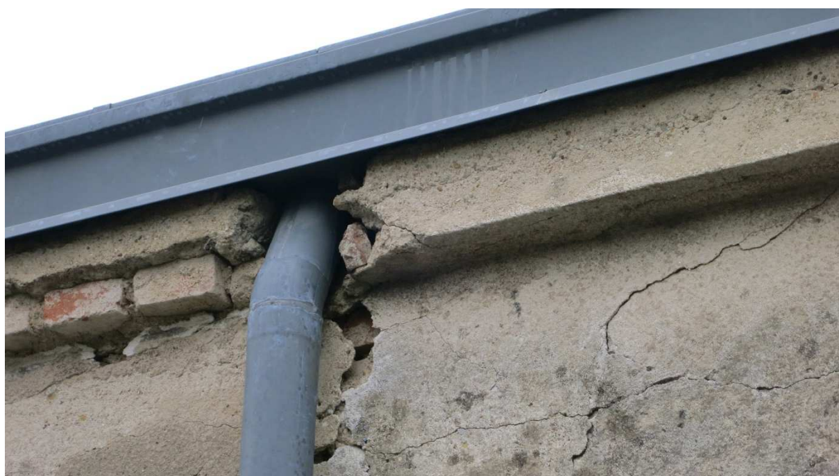
Obr. 38 – prostup římsou „věže“ (střecha 4. NP)
