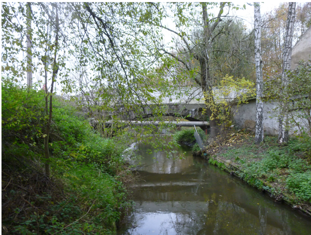
Obrázek IV - Pohled levou stranu ve směru staničení, samonosná chránička vodovodu a vzrostlý jasan
