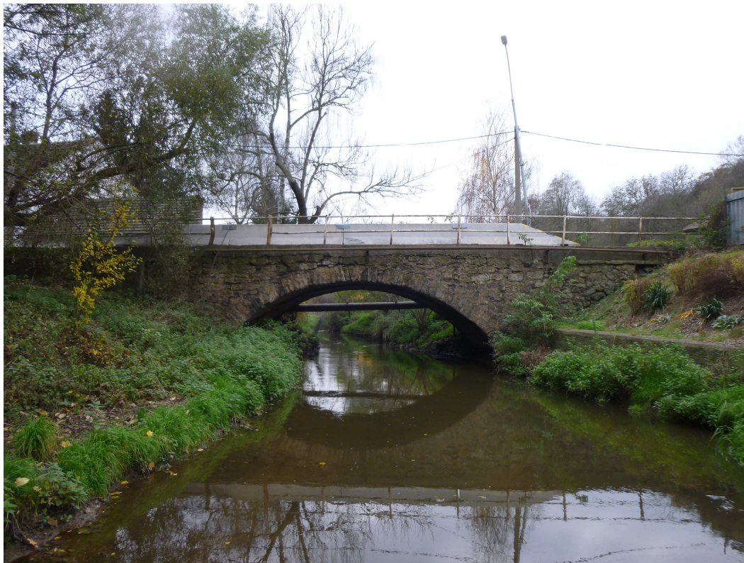
Obrázek III – Pohled pravou stranu ve směru staničení, navazující zídka a chránička telefonního kabelu
