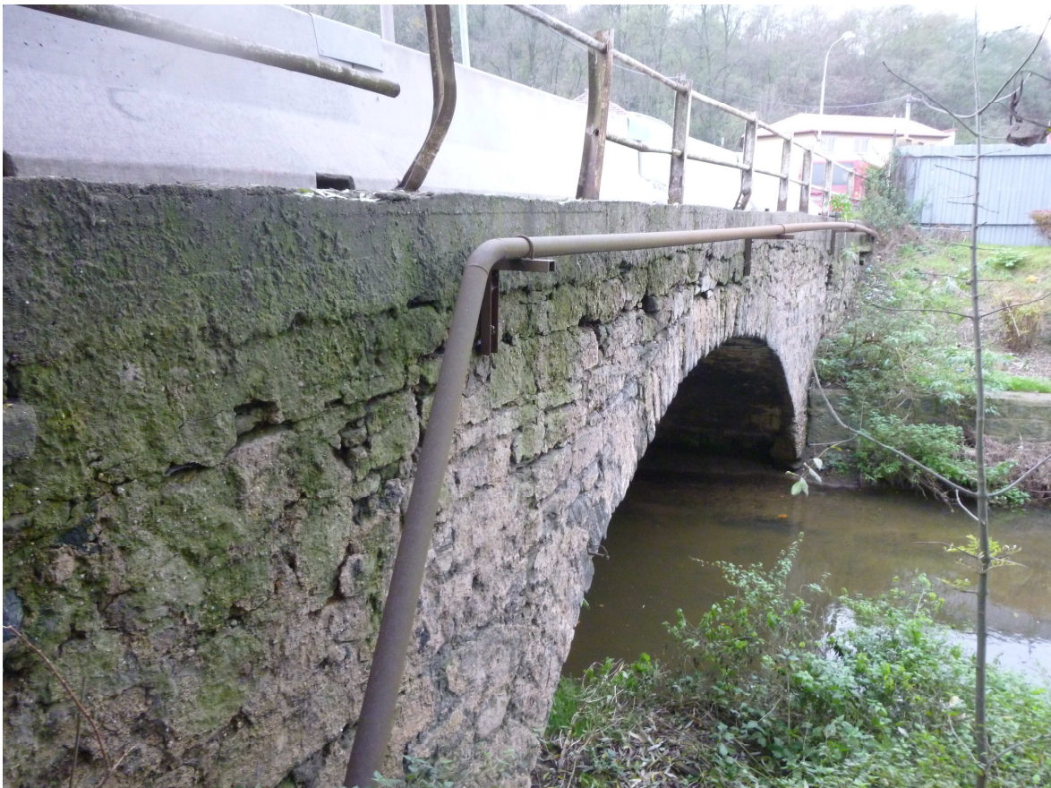
Obrázek VI - Detail chráničky telefonního kabelu
