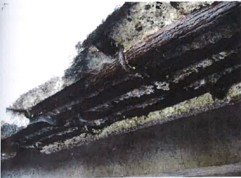
Poškozený nosník.
