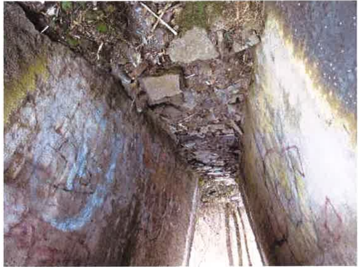
pohled do mostního otvoru
