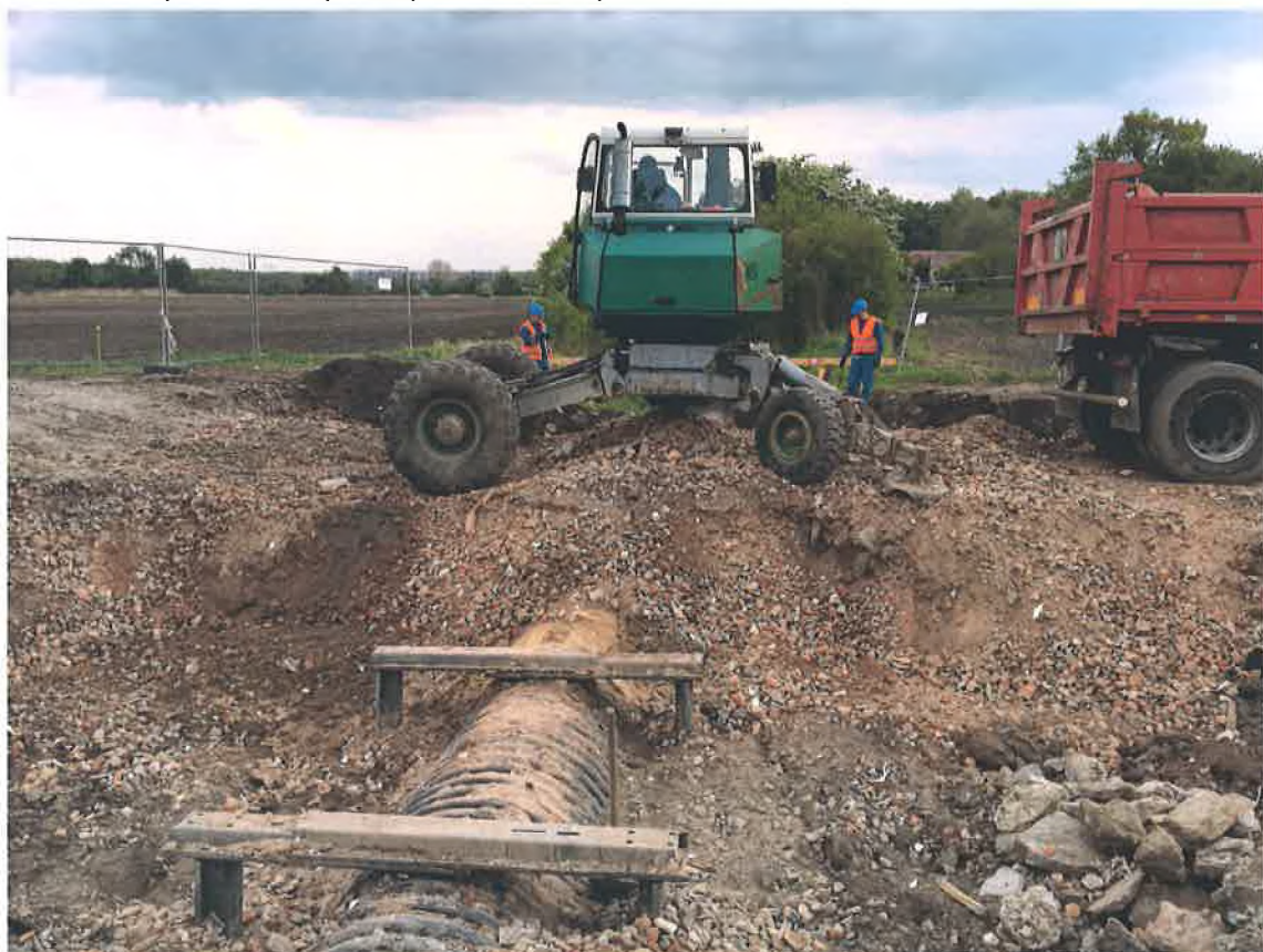
Odstraňování provizorního zásypu, odhalené zatrubnění vodoteče
