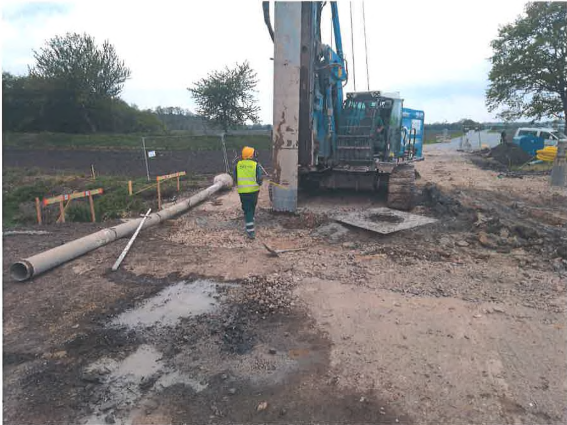
Využití zásypu pro přejezd vrtné soupravy
