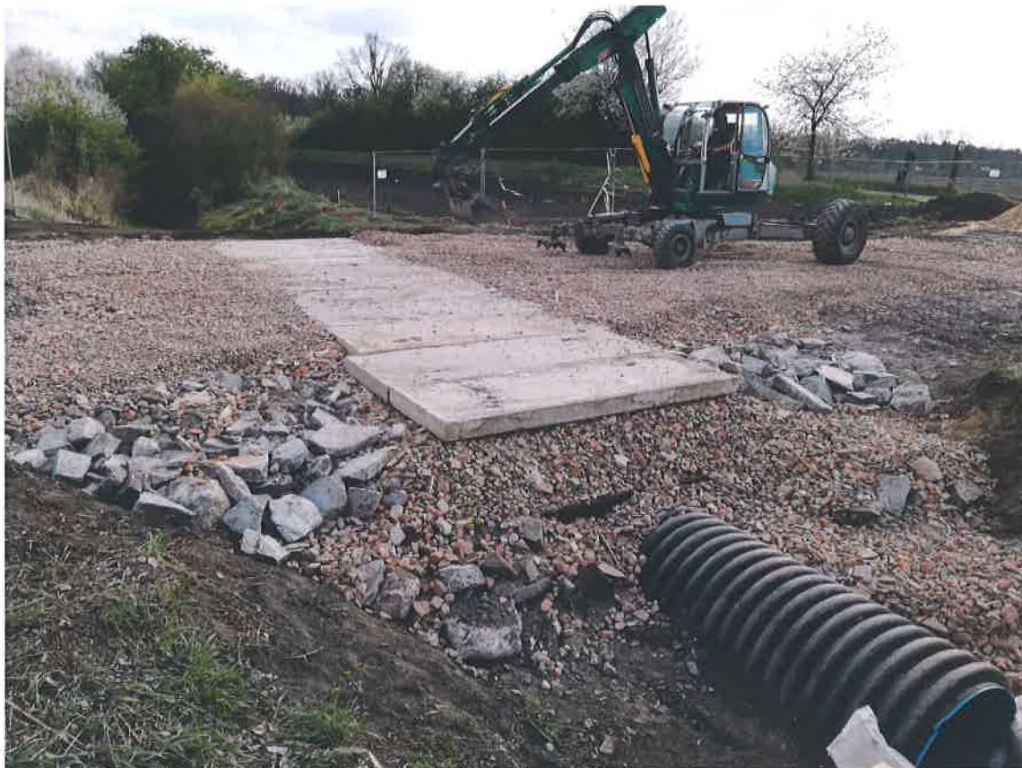
Dokončená plocha z recyklátu po odbourání původního mostu
