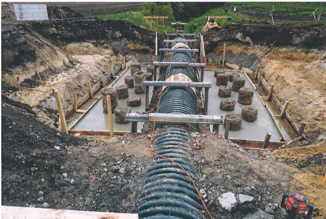
Základy mostu po odstranění zásypu
