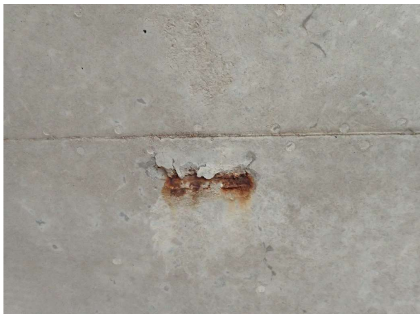
Obrázek č. 11: Korodující pomocné pruty výztuže u povrchu stěn – vlevo úpalek výztuže použitý zřejmě jako podkladek, vpravo narušení povrchu od koroze nedostatečně ošetřené spínací tyče bednění
