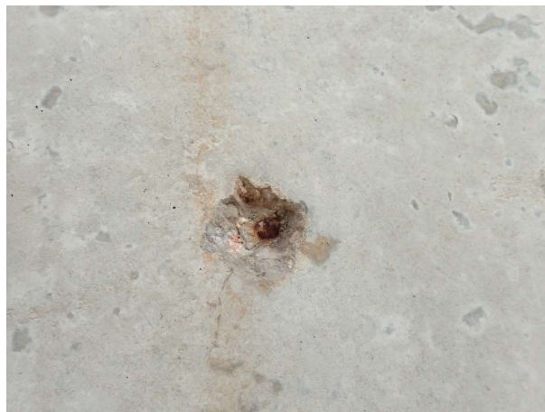
Obrázek č. 11: Korodující pomocné pruty výztuže u povrchu stěn – vlevo úpalek výztuže použitý zřejmě jako podkladek, vpravo narušení povrchu od koroze nedostatečně ošetřené spínací tyče bednění
