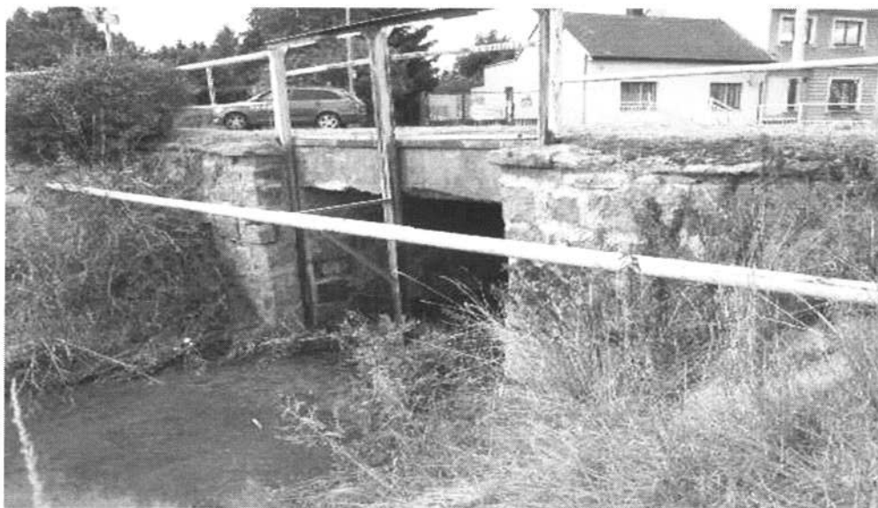
Most 191-002 – pohled na vtokový objekt
