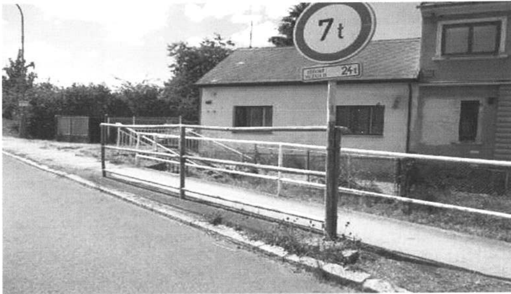
Most 191-002 – pohled na lávku – již uzavřena pro pěší
