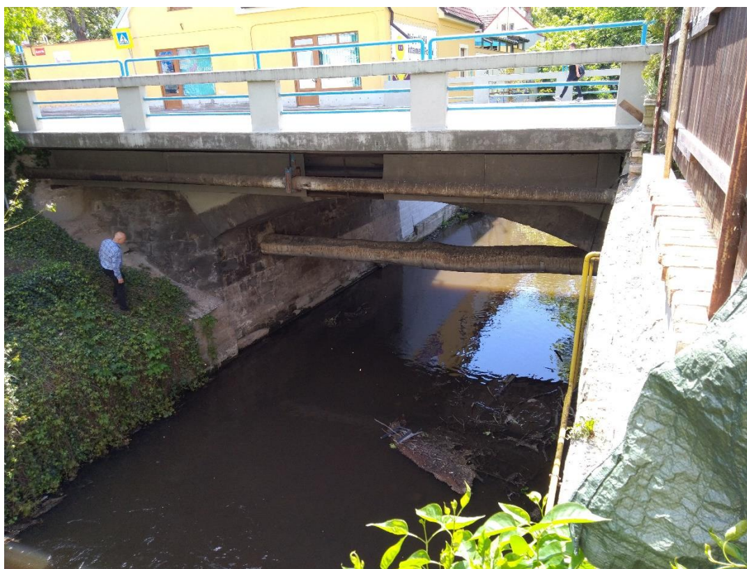
Pohled na zábradlí a sesunutý svah u opěry 2
