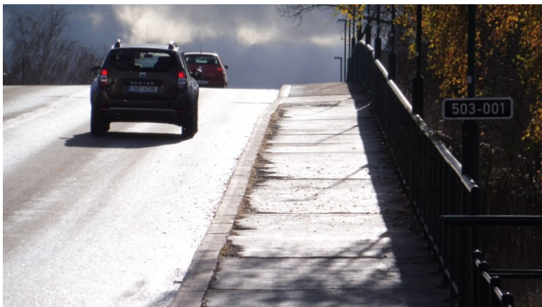
503-001 Nymburk přes ČD Pohled na most – chodníky vpravo.
