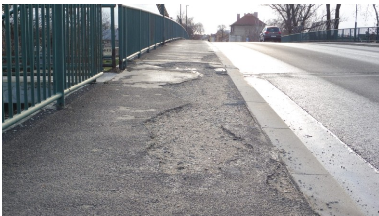
503-001 Nymburk přes ČD Pohled na most – chodníky vlevo.
