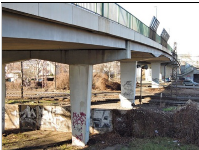
pohled na levou stranu - přechod prefa-monolit, proti směru staničení
