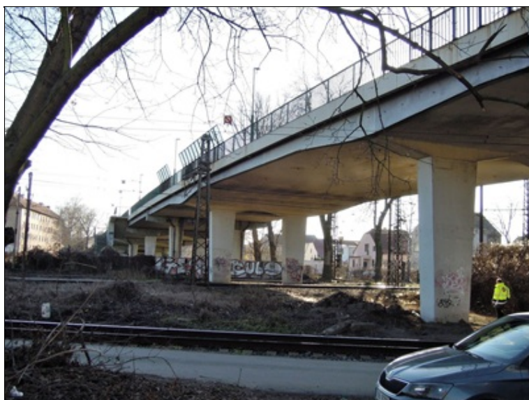
pohled na levou stranu - monolitická část po směru staničení
