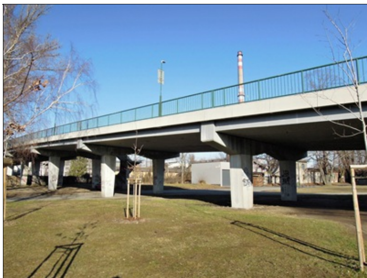
pohled na pravou stranu - konec mostu
