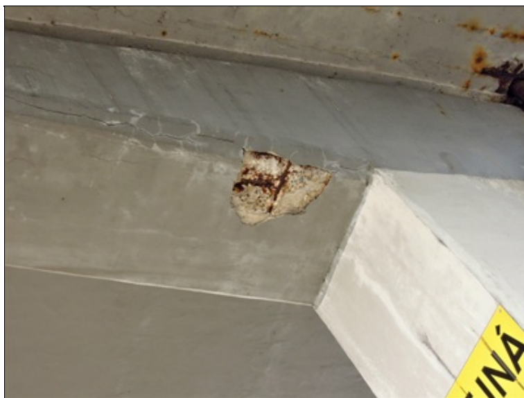
obnažená korodující výztuž na spodním líci stativa, poruchy sanace
