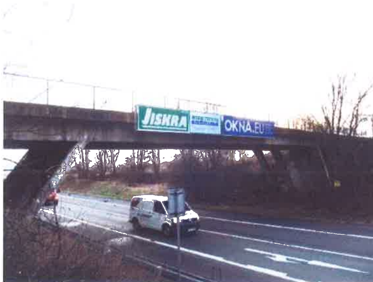
Pohled na most z levé strany
