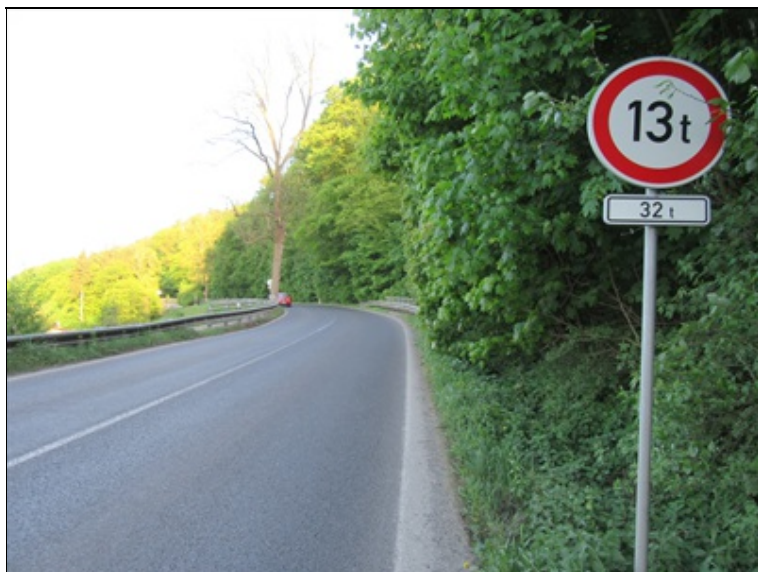
Pohled po směru staničení
