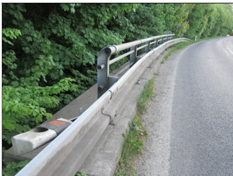
PS konec mostu poškozený nástavec vodícího sloupku
