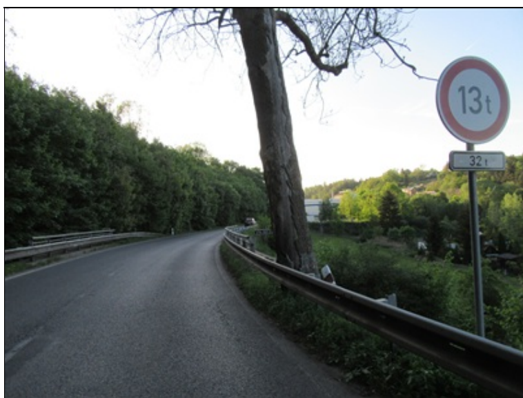
Pohled proti směru staničení
